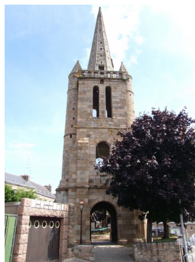
Vue générale ouest Phot. Patrick Pichouron IVR53_20102210023NUCA
