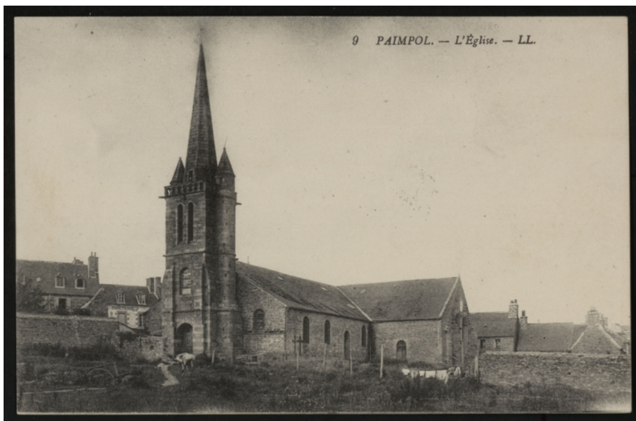
Vue générale avant destruction, 1er quart du 20ème siècle (AD 22)
