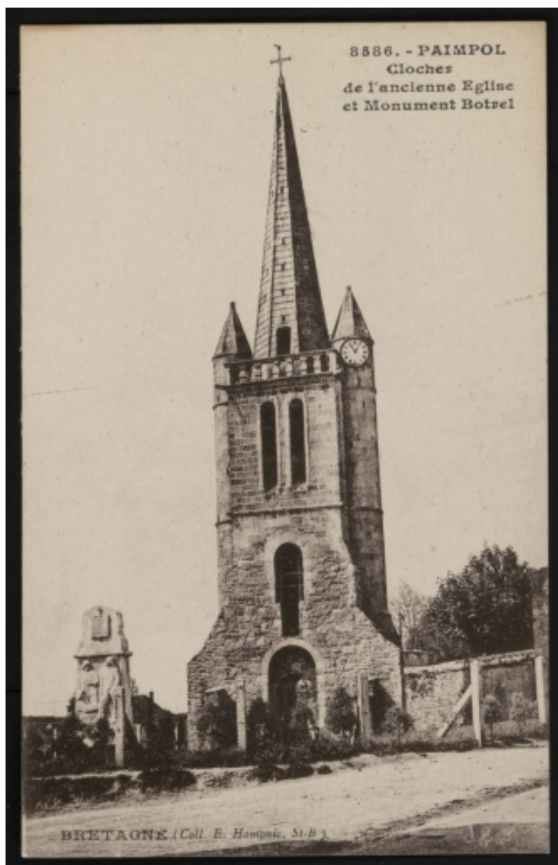
Vue générale après destruction, 1er quart du 20ème siècle (AD 22)
