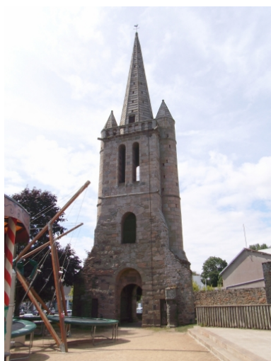
Vue générale est Phot. Patrick Pichouron IVR53_20102210384NUCA
