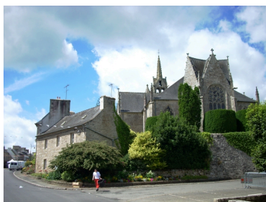
Guerlesquin, église paroissiale Saint-Thénéan : vue générale sud-est Phot. Gwénaél Fauchille IVR53_20082906654NUCA
