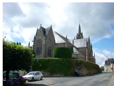
Guerlesquin, église paroissiale Saint-Thénéan : vue générale nord-est Phot. Gwénaél Fauchille IVR53_20082906655NUCA
