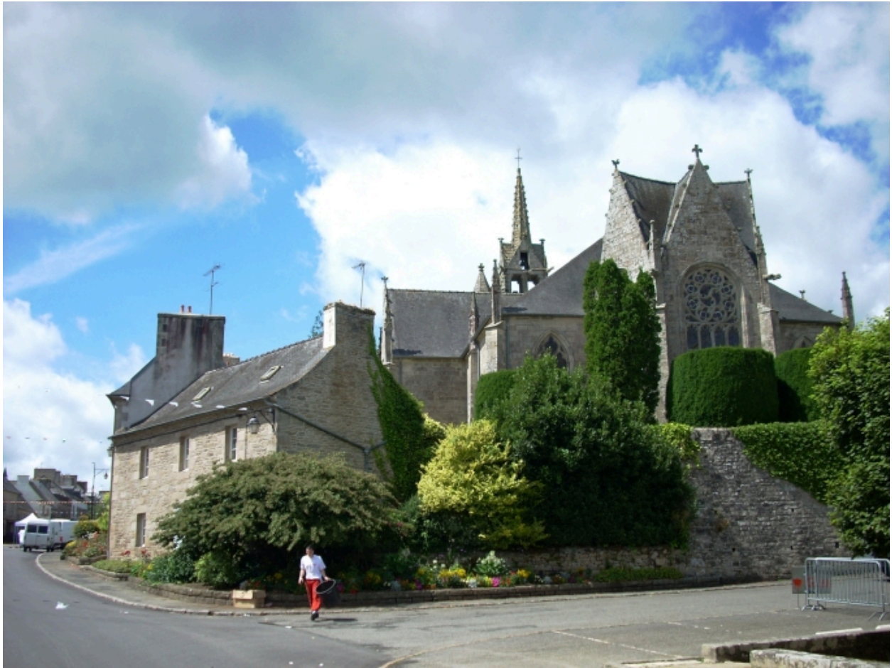
Guerlesquin, église paroissiale Saint-Thénéan : vue générale sud-est
