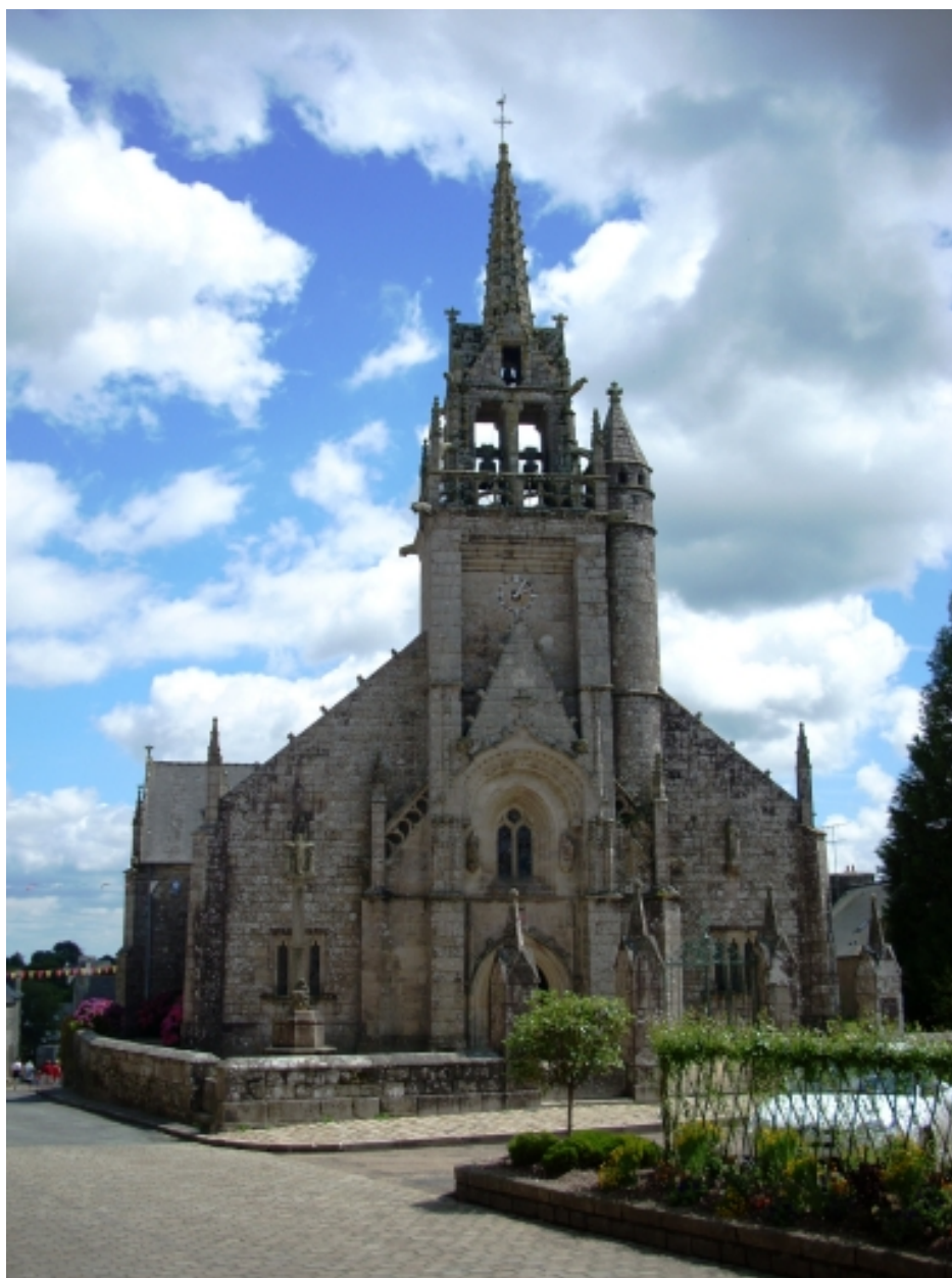
Guerlesquin, église paroissiale Saint-Thénéan : vue générale ouest
