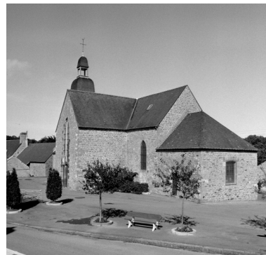
Elévation Est : vue générale Phot. Guy Artur, Phot. Norbert Lambart IVR53_19943501823X
