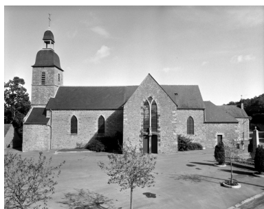
Elévation Sud : vue générale Phot. Guy Artur, Phot. Norbert Lambart IVR53_19943501822X
