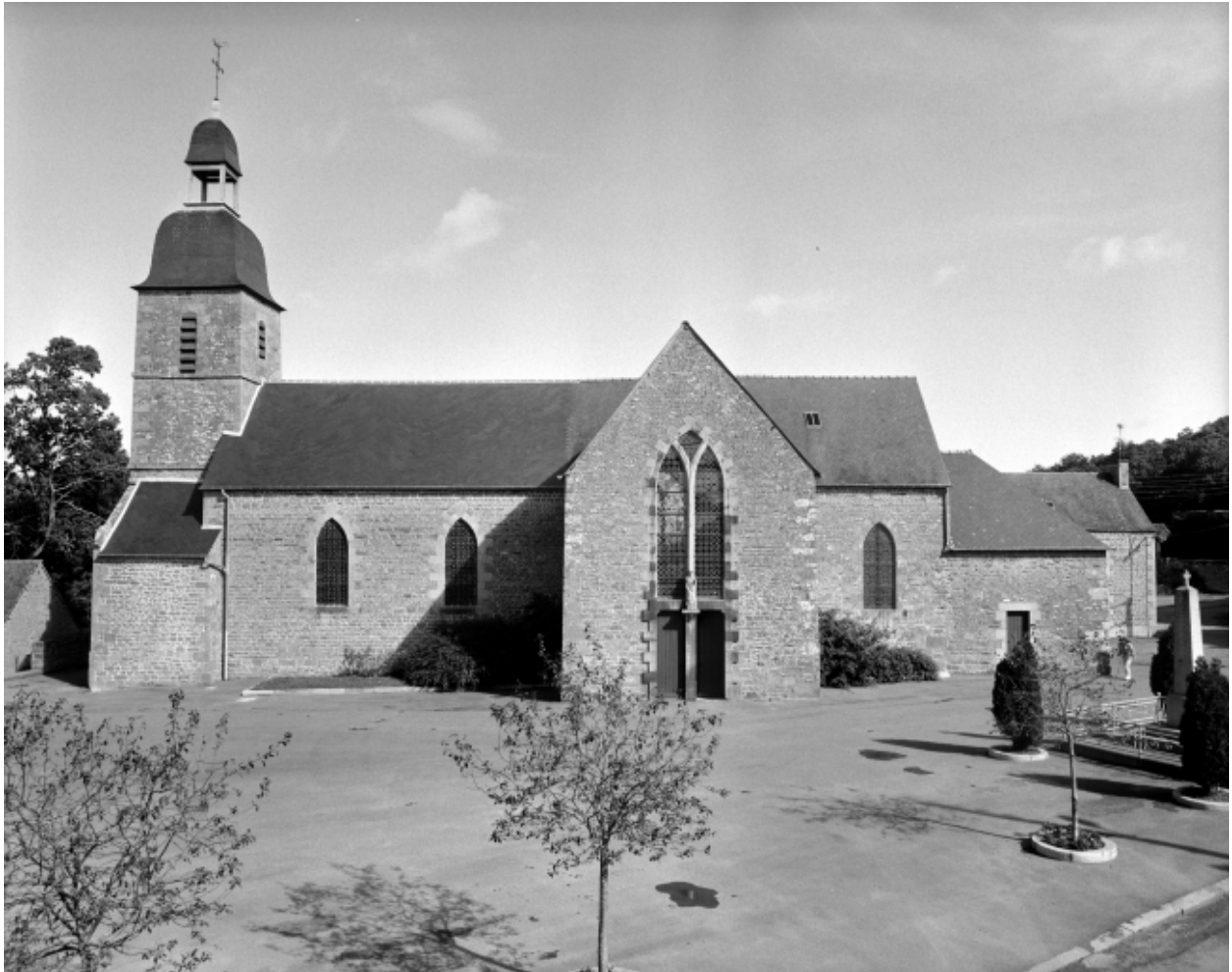
Elévation Sud : vue générale
