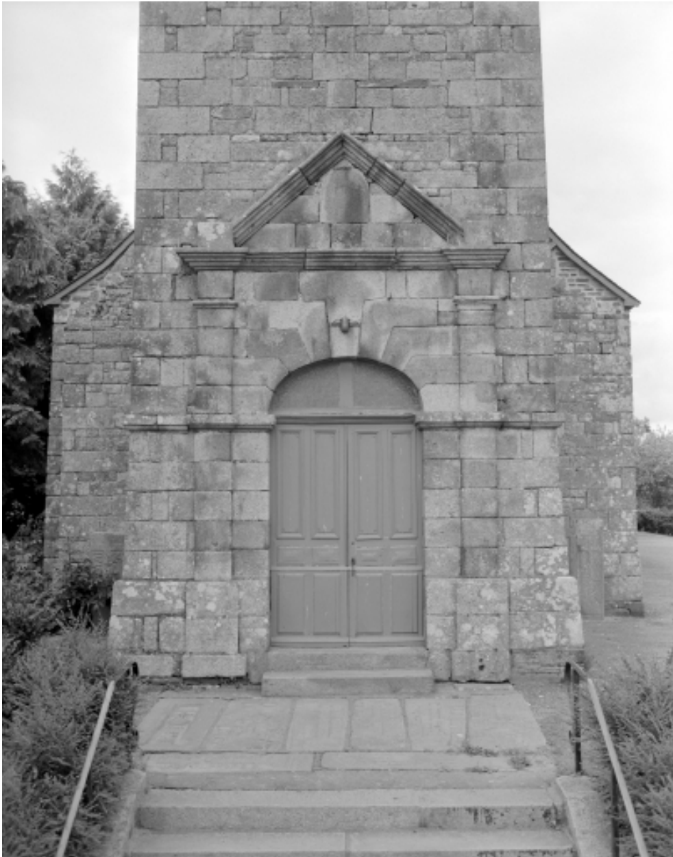
Elévation Ouest, porte principale : vue générale
