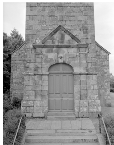
Elévation Ouest, porte principale : vue générale Phot. Guy Artur, Phot. Norbert Lambart IVR53_19943501273X
