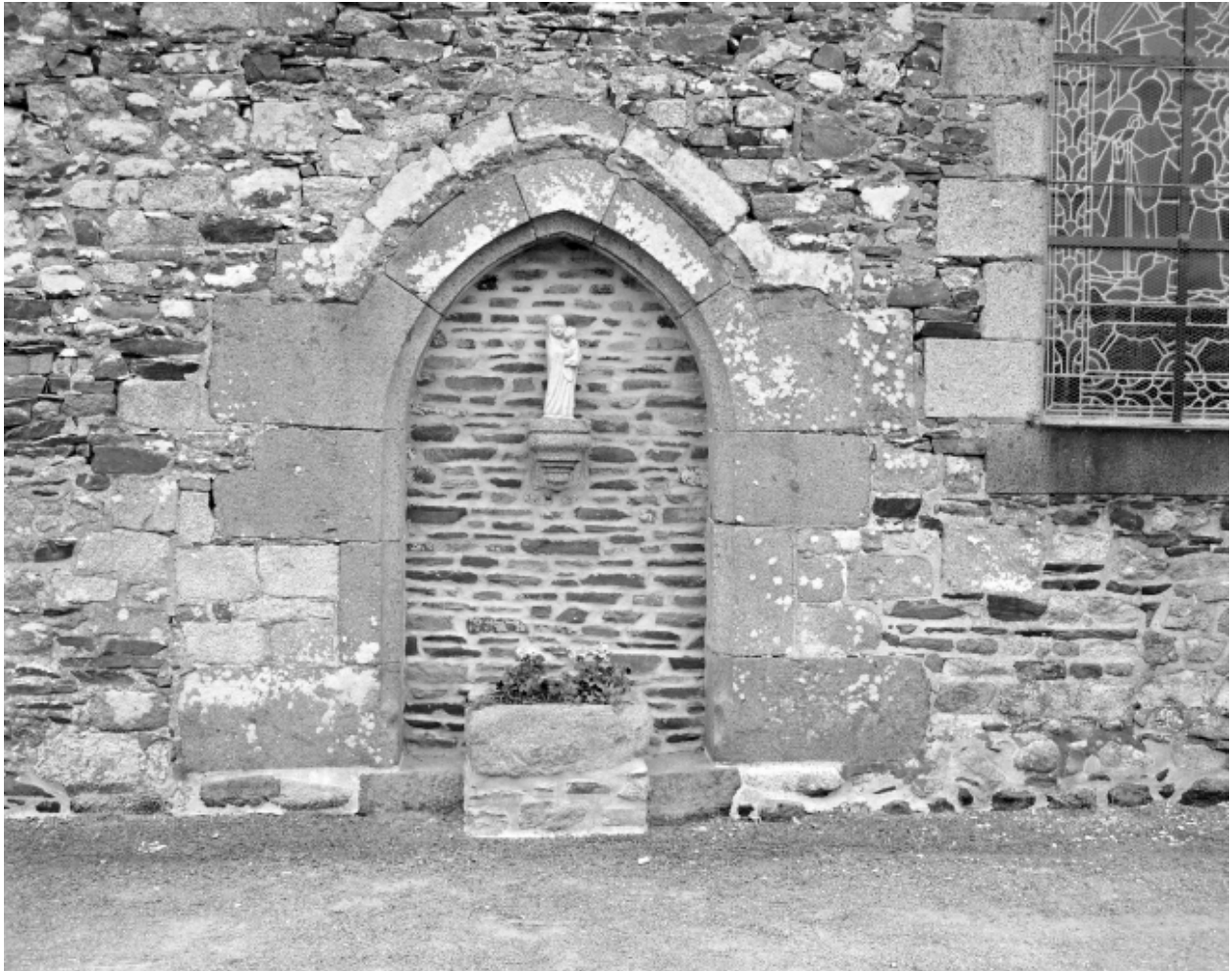
Elévation Sud, porte : vue générale
