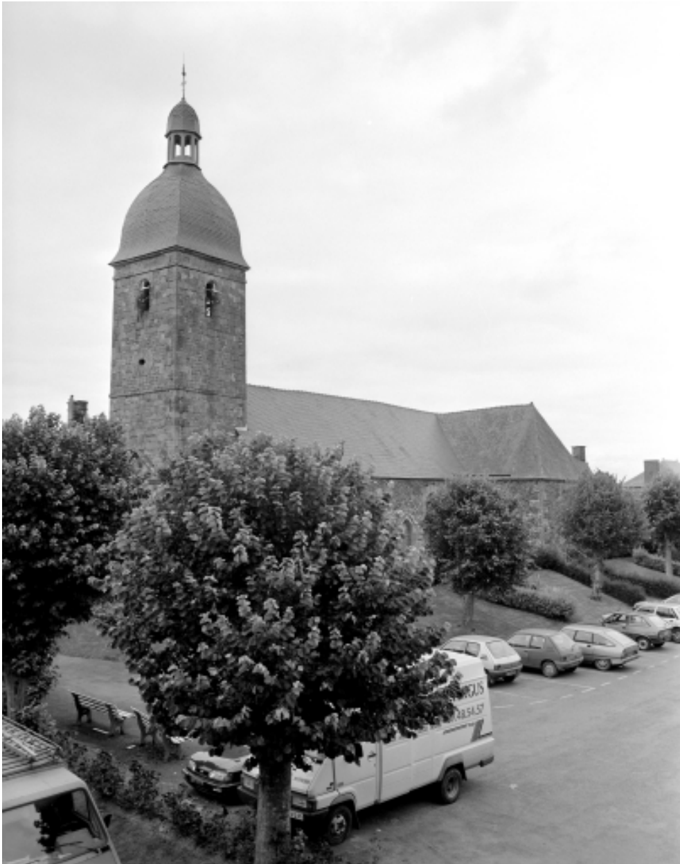
Elévation Sud-Ouest : vue générale
