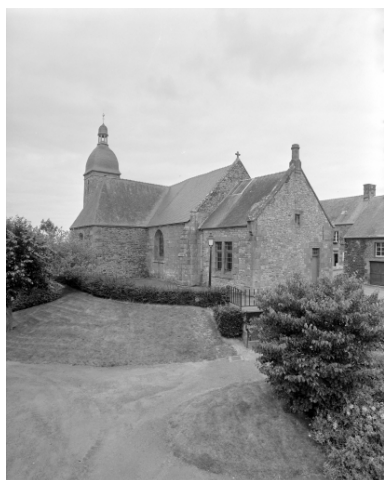
Elévation Sud-Est : vue générale Phot. Guy Artur, Phot. Norbert Lambart IVR53_19943501270X
