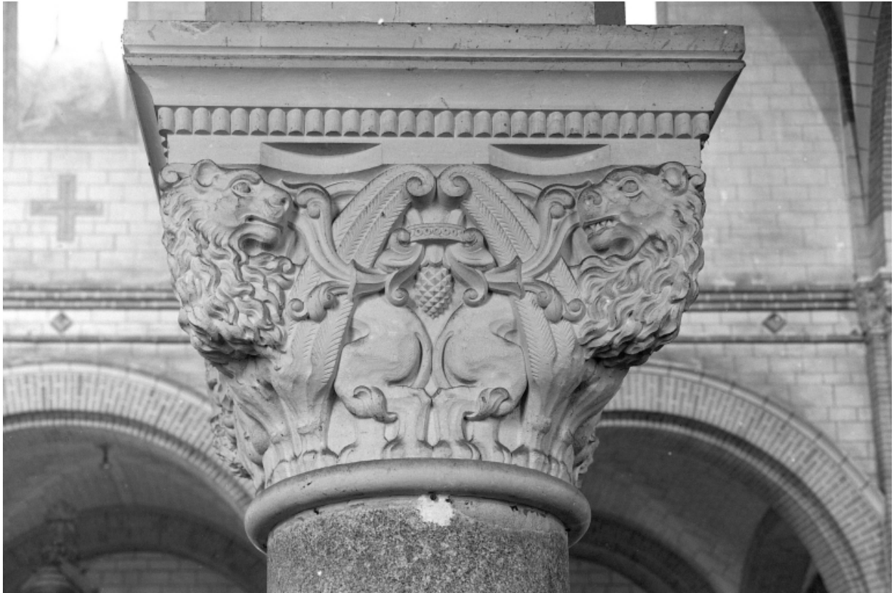
Chapiteau de la nef, 5ème pile sud, face sud.
