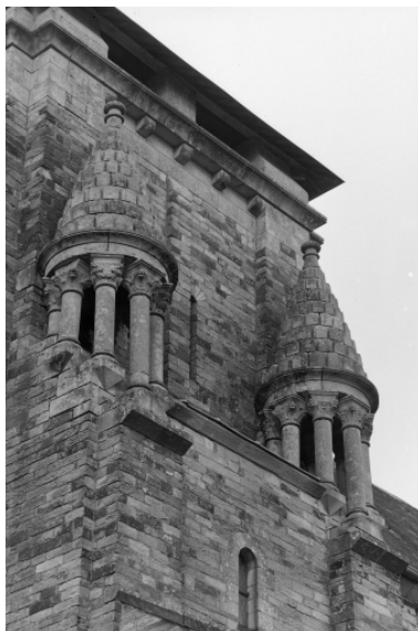
Clocheton sud de la tour, vue de détail. Phot. Gaudin IVR53_19703500113V
