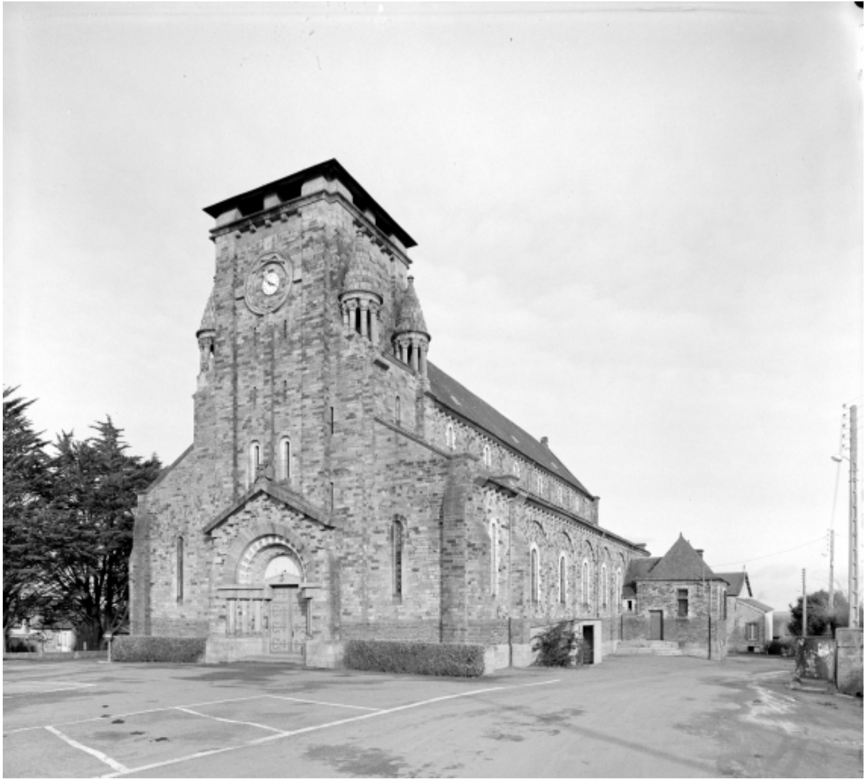
Elévation Sud-Ouest : vue générale
