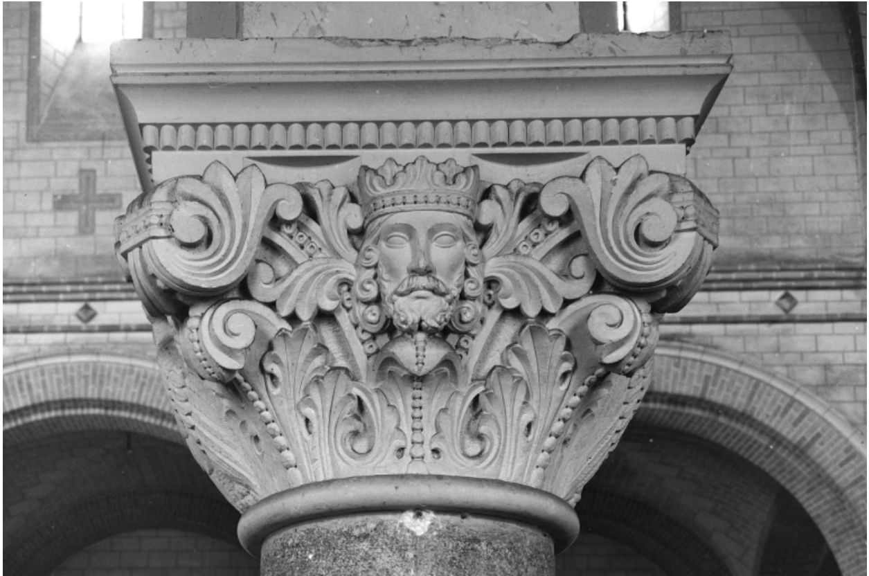
Chapiteau de la nef, 3ème pile sud, face sud.
