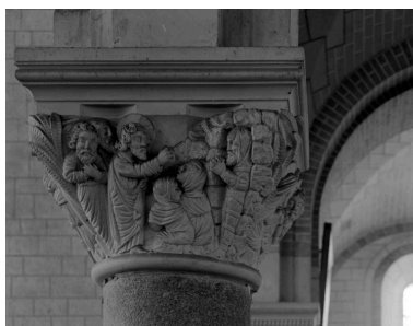
Chapiteau de la nef, 2ème pile nord, face est, résurrection de Lazare. Phot. Guy Artur IVR53_19703500074X
