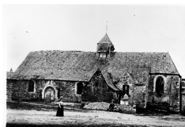
Ancienne église, élévation Sud : vue générale (Repro.coll.de Le Rivière Chereil) Repro. François Dagorn IVR53_19703501414V
