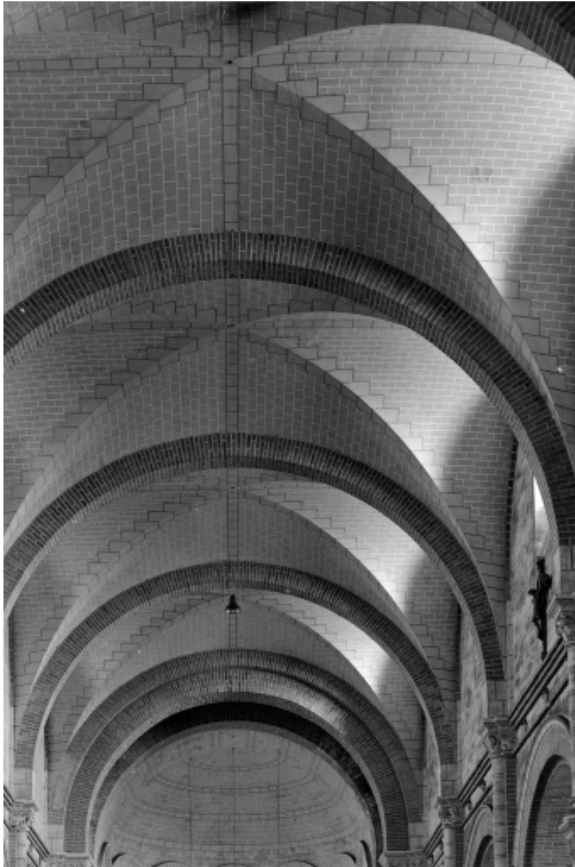
Voûtement de la nef, vue générale.
