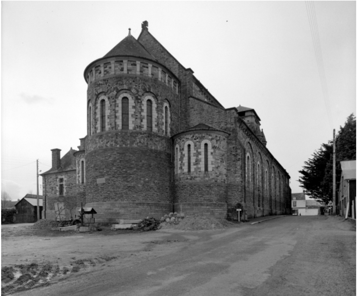
Elévation Nord-Est : vue générale
