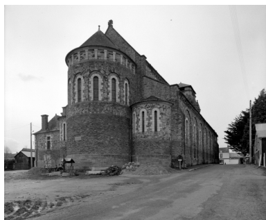
Elévation Nord-Est : vue générale Phot. Gaudin IVR53_19703500050V
