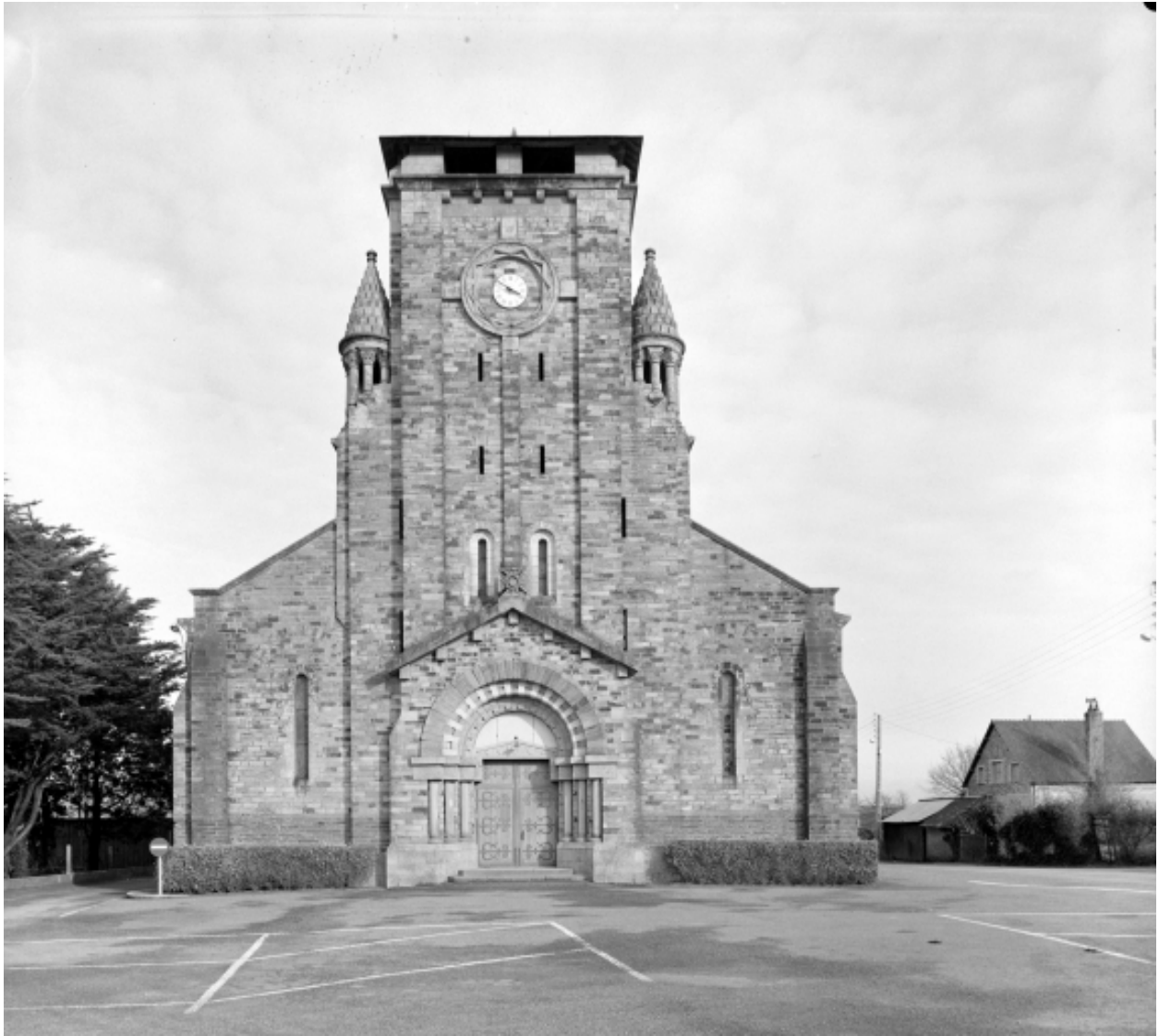
Elévation Ouest : vue générale
