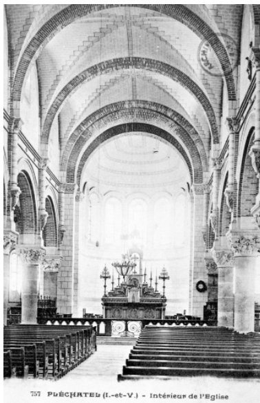
Carte postale ancienne - Intérieur : vue générale vers le choeur. Repro. Guy Artur, Repro. Norbert Lambart IVR53_19933500828X
