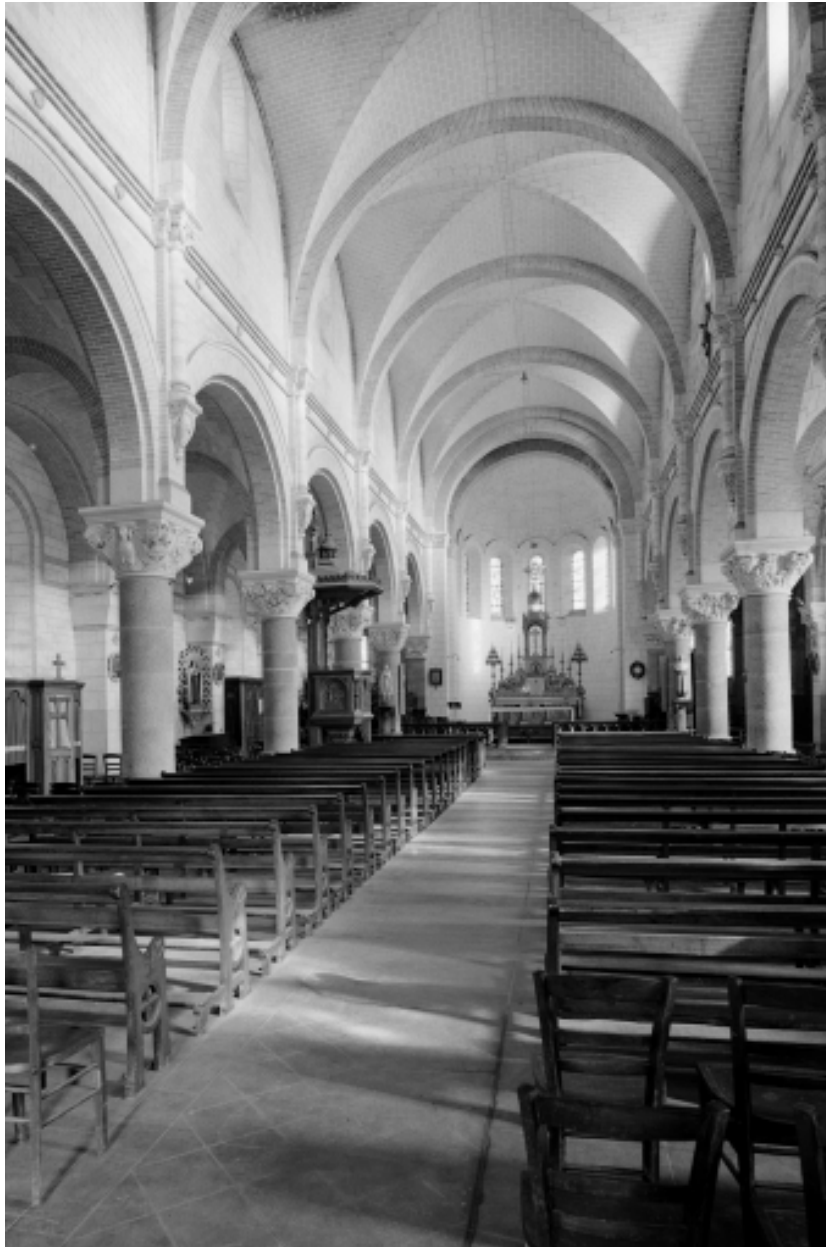
Intérieur : vue générale vers le chœur.
