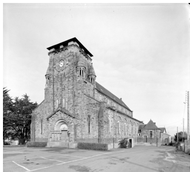
Elévation Sud-Ouest : vue générale Phot. Guy Artur IVR53_19703500053V
