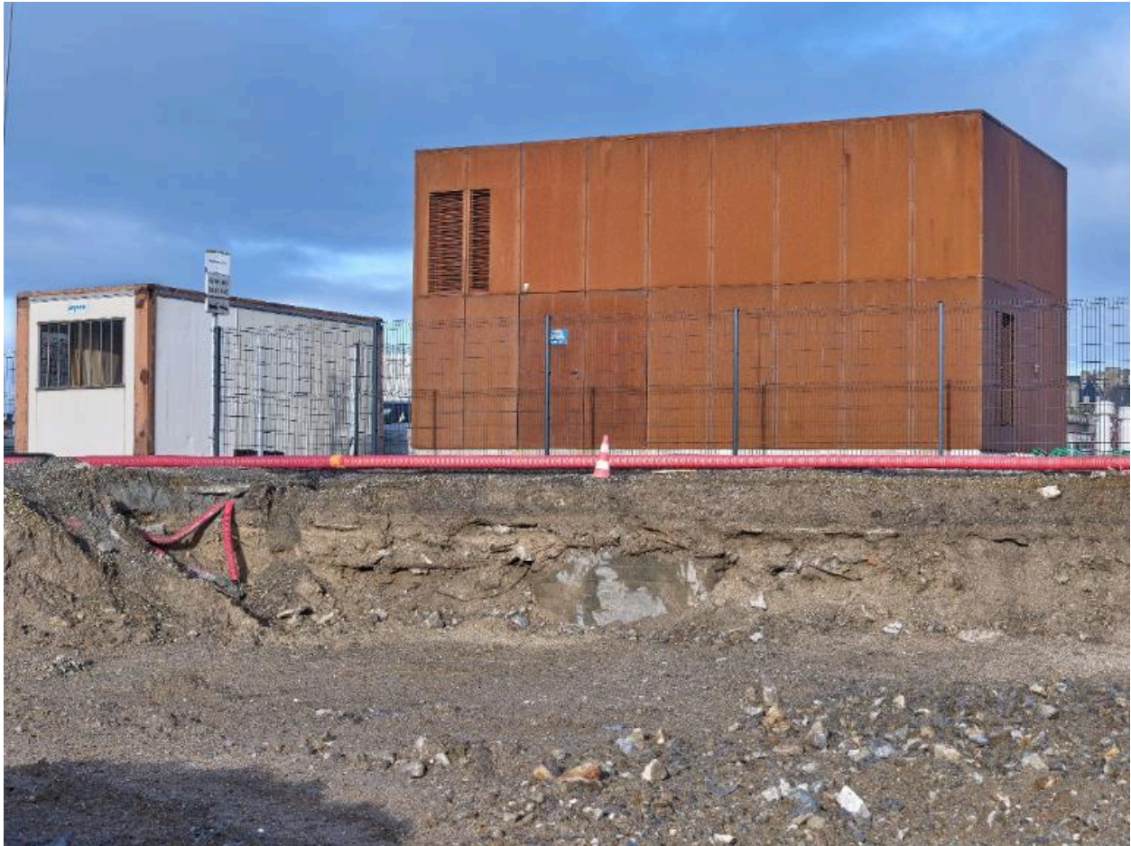
Vue de situation depuis le sud du bunker-abri-magasin de munitions de type L 401a avec cuve pour canon antiaérien (II) (couverture photographique du 22 janvier 2026)
