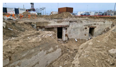
Vue est du bunker-abri-magasin de munitions de type L 401a avec cuve pour canon antiaérien (III) (couverture photographique du 17 décembre 2025). Au premier plan à gauche, le quai de l'avant-port de Saint-Servan : il est construit en maçonnerie de pierre de taille de granite Phot. Guillaume Lécullier IVR53_20263510056NUCA
