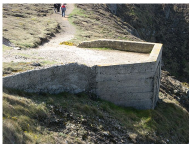
Parapet du poste de chargement de galets Phot. Guillaume Marie IVR53_20082908310NUCA
