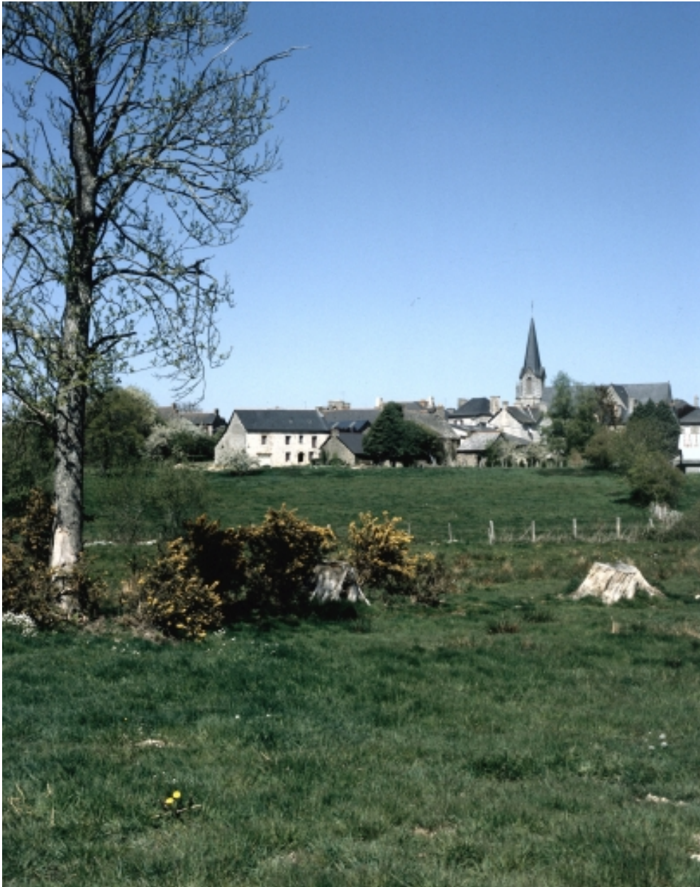
Vue de situation de l'église.
