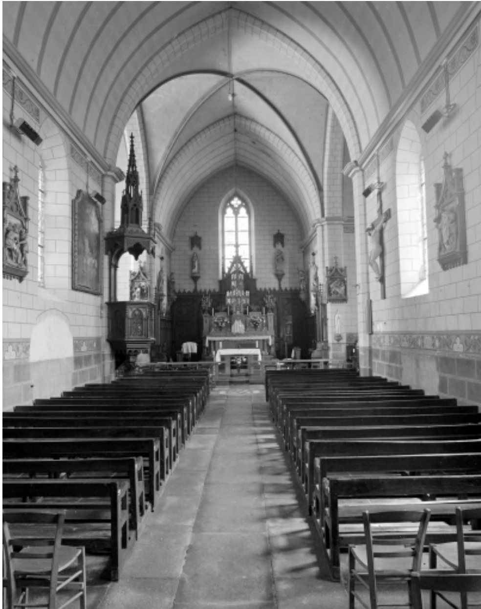
Elévation ouest : vue générale
