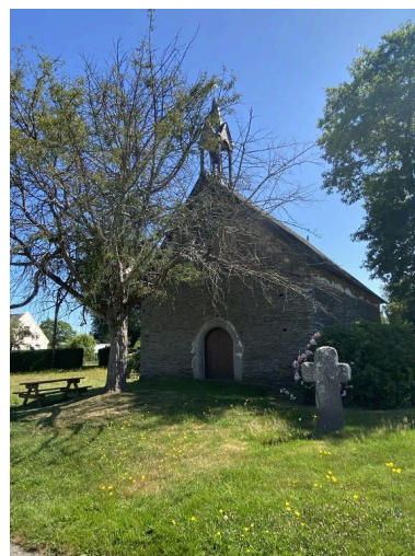
Vue ouest Phot. Baptiste Oligo IVR53_20255610988NUCA
