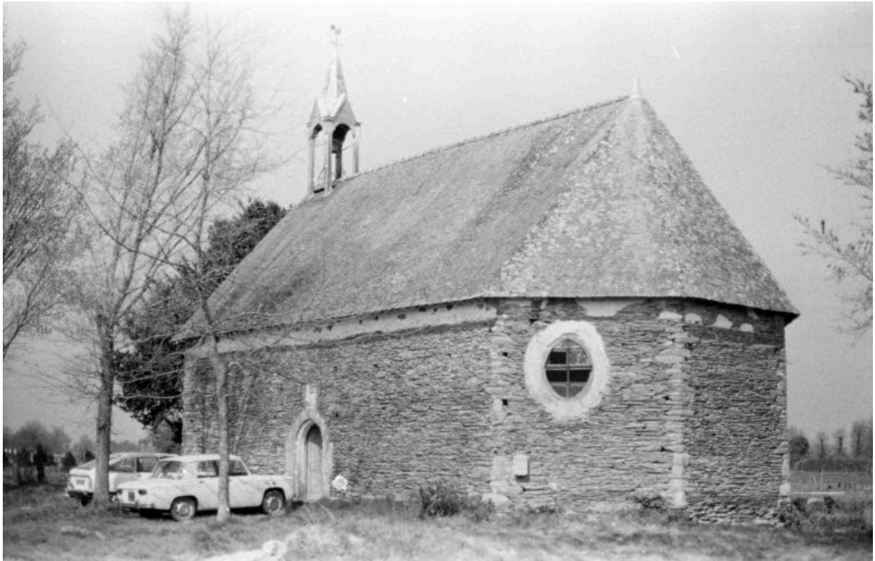
Vue du chevet (état en 1984)
