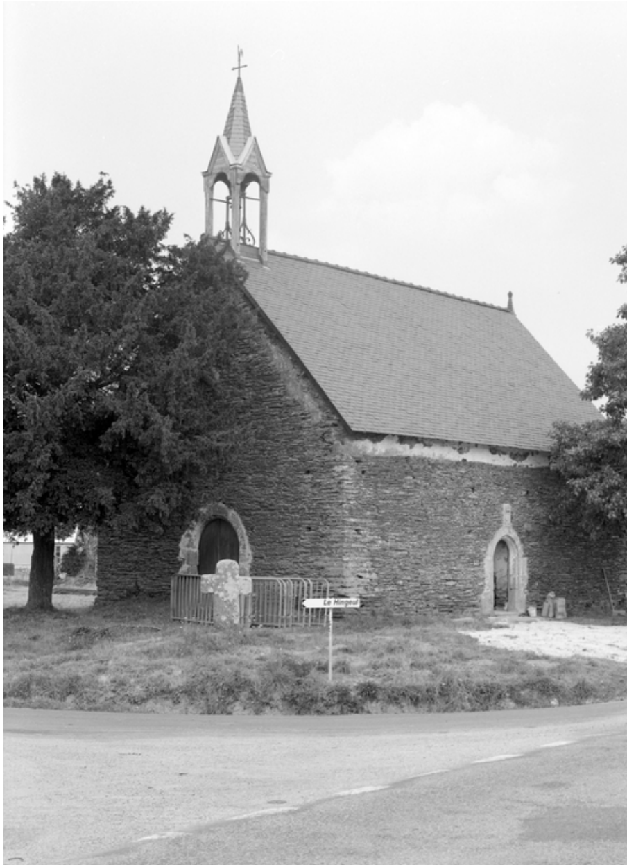
Chapelle vue du sud-ouest (état en 1984)
