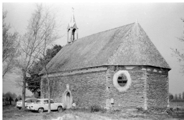
Vue du chevet (état en 1984) Phot. Berthou Marie, Phot. Catherine Toscer IVR53_19765605923Z
