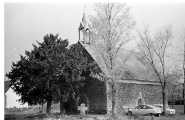
Vue du sud-ouest (état en 1984) Phot. Berthou Marie, Phot. Catherine Toscer IVR53_19765605924Z
