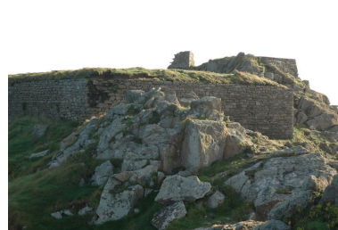
Vue de la pointe septentrionale de l'Îlette. Noter l'importance des maçonneries de la batterie haute et de la plate-forme du signal Phot. Guillaume Lécueillier IVR53_20042904139NUCA
