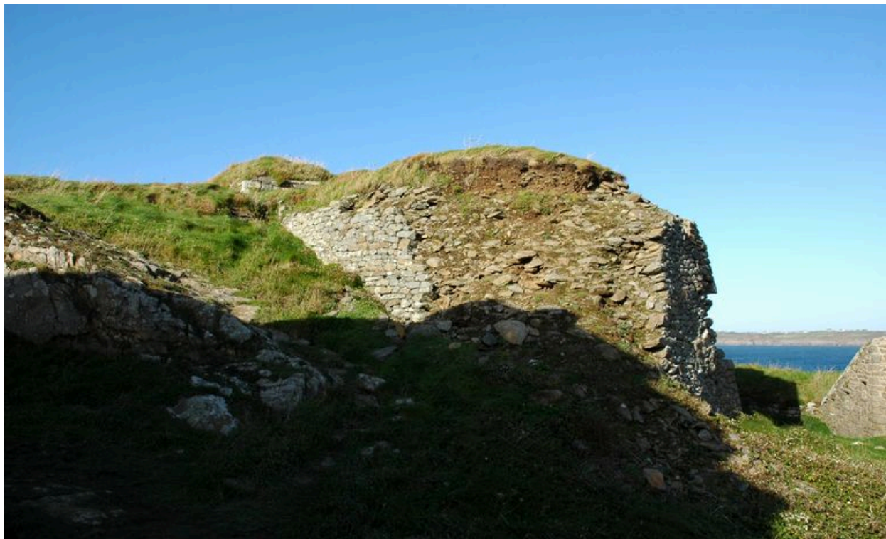
Massif de maçonnerie soutenant le parapet de la batterie haute
