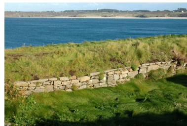
Vue du parapet de la batterie haute. En arrière-plan : la plage des Blancs Sablons Phot. Guillaume Lécueillier IVR53_20042904169NUCA
