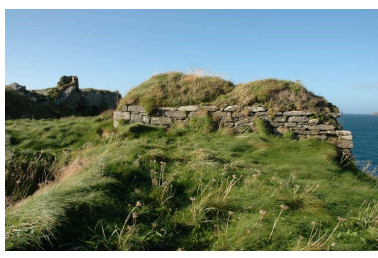
Vue du parapet de la batterie haute Phot. Guillaume Lécueillier IVR53_20042904148NUCA
