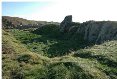
Vue générale de la batterie haute Phot. Guillaume Lécueillier IVR53_20042904168NUCA
