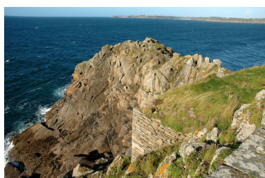
Extrémité septentrionale de l'Îlette : massif de maçonnerie soutenant le parapet de la batterie haute Phot. Guillaume Lécueillier IVR53_20042904166NUCA
