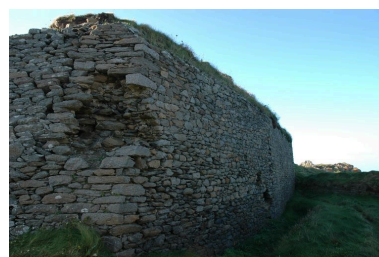
Massif de maçonnerie soutenant le parapet de la batterie haute Phot. Guillaume Lécueillier IVR53_20042904146NUCA
