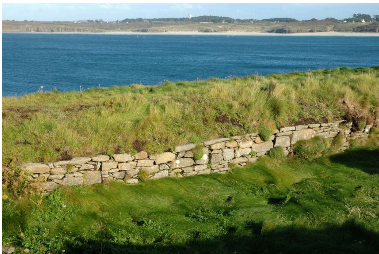
Vue du parapet de la batterie haute. En arrière-plan : la plage des Blancs Sablons
