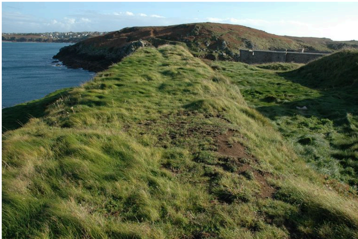
Vue du parapet de la batterie haute
