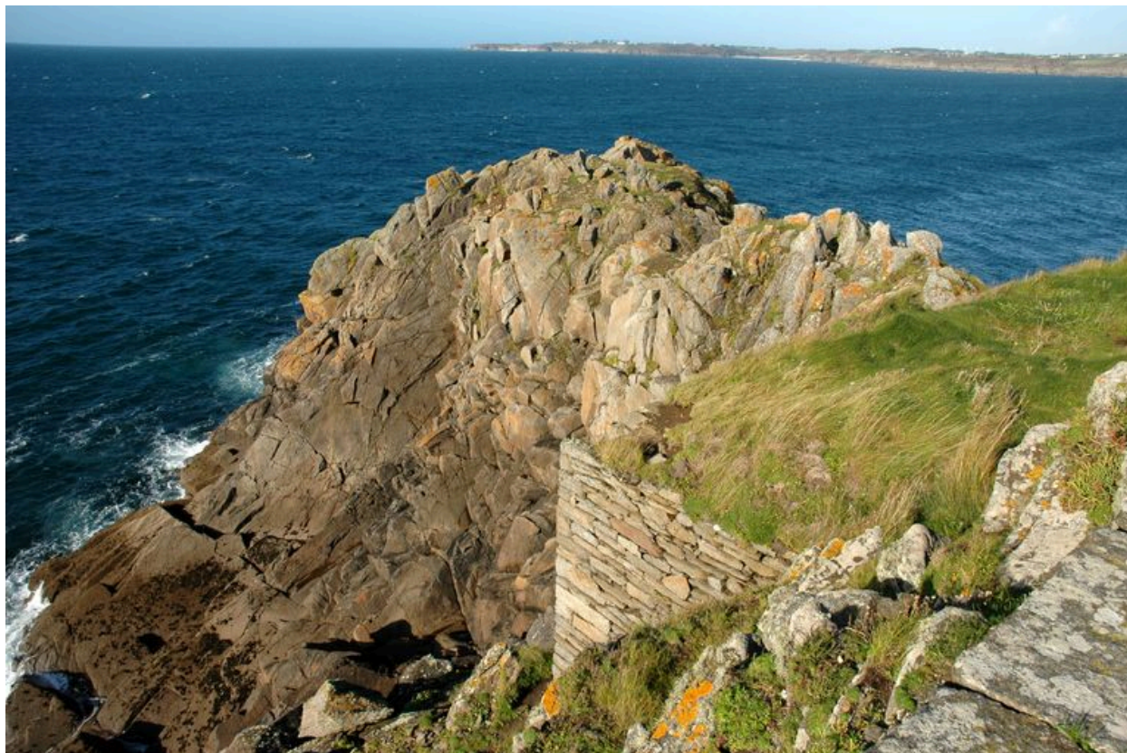
Extrémité septentrionale de l'Îlette : massif de maçonnerie soutenant le parapet de la batterie haute
