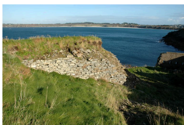
Massif de maçonnerie soutenant le parapet de la batterie haute Phot. Guillaume Lécueillier IVR53_20042904171NUCA
