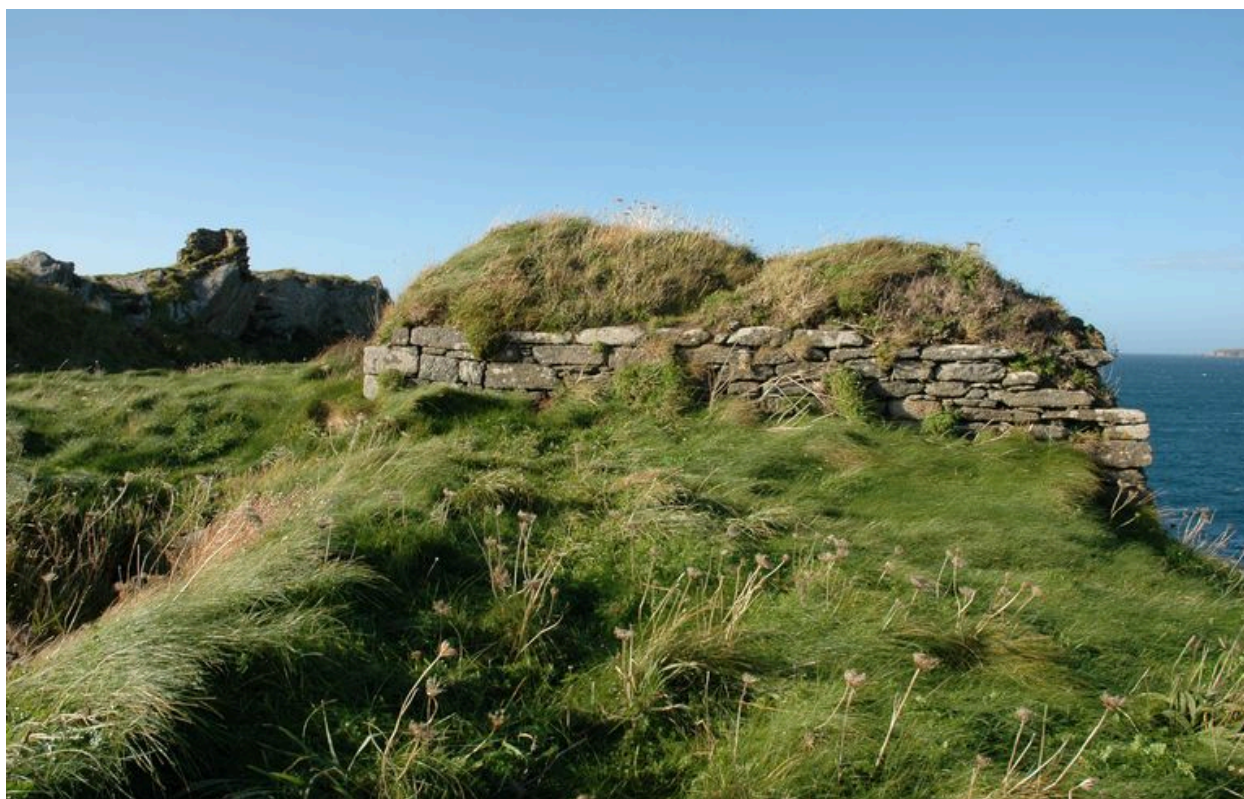
Vue du parapet de la batterie haute
