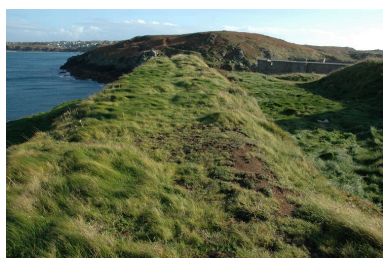
Vue du parapet de la batterie haute Phot. Guillaume Lécueillier IVR53_20042904170NUCA
