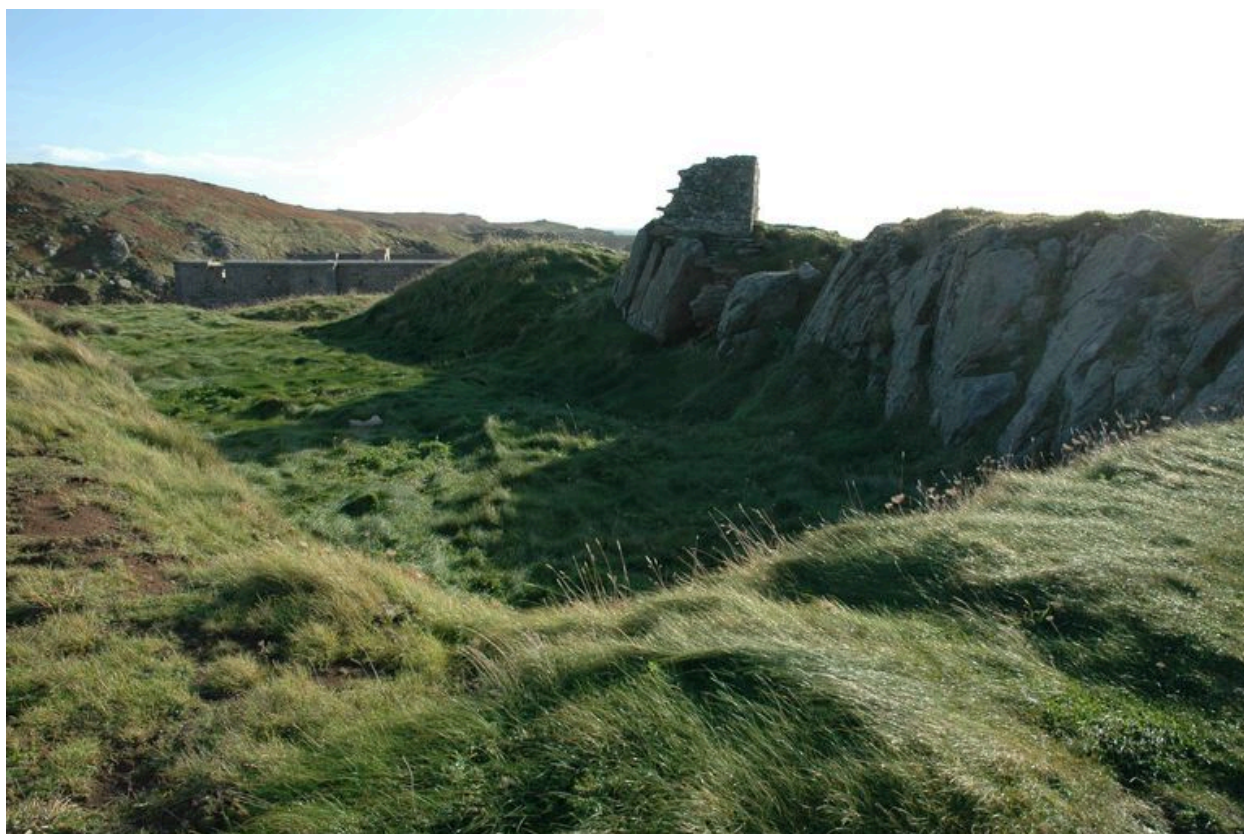
Vue générale de la batterie haute
