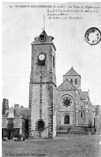
La tour et l'église, élévation Sud : vue générale (Carte postale ancienne, AD35 : 6Fi) Phot. Guy Artur, Phot. Norbert Lambart IVR53_19933500870X
