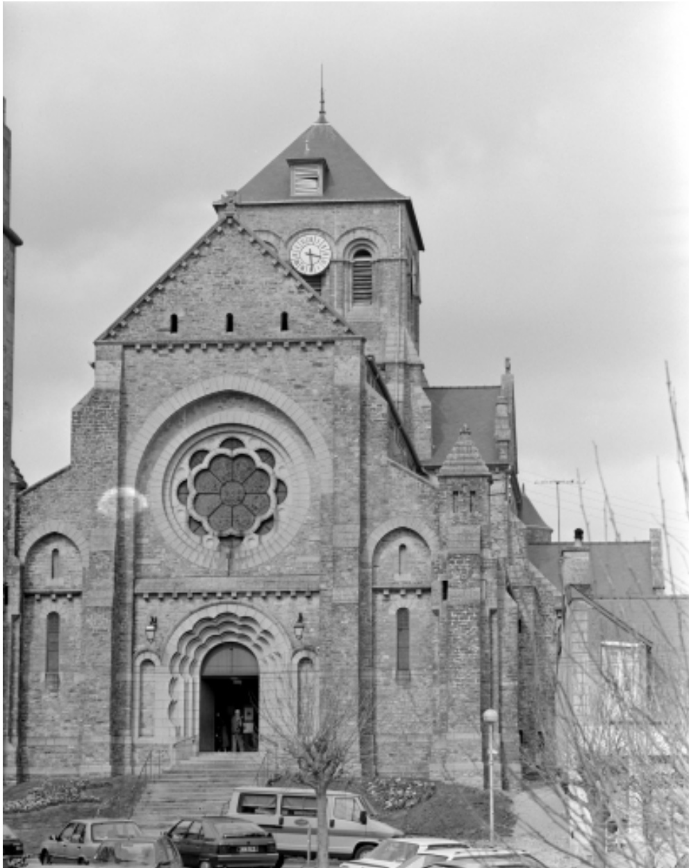
Elévation Sud : vue générale
