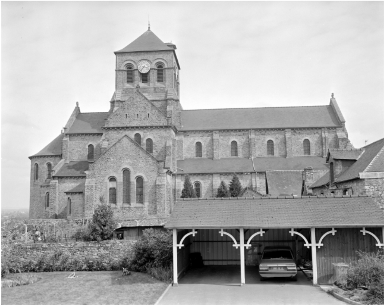
Elévation Ouest : vue générale
