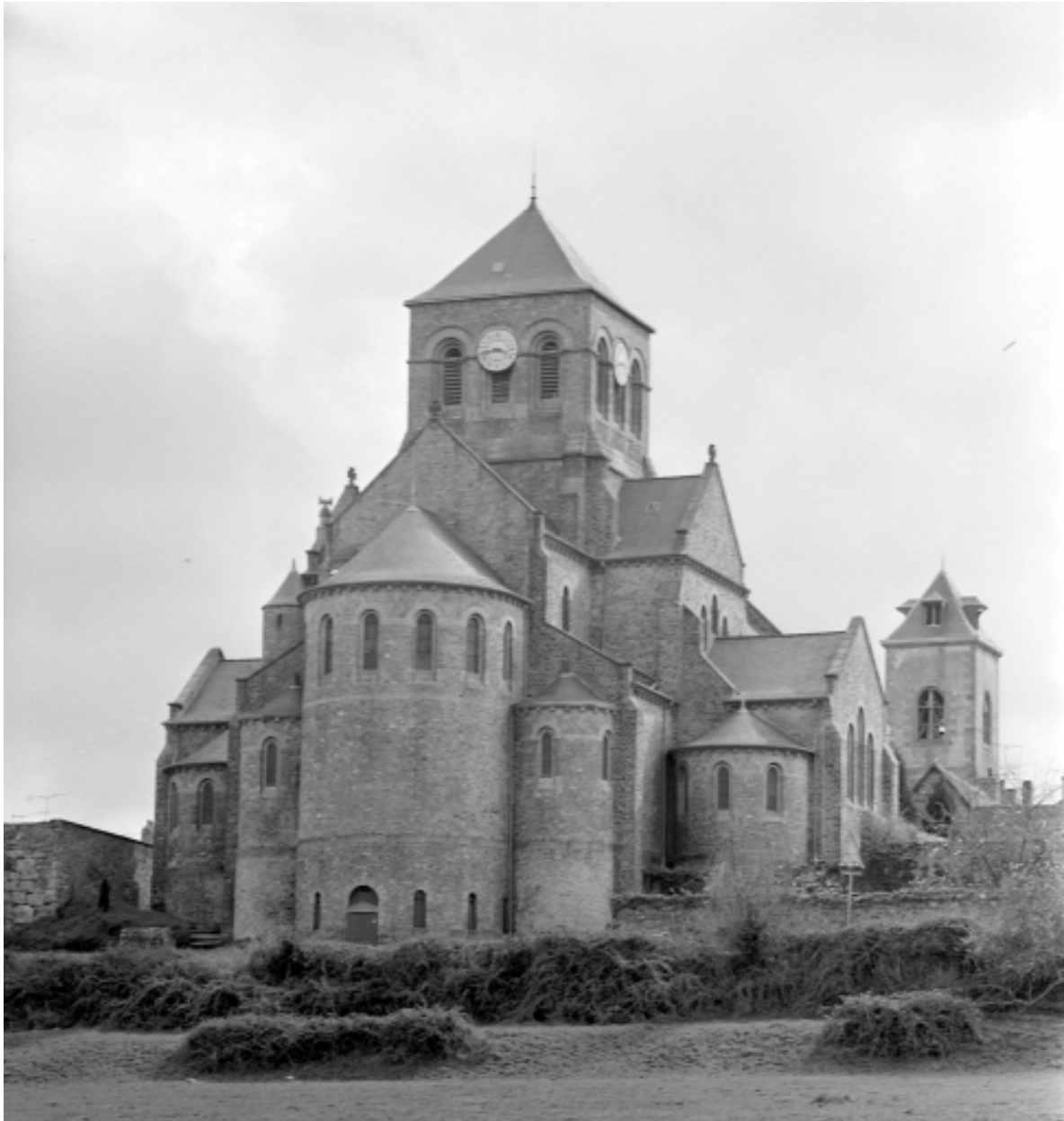
Elévation Nord : vue générale
