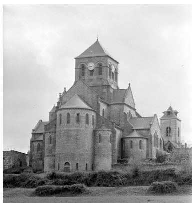
Elévation Nord : vue générale Phot. Guy Artur, Phot. Norbert Lambart IVR53_19943500787X
