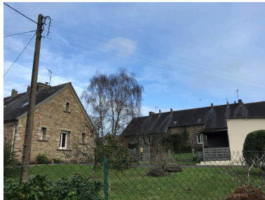
Détail cité des Cheminots Phot. Pierre Laurent Constantin IVR53_20225605179NUCA
