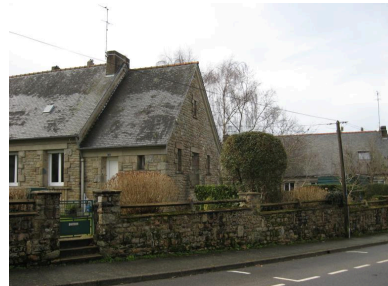
Cité des cheminots, maison vu de l'avenue du 8 Mai 1945 Phot. Pierre Laurent Constantin IVR53_20225605180NUCA
