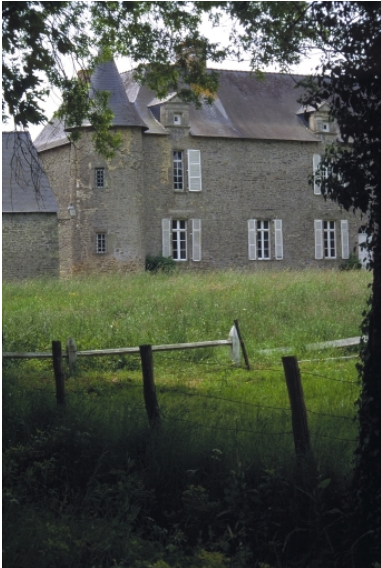
Vue générale nord Phot. Claude Quillivic IVR53_19943502625ZA
