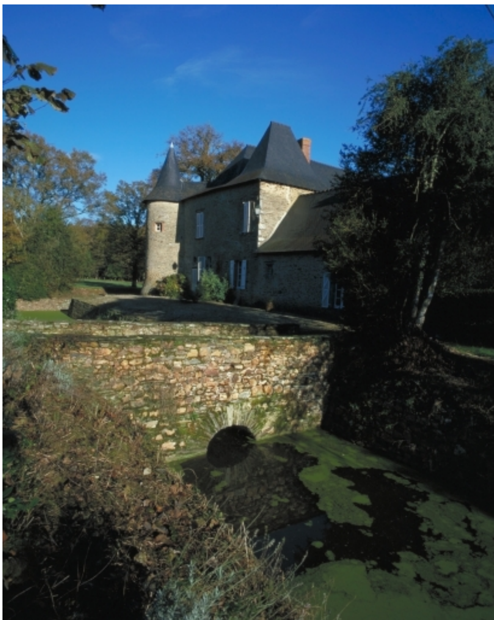
Vue générale ouest, les douves au premier plan
