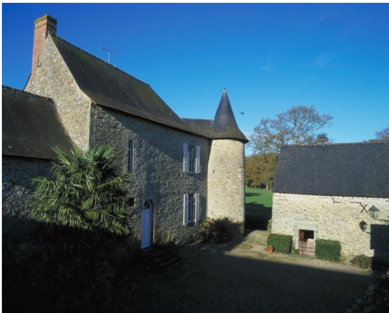
Corps de logis en retour d'équerre ; vue de situation est
