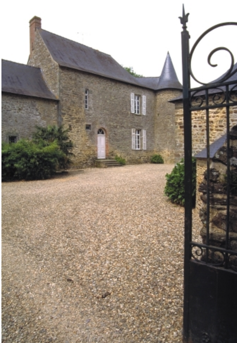
Corps de logis en retour d'équerre ; vue de situation est
