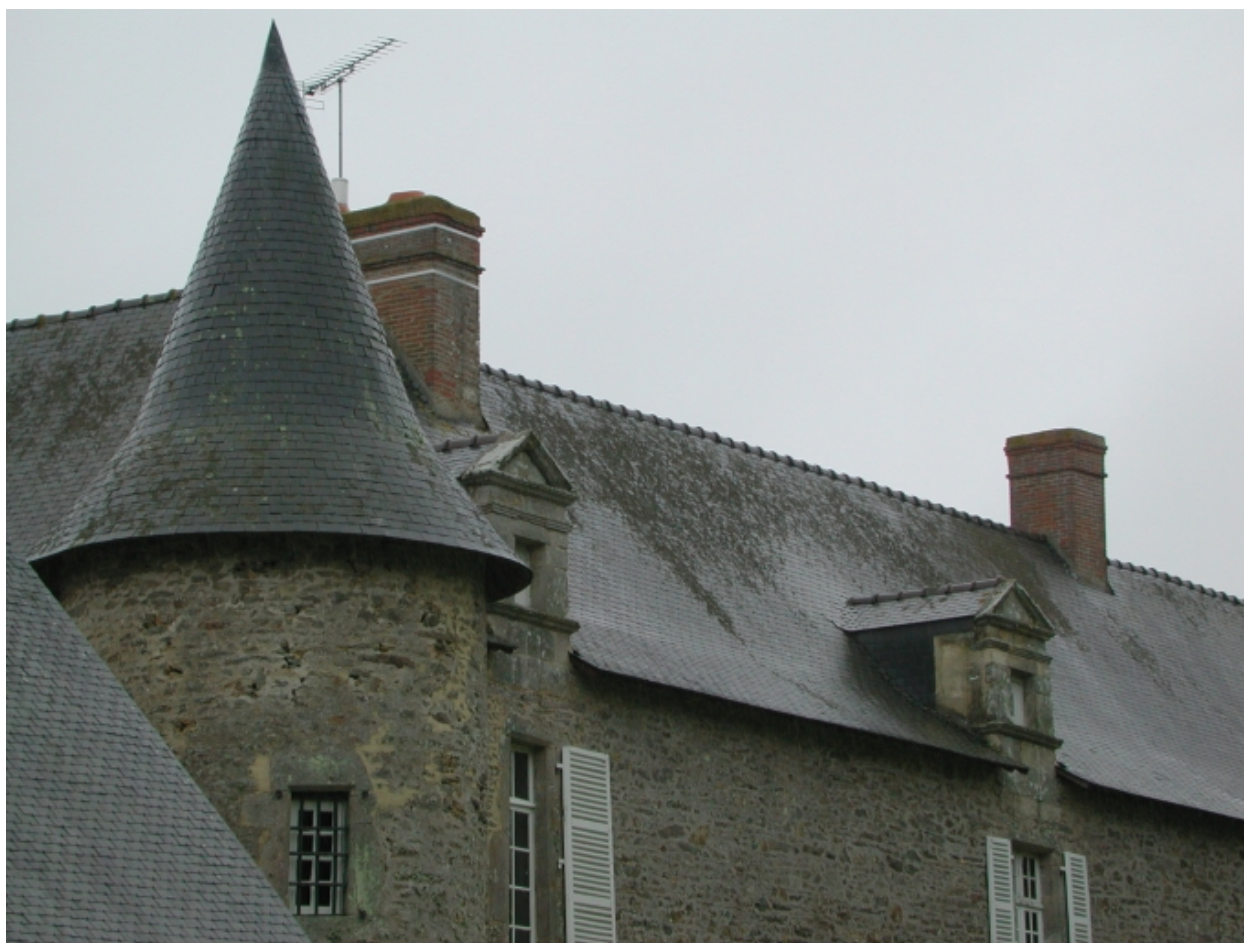
Détail : toiture en poivrière
