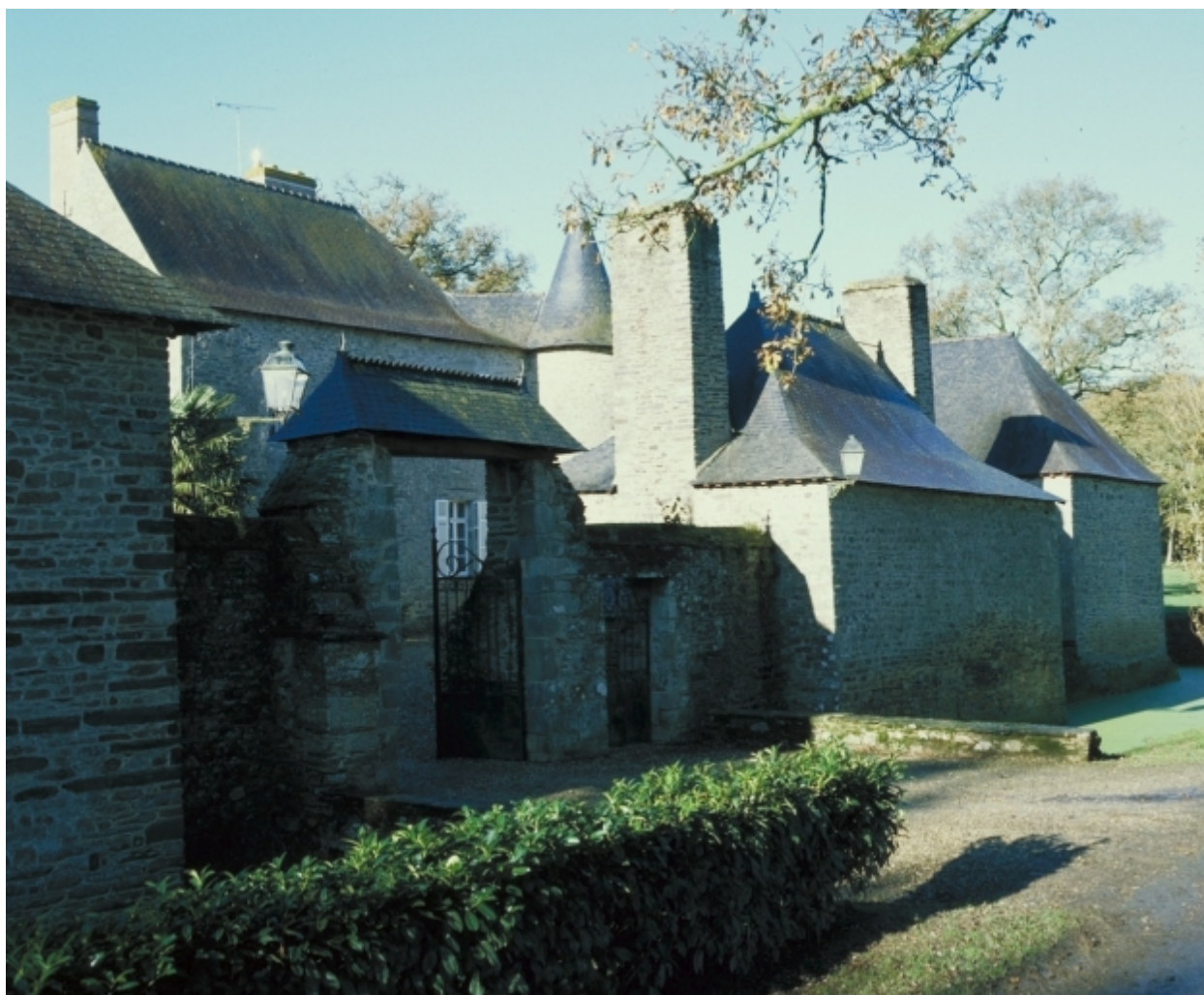
Vue partielle est
