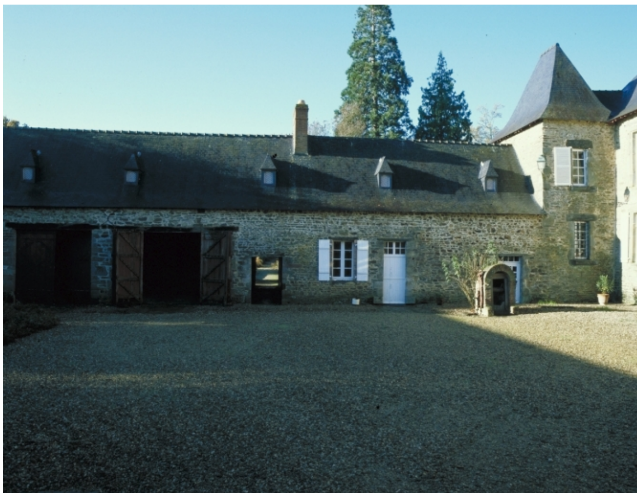
Cour, communs : vue générale est
