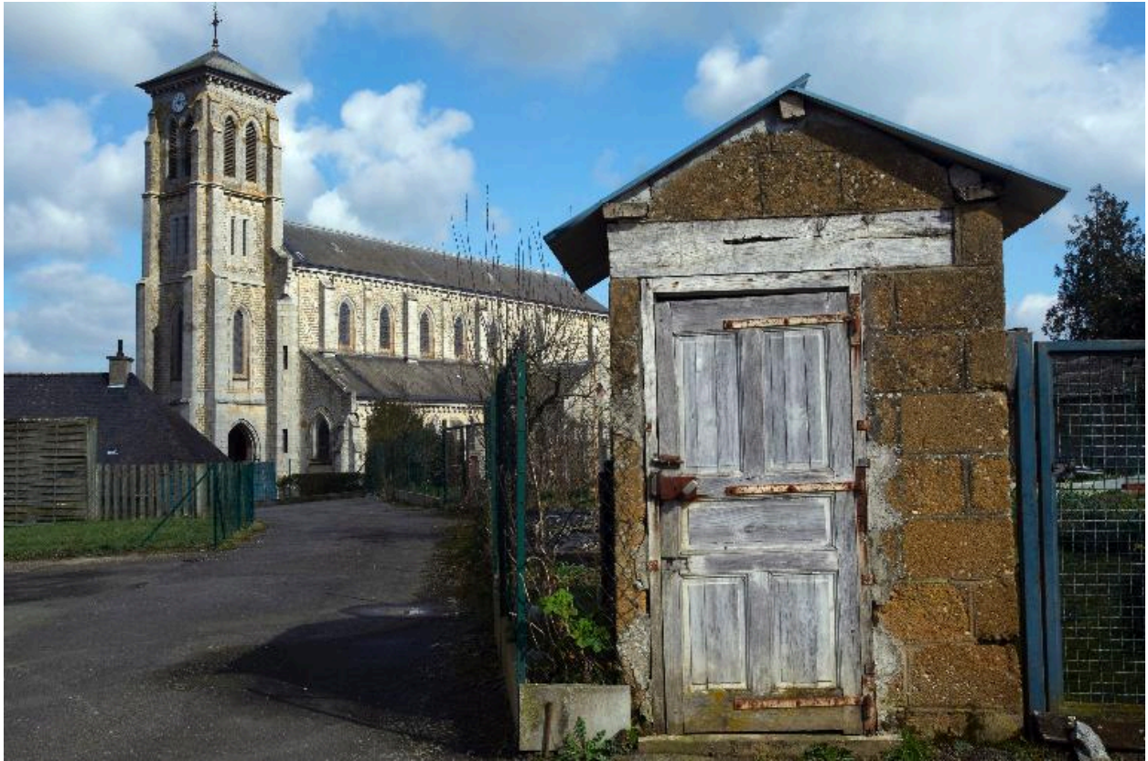
Vue de situation de l'église
