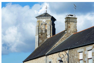
Le clocher de l'église Phot. Véronique Samson IVR53_20133500413NUCA
