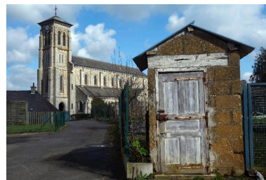
Vue de situation de l'église Phot. Véronique Samson IVR53_20133500375NUCA
