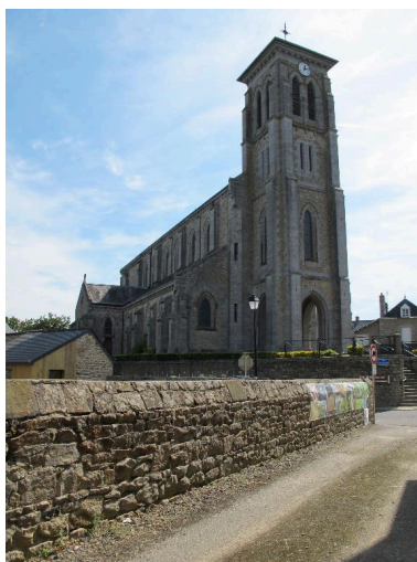
Vue générale Phot. Stéphanie Bardel IVR53_20133518055NUCA
