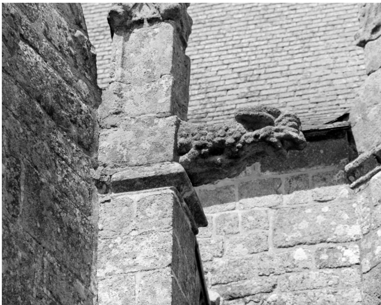
Elévation sud, vue de détail de gargouille.
