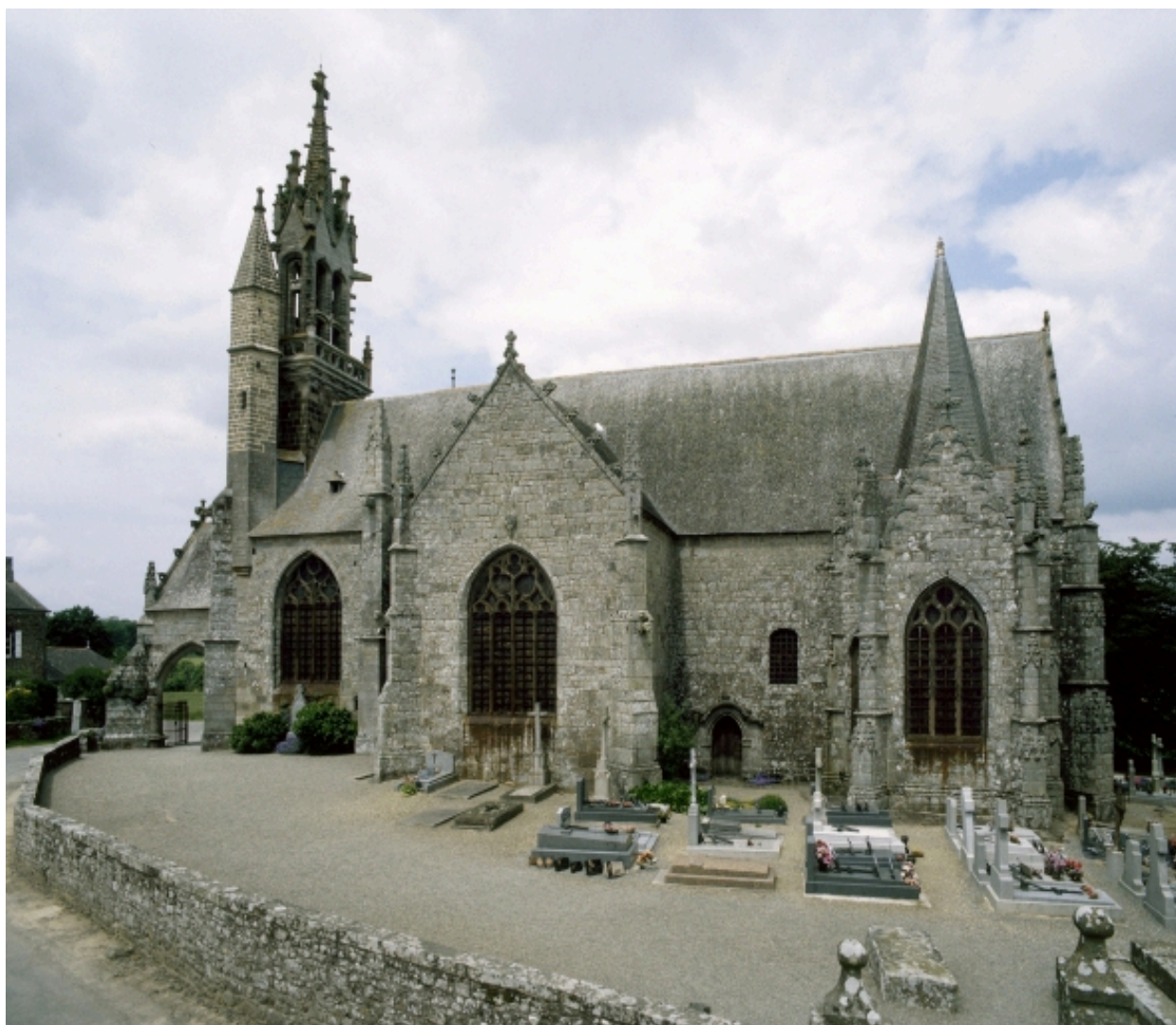
Elévation sud, partie est : vue générale
