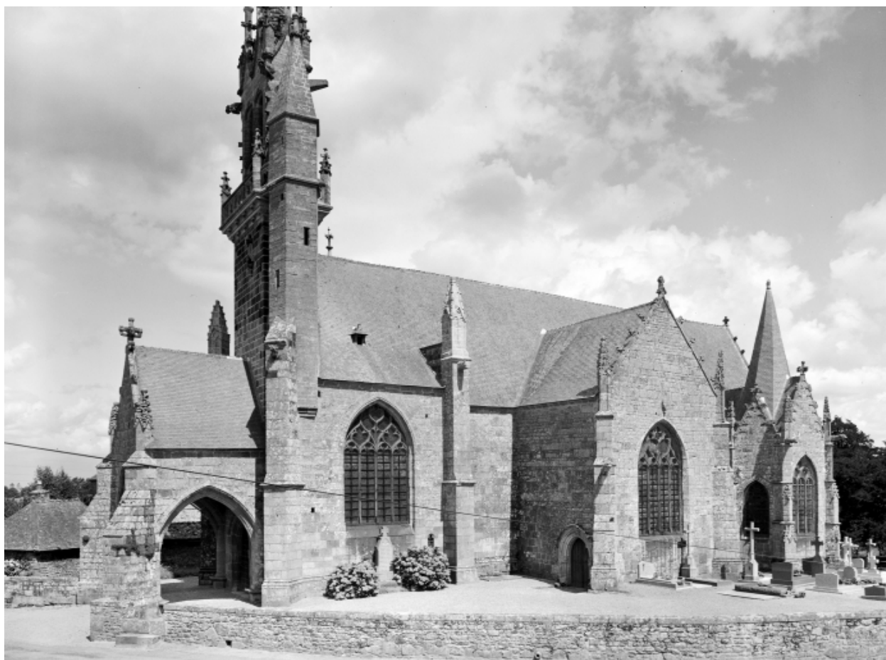
Elévation Sud, partie ouest : vue générale
