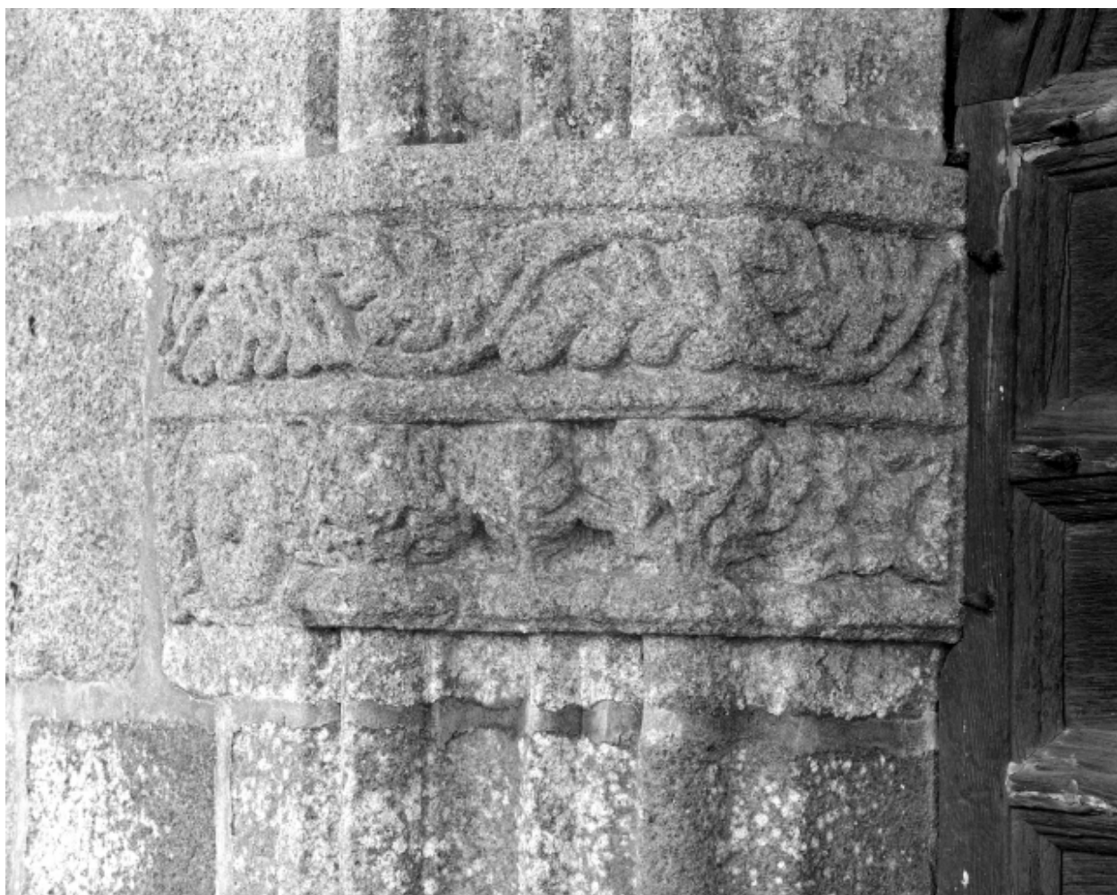
Porte ouest, vue de détail du bandeau sculpté de gauche.
