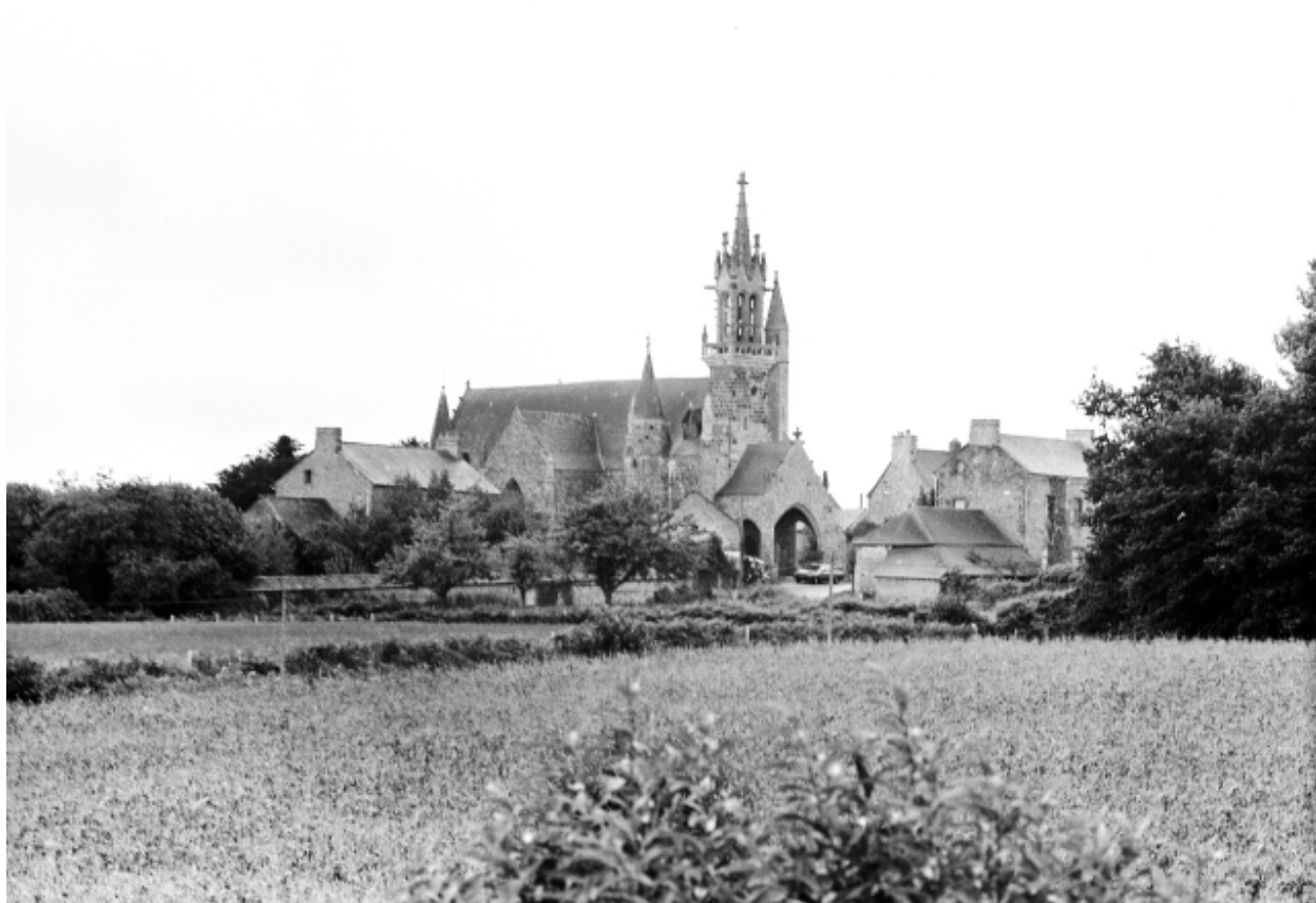
Vue de situation prise du nord-ouest.
