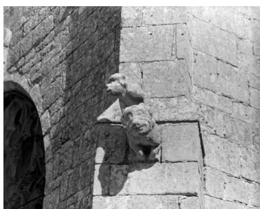
Crossette à deux monstres vue de détail. Phot. L. Lamandé IVR53_19853500934X
