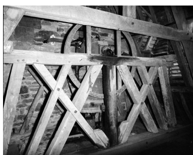
Mécanisme des cloches, vue générale. Phot. L. Lamandé IVR53_19853501034X
