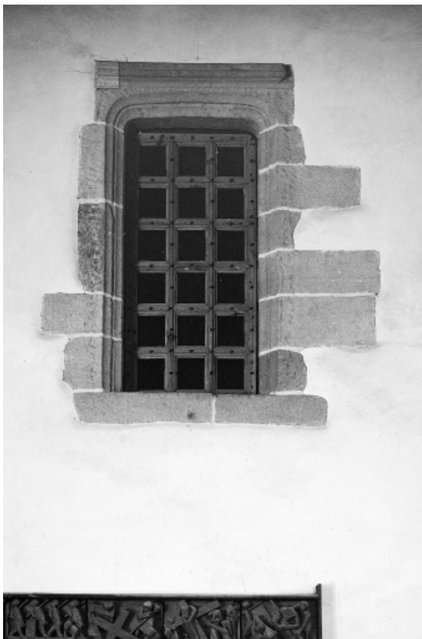
Nef, mur nord : porte d'accès au jubé.
