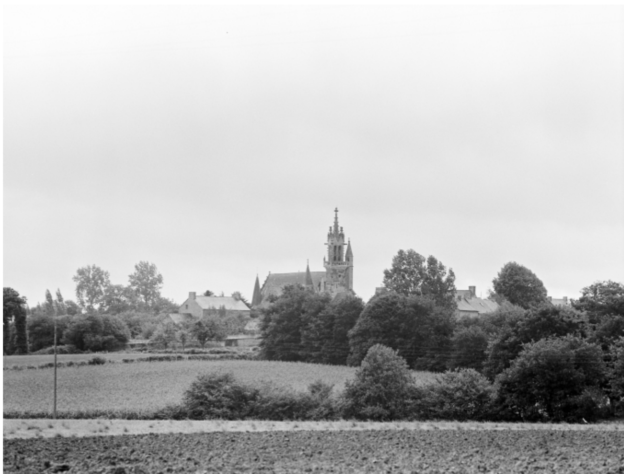
Vue de situation prise du Nord-Ouest.
