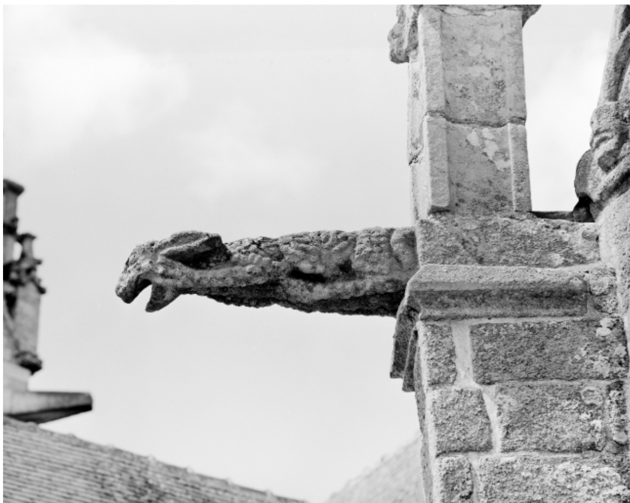
Elévation sud, vue de détail de gargouille.
