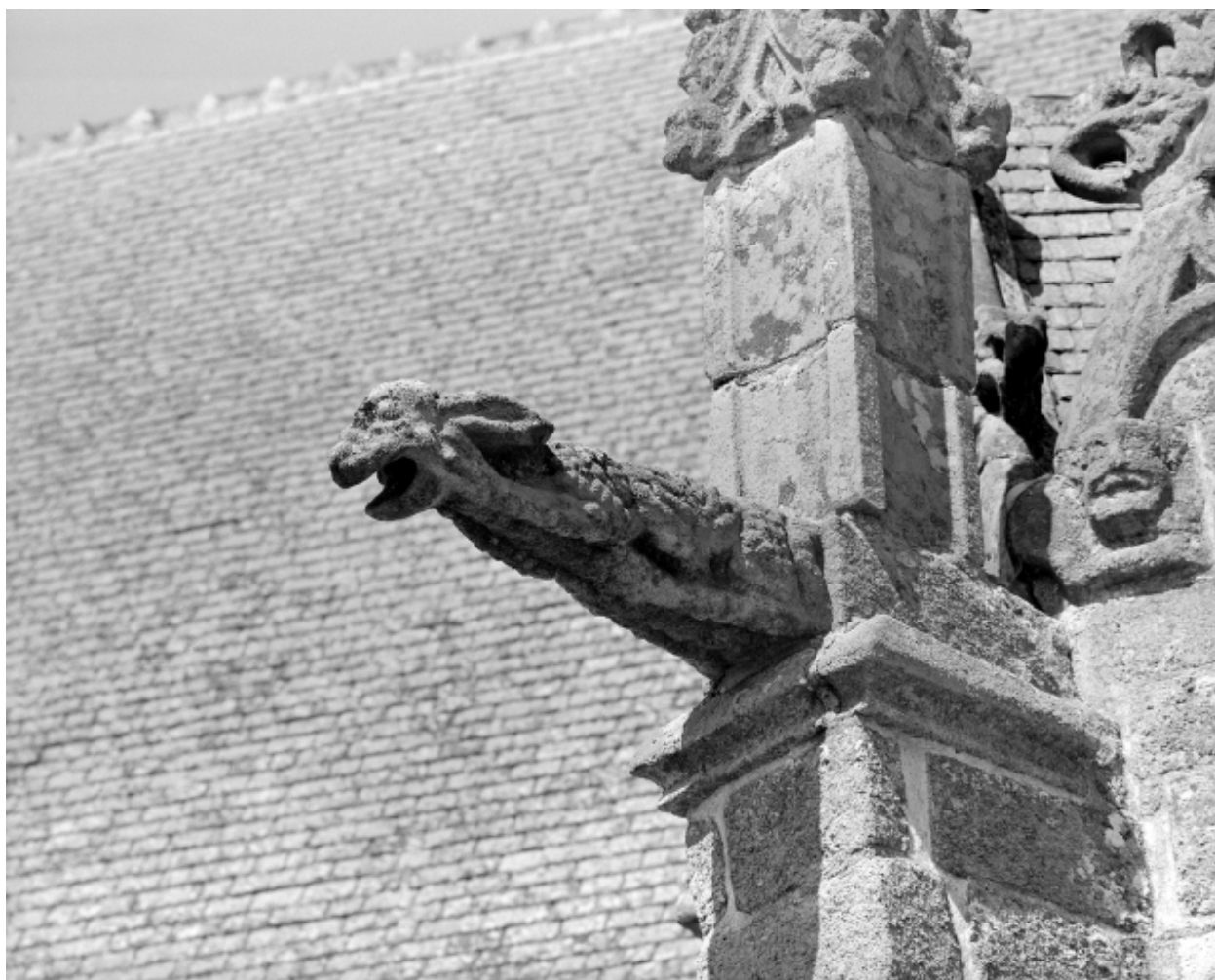
Elévation sud, vue de détail de gargouille.
