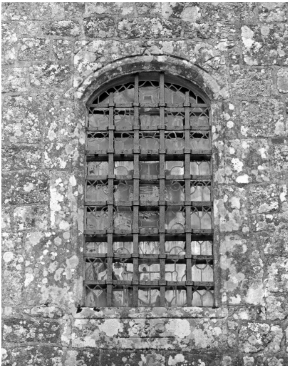
Elévation sud, fenêtre datée : vue générale.
