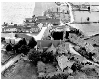
Vue aérienne prise du nord. Phot. L. Lamandé IVR53_19823500204P
