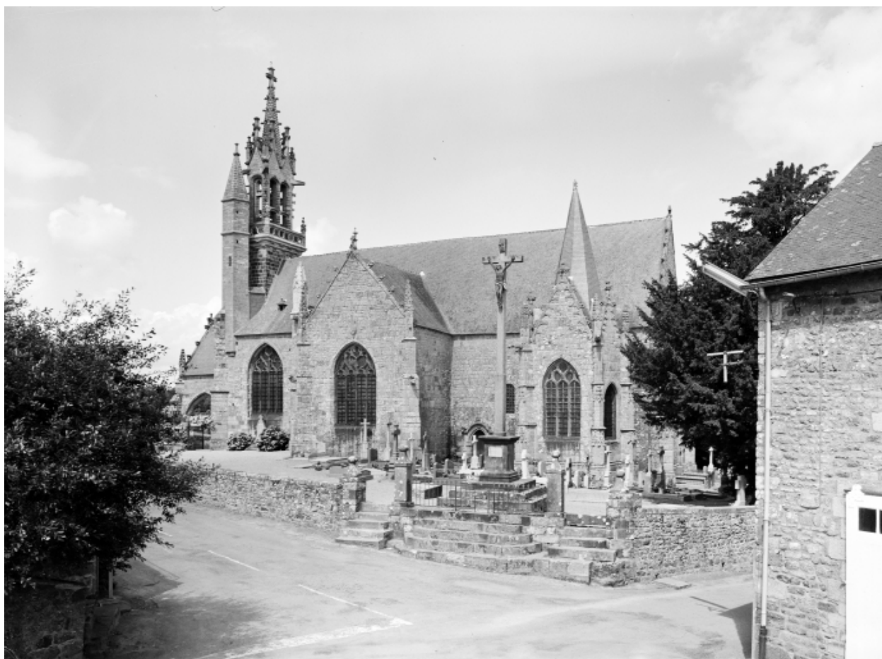
Elévation sud, partie est : vue générale
