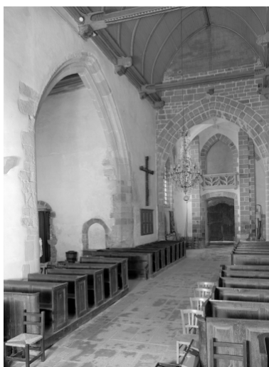
Vue intérieure vers le sud-ouest. Phot. L. Lamandé IVR53_19853501324X
