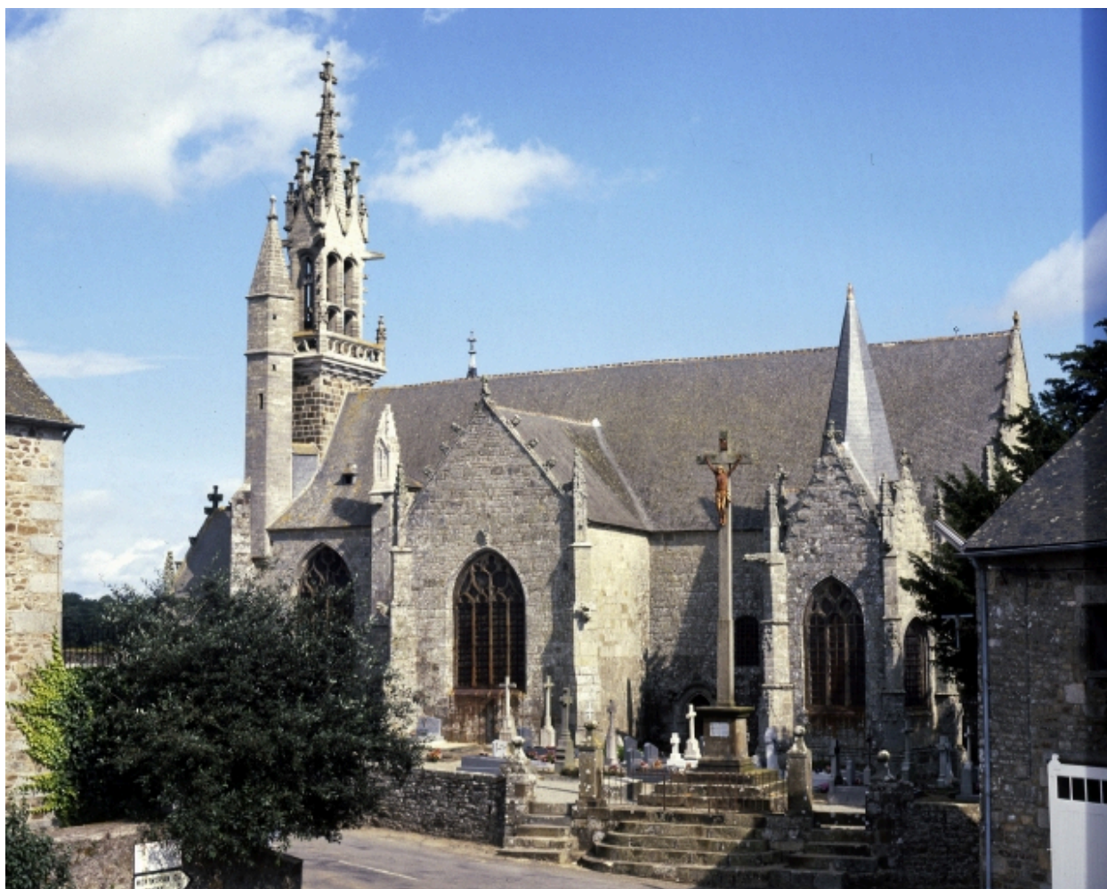
Elévation sud, partie est : vue générale
