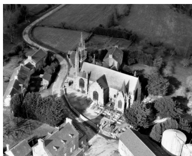
Vue aérienne prise du sud. Phot. L. Lamandé IVR53_19823500205P
