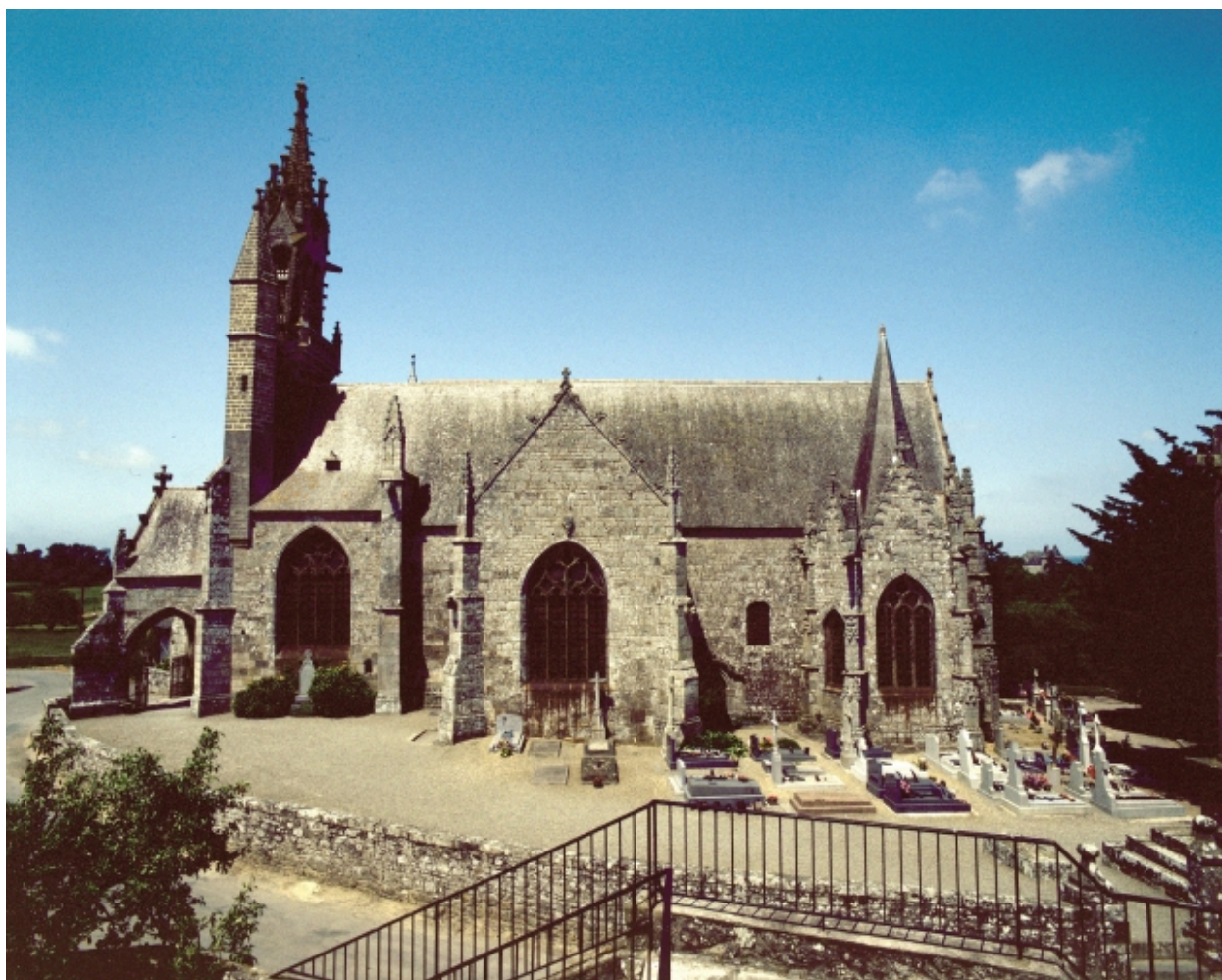
Elévation sud, partie ouest : vue générale
