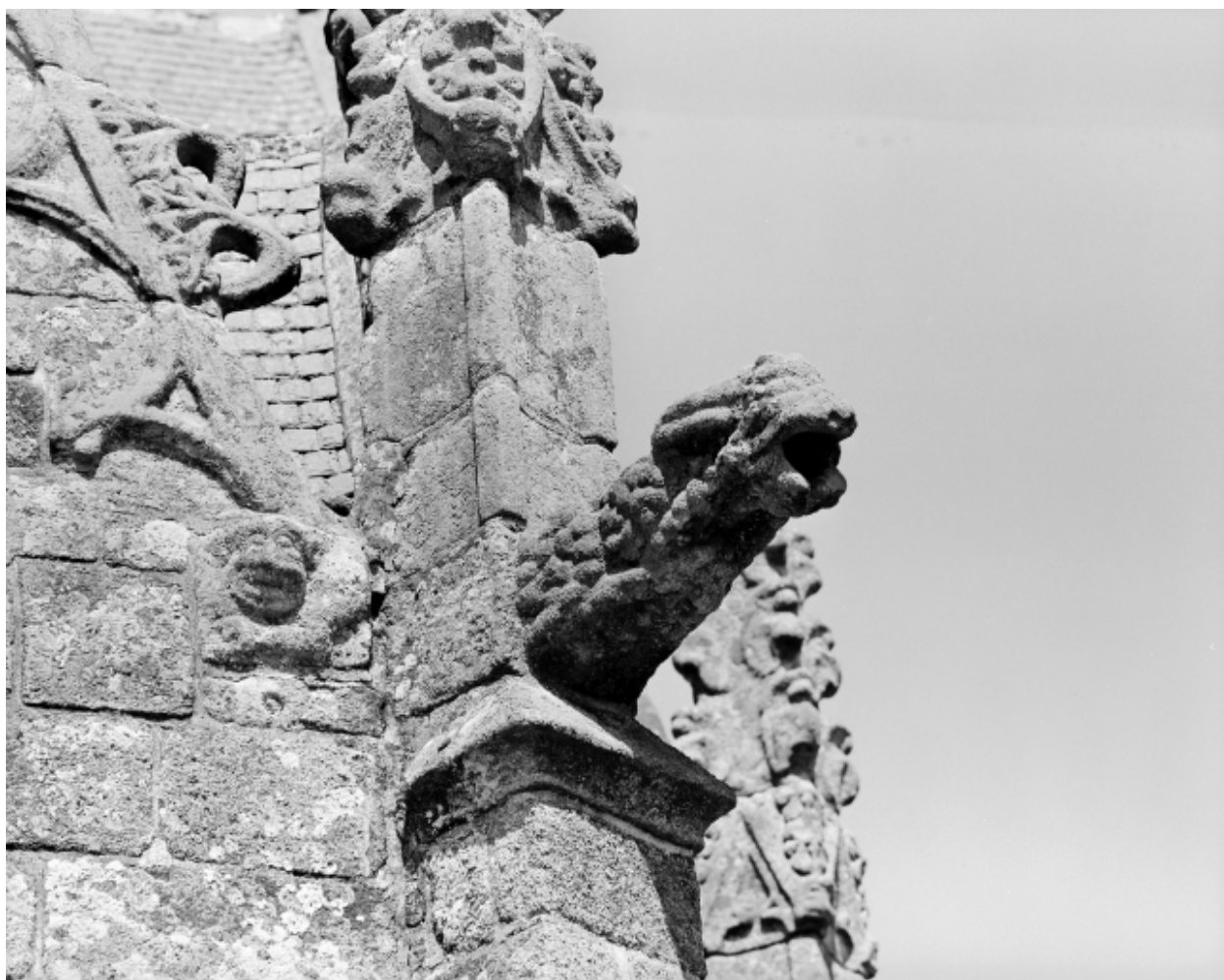
Elévation sud, vue de détail de gargouille.
