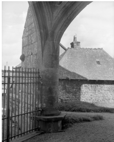
Porche occidental, pile nord- ouest et départ de voûtement. Phot. L. Lamandé IVR53_19853500941X
