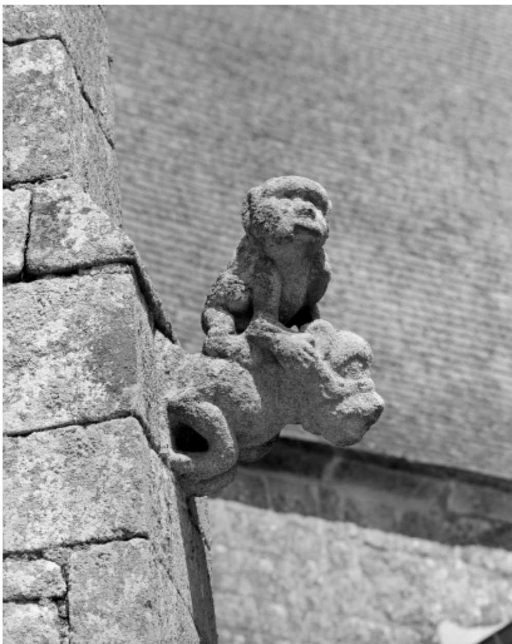
Elévation sud, vue de détail de gargouille.
