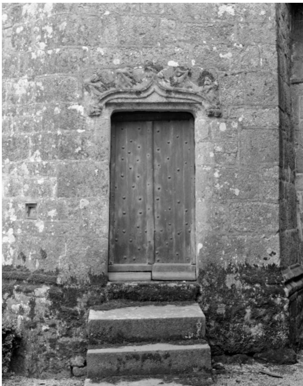
Elévation nord, chapelle de Montmuran : porte, vue générale.
