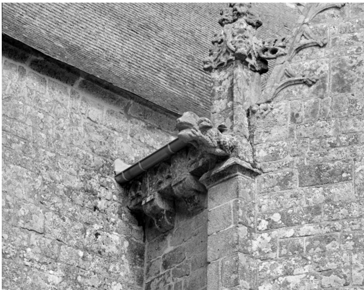
Détail de la corniche, décor de corbeaux.
