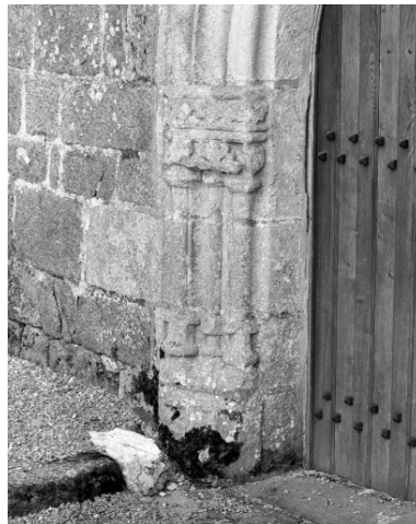
Elévation sud, porte du transept : détail piédroit. Phot. L. Lamandé IVR53_19853500944X
