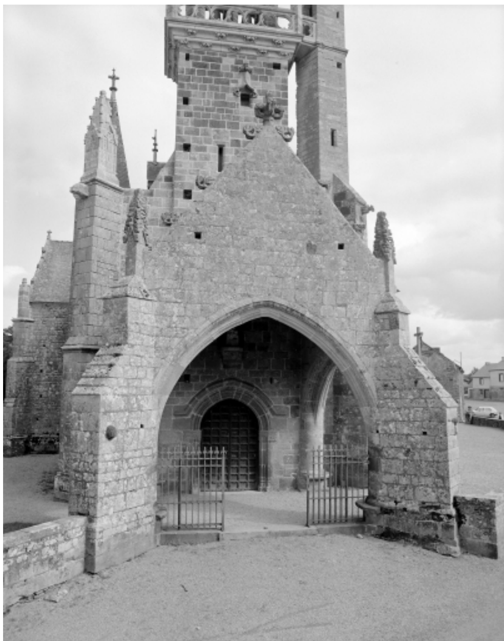
Elévation ouest, porche : vue générale
