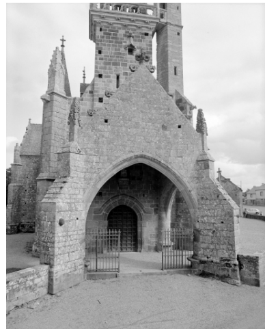
Elévation ouest, porche : vue générale Phot. L. Lamandé IVR53_19853501310X
