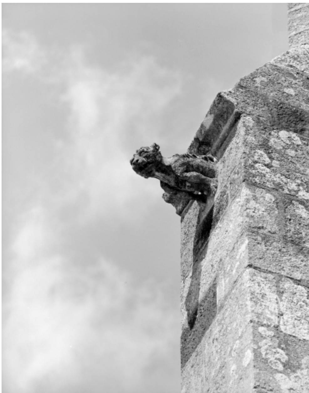
Elévation sud, vue de détail de gargouille.
