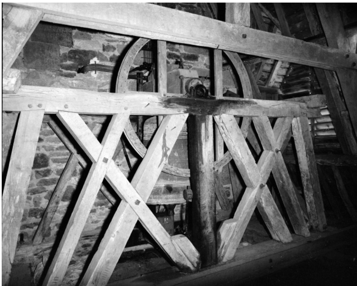
Mécanisme des cloches, vue générale.
