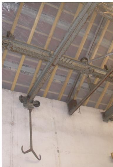
Charpente avec crochets sur rails.
