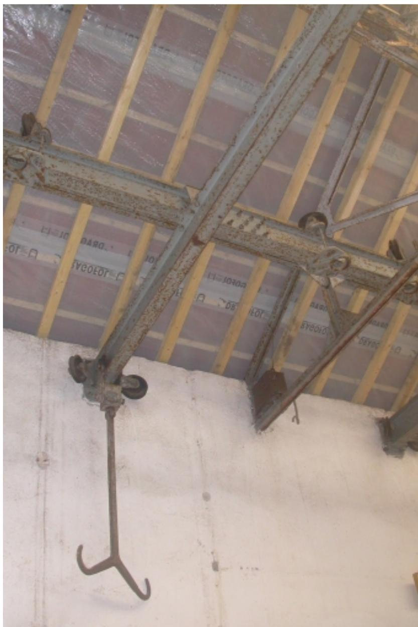
Charpente avec crochets sur rails.
