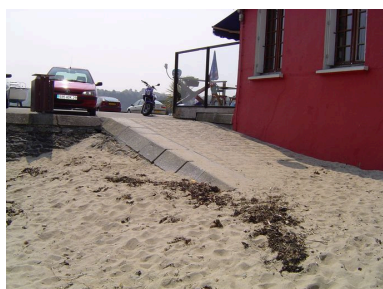
Cale de l'Hôtel de la Terrasse Phot. Clotilde Buhot IVR53_20062908520NUCA
