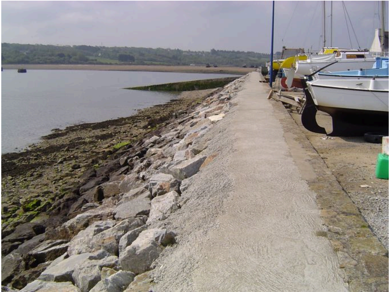
Digue du terre-plein de Roche-Noire
