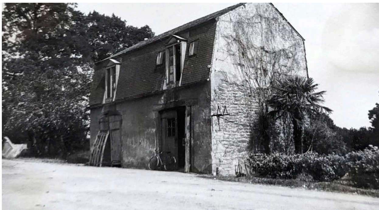
Le bâtiment "C", figure parmi les édifices restaurés de l'ancien domaine de Kervégant pour l'installation de la colonie de vacances.
