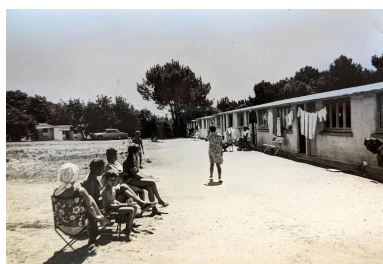
Les bungalows de "type familial" des Kaolins ne comportent plus de loggias en façade. L'espace repas est directement intégré au séjour. Repro. Région Bretagne IVR53_20265610084NUC
