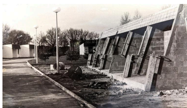
Les "logements pour célibataires" achèvent l'aventure constructive du village de vacances de Puteaux en Ploemeur. Repro. Région Bretagne IVR53_20265610061NUC
