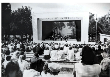
Encore visibles aujourd'hui, les marches du théâtre de verdure peuvent accueillir l'ensemble des vacanciers. Repro. Région Bretagne IVR53_20265610101NUC
