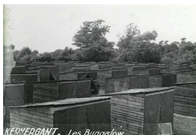
Rapidement, les cabanons de bois remplacent les tentes de la premières heures. Phot. Auteur inconnu IVR53_20265611022NUC
