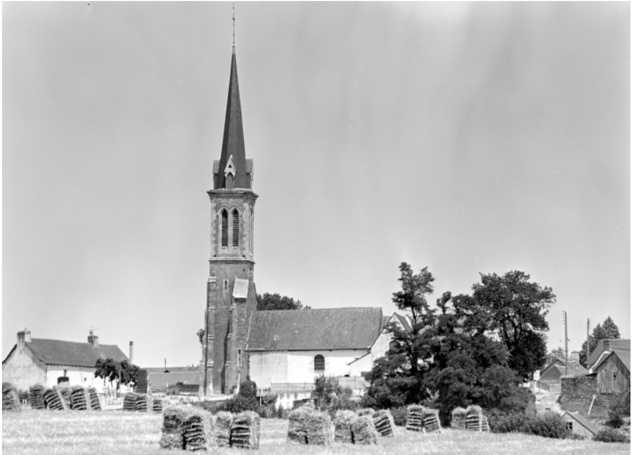
Vue de situation sud.
