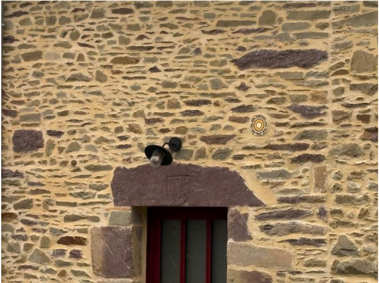
Linteau monumental avec date portée 1619, 400bis la Grée de Pouez
