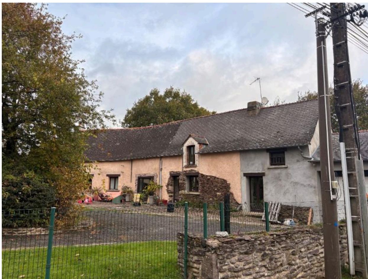
Enduit moderne sur une maçonnerie en moellon
