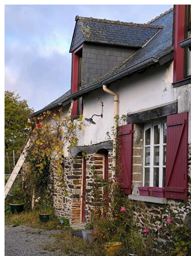
Porte jumelée, logis-mixte, 432 les Cours Hailauds Phot. Maélys VALLET IVR53_20253531324NUCA
