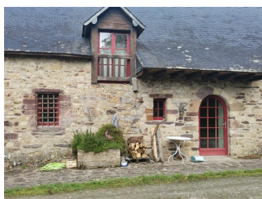
Détail porte en plein cintre au 867 Caran Phot. Alexandra IVR53_20253531527NUCA
