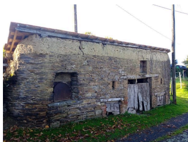
Four à pain accolé à une soue à cochon Phot. Alexandra de Vachon IVR53_2026351040NUCA
