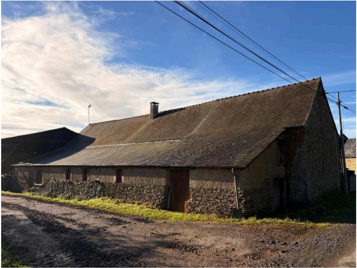
Cellier monumental de la ferme de la Forge
