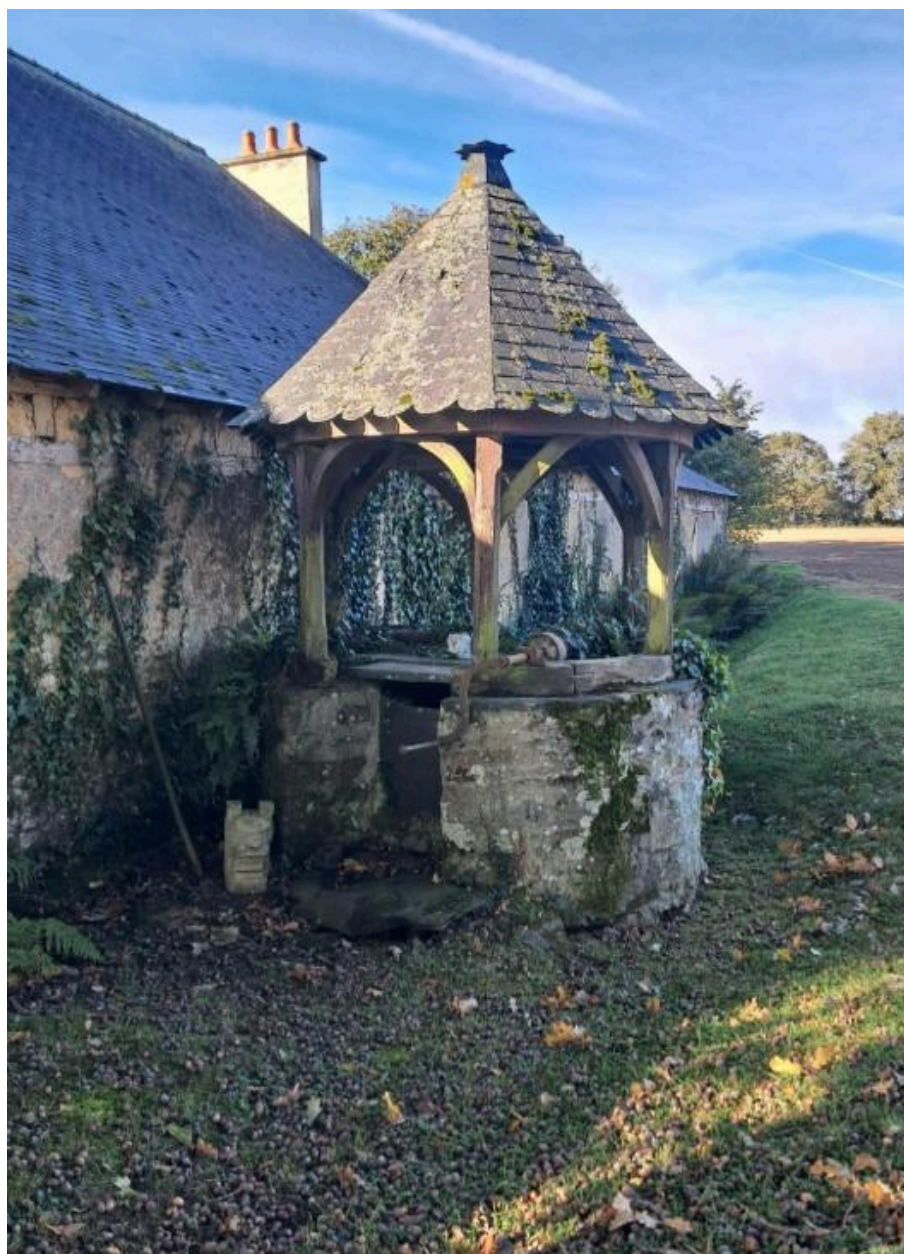
puits ouvragé 3897 Montverron
