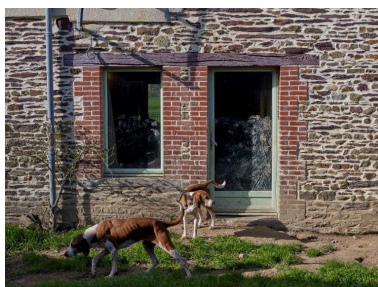
Vue de détail des ouvertures en briques Phot. Bernard Bègne IVR53_20263500244NUCA
