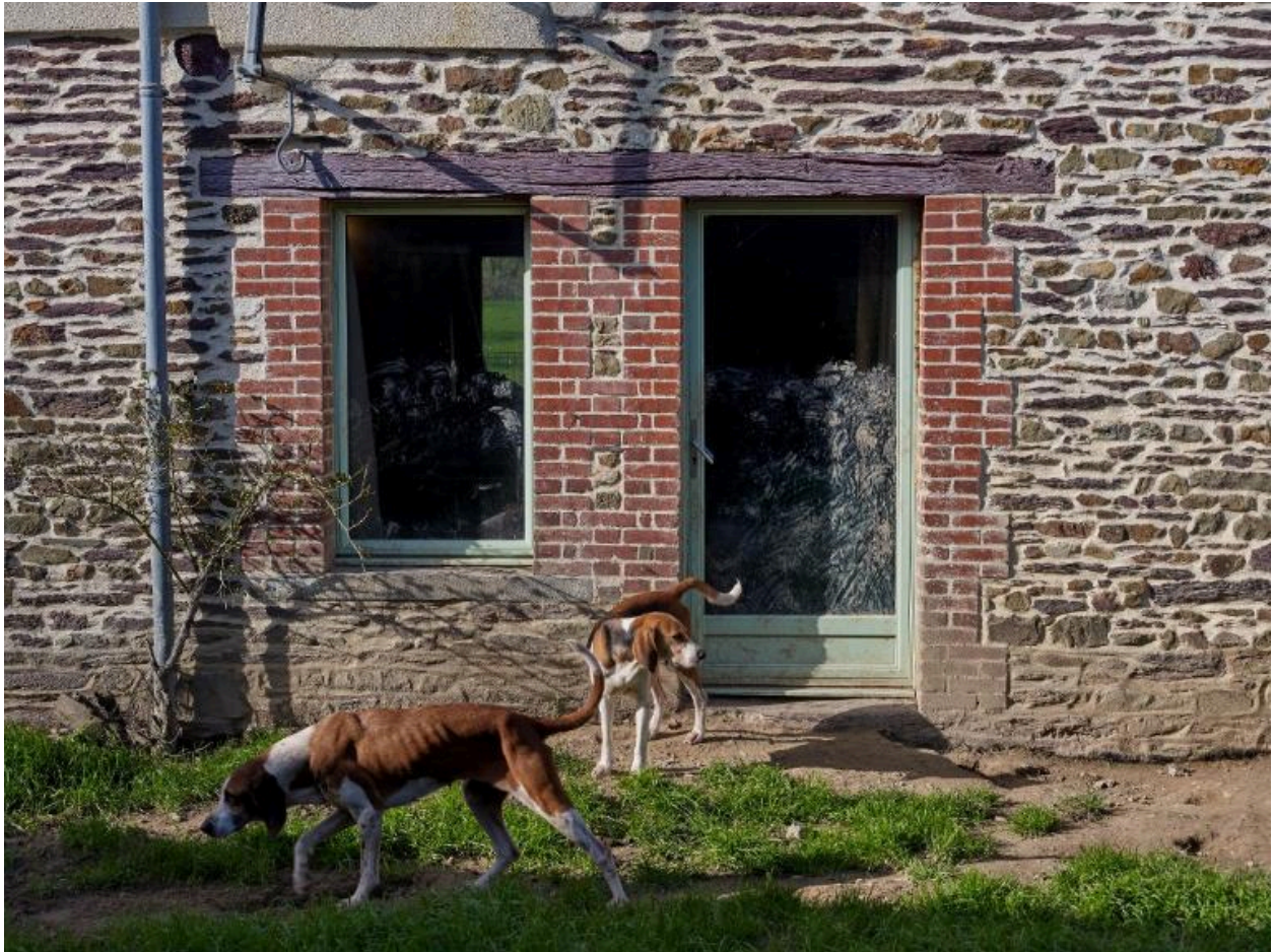
Vue de détail des ouvertures en briques
