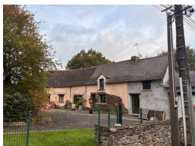
Enduit moderne sur une maçonnerie en moellon Phot. Kawrentin Pichot IVR53_20253532069NUCA
