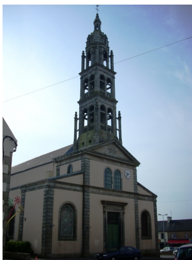
Plonéour-Lanvern, église paroissiale Saint-Eneour : vue générale ouest Phot. Gwénaél Fauchille IVR53_20082905860NUCA
