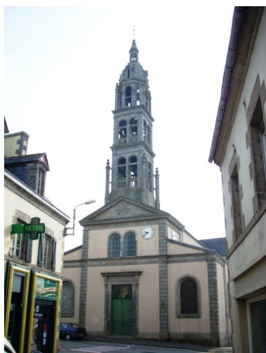
Plonéour-Lanvern, église paroissiale Saint-Eneour : vue générale ouest Phot. Gwénaél Fauchille IVR53_20082905859NUCA
