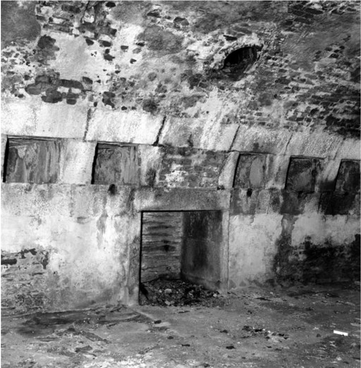
Vue de la tour-modèle n° 1 type 1811 de la pointe de Cornouaille en 1969 : deuxième niveau percé de créneaux de fusillade, cheminée
