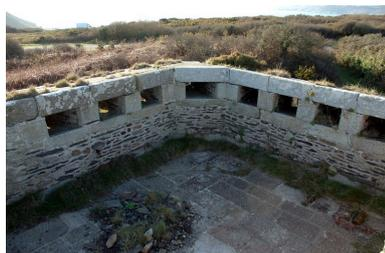
Roscanvel, pointe de Cornouaille : tour-modèle n° 1, parapet percé de créneaux de fusillade
