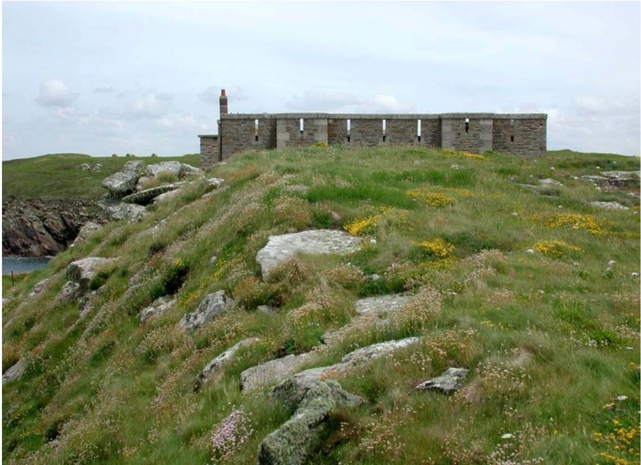
Vue du réduit de batterie de côte de la pointe de Kermorvan depuis l'ouest. L'implantation du réduit derrière un rocher en glacis permet d'utiliser au mieux les créneaux de fusillade de la terrasse pour la défense de l'ouvrage
