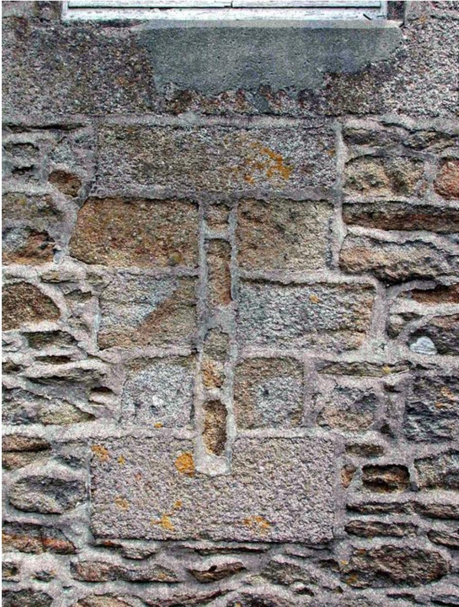
Vue du réduit de batterie de côte de la pointe de Kermorvan, créneau de fusillade comblé
