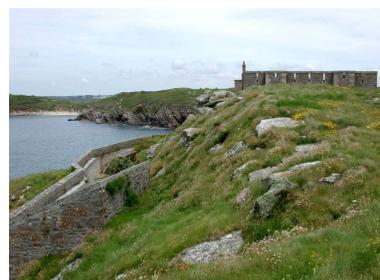
Vue générale du réduit de batterie de côte de la pointe de Kermorvan depuis l'ouest. L'implantation du réduit derrière un rocher en glacis permet d'utiliser au mieux les créneaux de fusillade de la terrasse pour la défense de l'ouvrage
