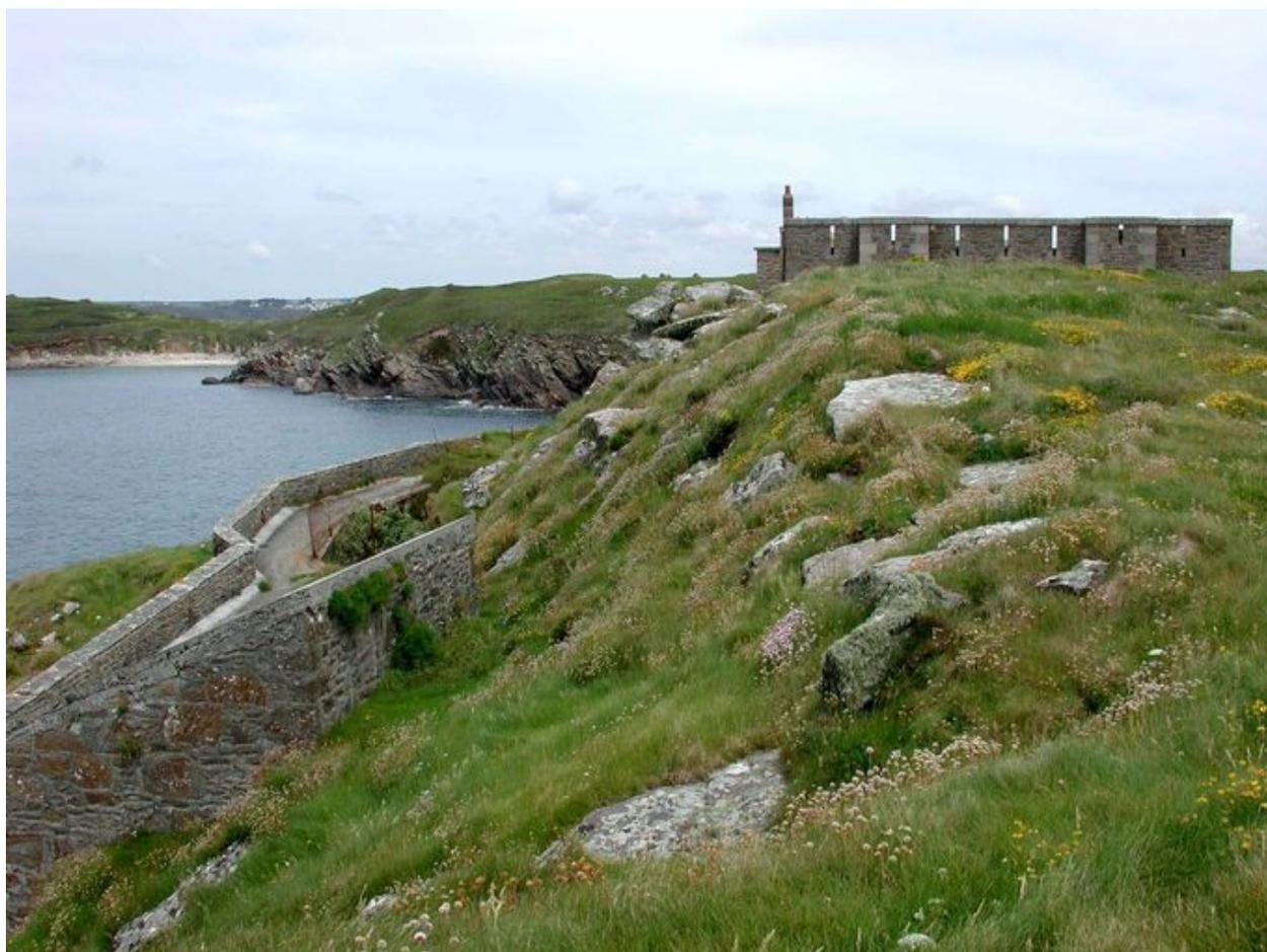
Vue générale du réduit de batterie de côte de la pointe de Kermorvan depuis l'ouest. L'implantation du réduit derrière un rocher en glaucis permet d'utiliser au mieux les créneaux de fusillade de la terrasse pour la défense de l'ouvrage
