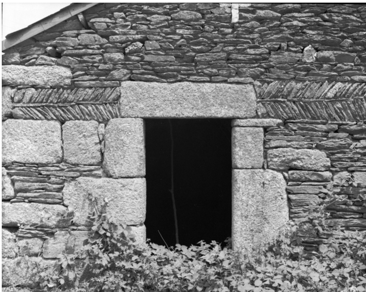
Ferme (Perran) : détail porte
