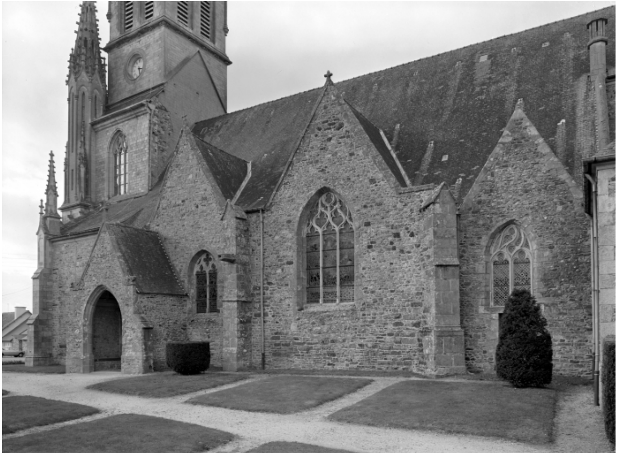
Elévation sud, vue générale.
