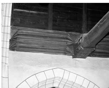
Intérieur, chapelle sud n°2, sablères et entrait : vue générale Phot. Guy Artur, Phot. Norbert Lambart IVR53_19873500160X
