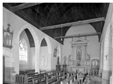
Chapelle 4 nord, vue générale. Phot. Guy Artur, Phot. Norbert Lambart IVR53_19873500167V
