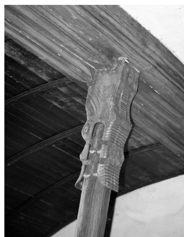
Intérieur, chapelle nord n°3, sablères et entrait : vue générale Phot. Guy Artur, Phot. Norbert Lambart IVR53_19873500161X
