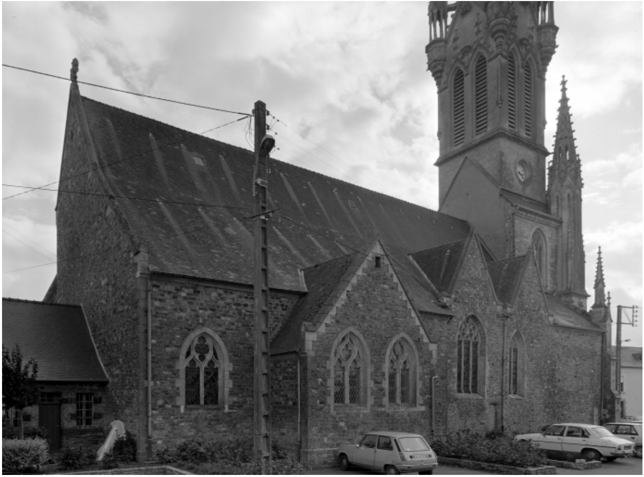
Elévation nord, vue générale.
