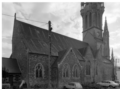
Elévation nord, vue générale. Phot. Guy Artur, Phot. Norbert Lambart IVR53_19873500187V
