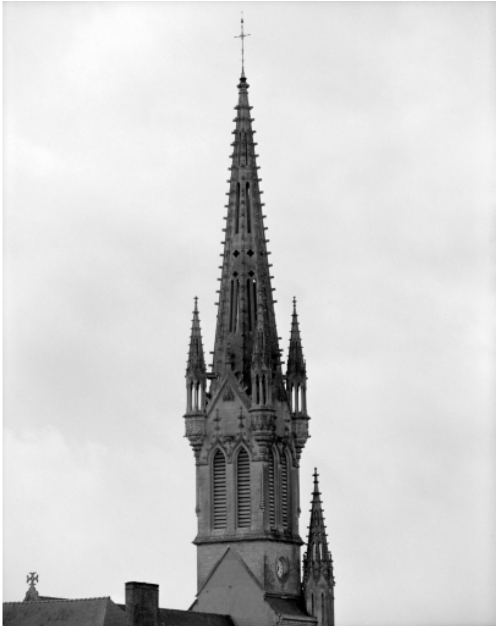
Clocher, partie supérieure : vue générale.
