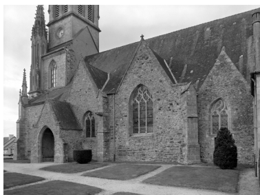
Elévation sud, vue générale. Phot. Guy Artur, Phot. Norbert Lambart IVR53_19873500190V
