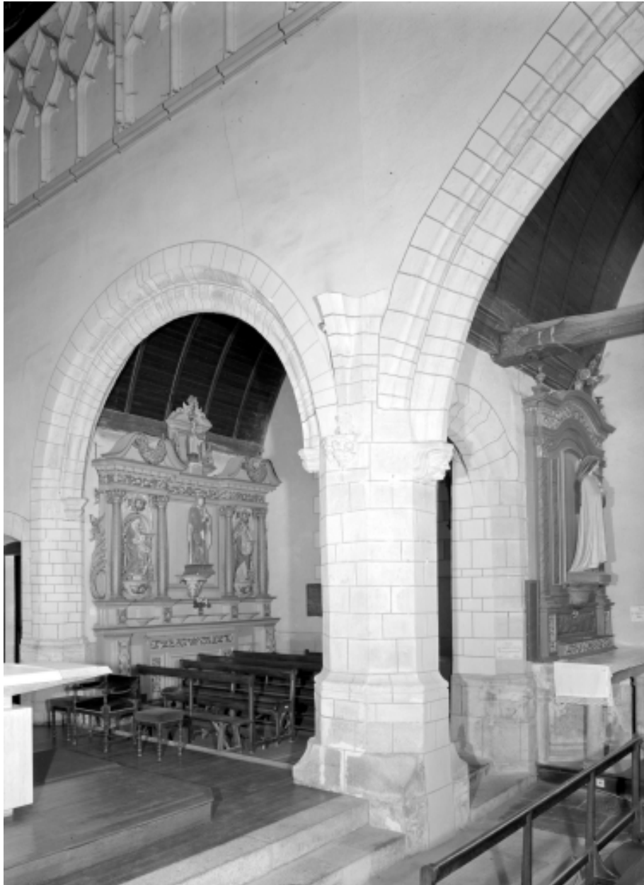
Chapelle 4 sud, vue générale.
