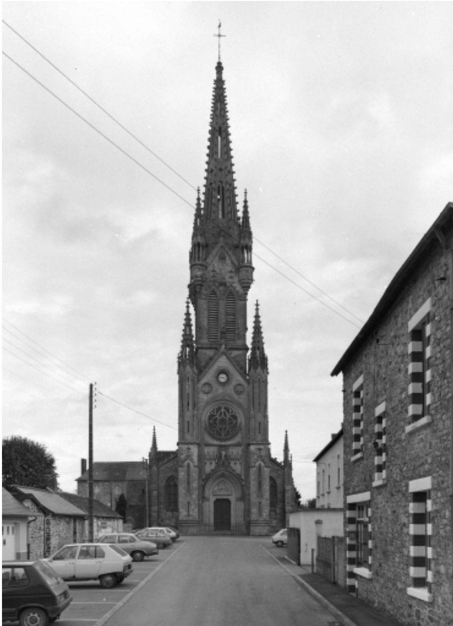
Elévation ouest, vue générale.
