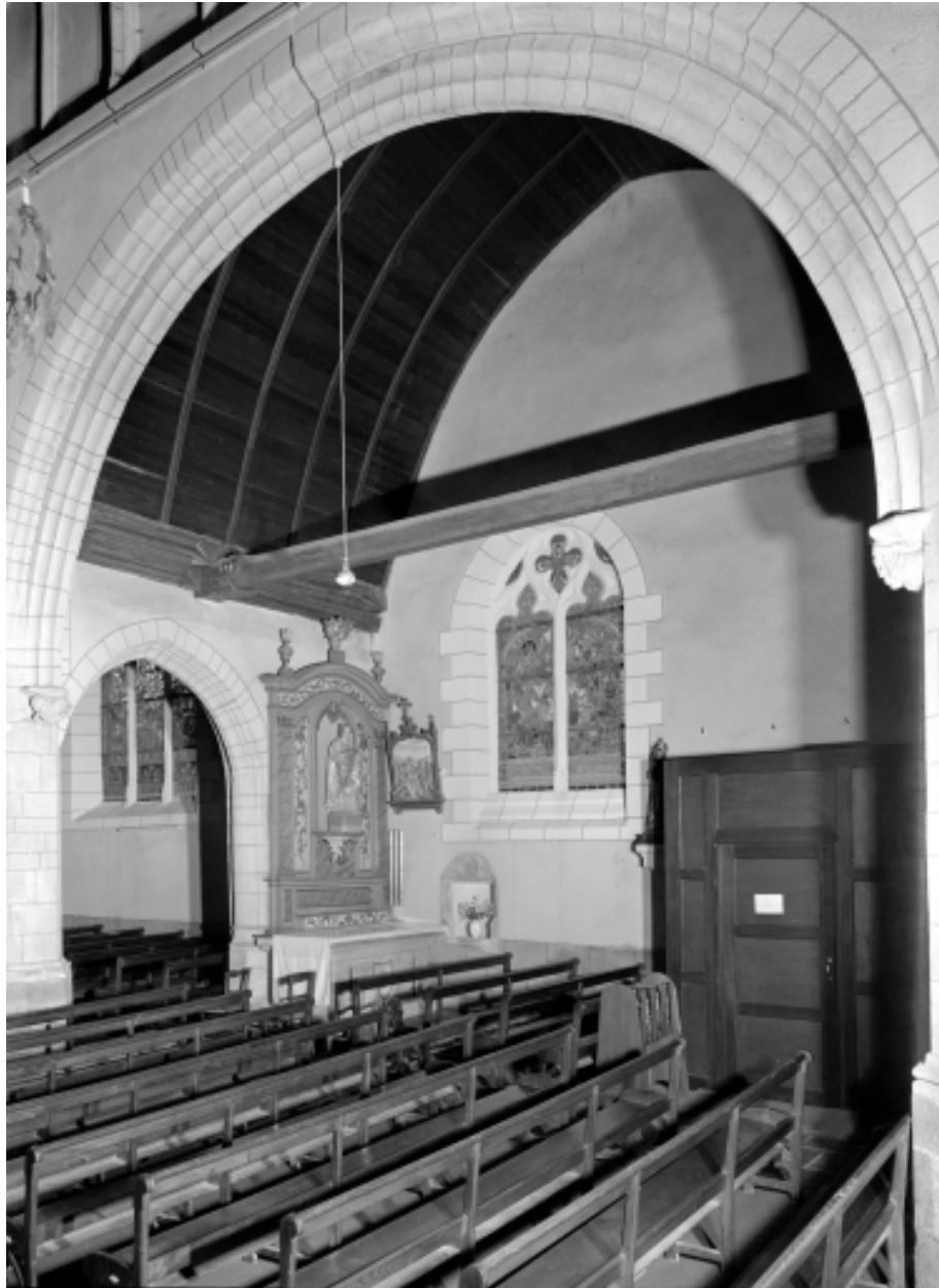
Chapelle 2 sud, vue générale.
