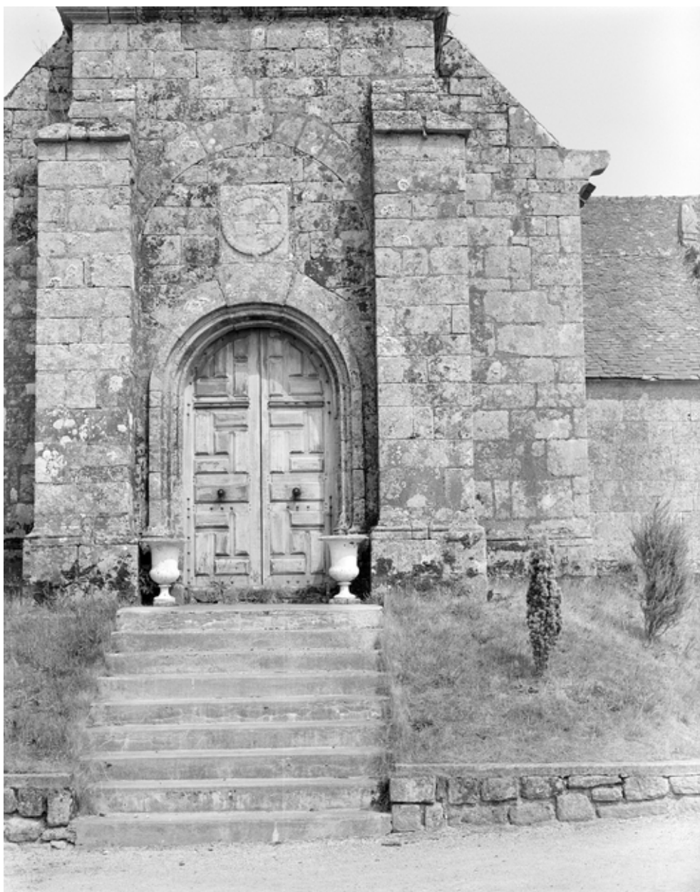
Elévation ouest, 1er niveau : porte et pierre armoriée
