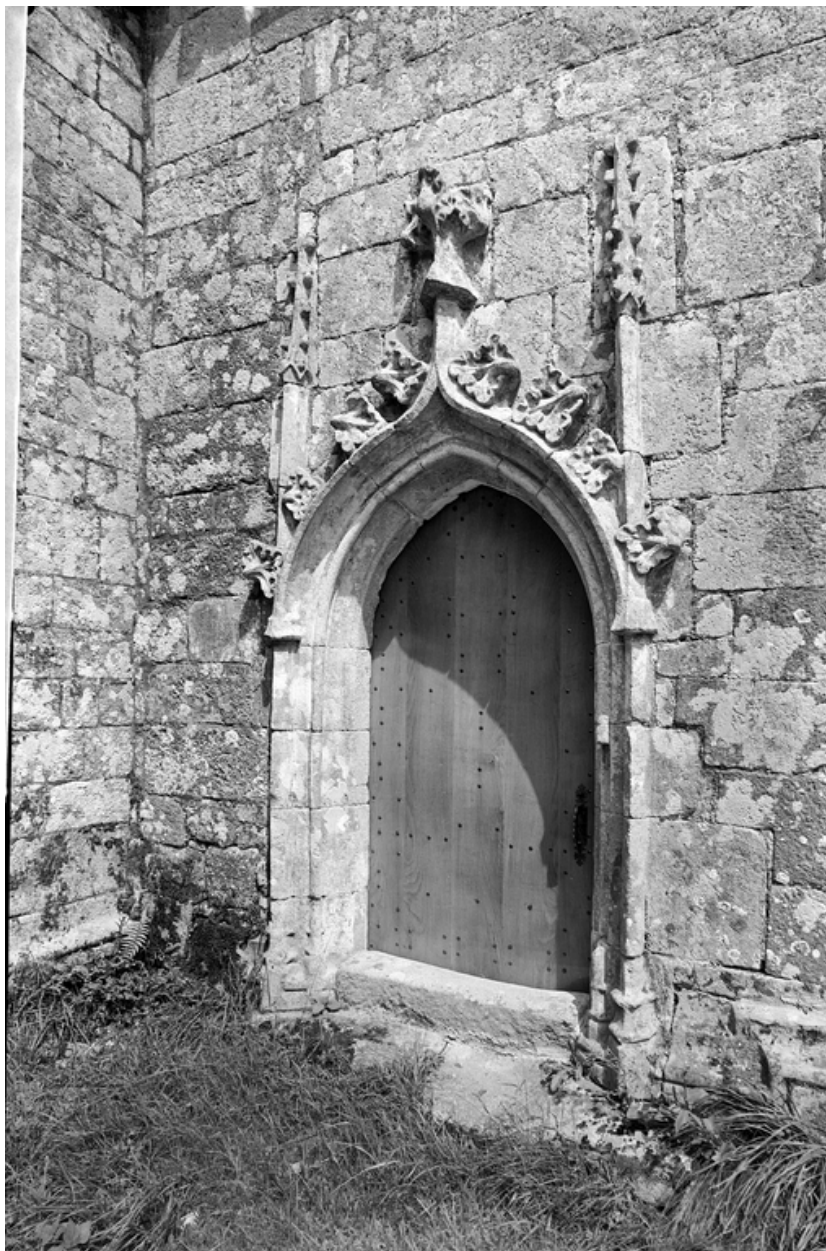
Croisillon sud, face ouest : détail de la porte
