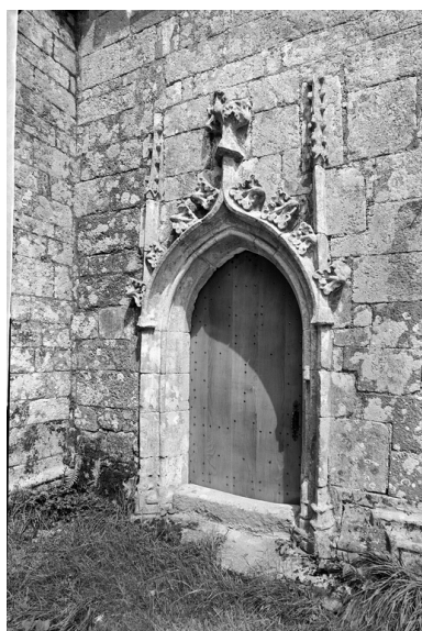
Croisillon sud, face ouest : détail de la porte Phot. François Dagorn IVR53_19692200680V
