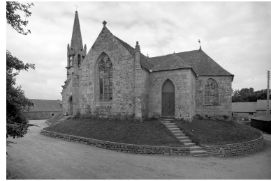
Choeur, extérieur, élévation sud : vue prise du sud est Phot. François Dagorn IVR53_19692200585V
