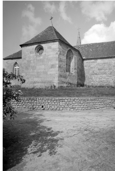
Elévation est : chevet et croisillon nord Phot. François Dagorn IVR53_19692200586V
