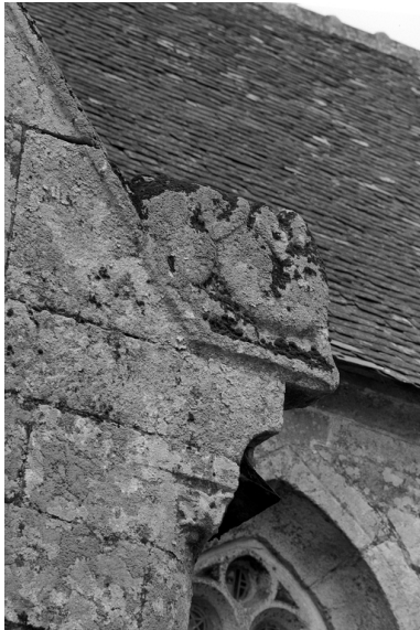
Porche sud, détail de la pierre d'assise sculptée du rampant est Phot. François Dagorn IVR53_19692200976X
