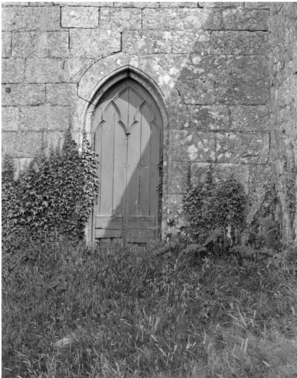
Bras nord du transept : porte du mur ouest
