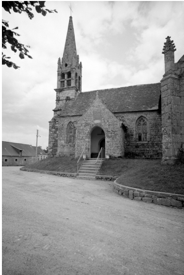
Nef, extérieur, élévation sud : vue prise du sud est Phot. François Dagorn IVR53_19692200590V
