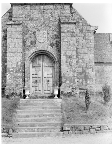
Elévation ouest, 1er niveau : porte et pierre armoriée Phot. François Dagorn IVR53_19762200189X
