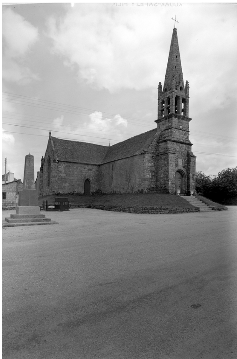
Vue de situation prise du nord ouest
