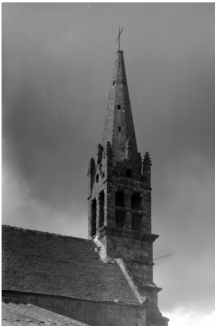
Détail du clocher : vue prise du nord est
