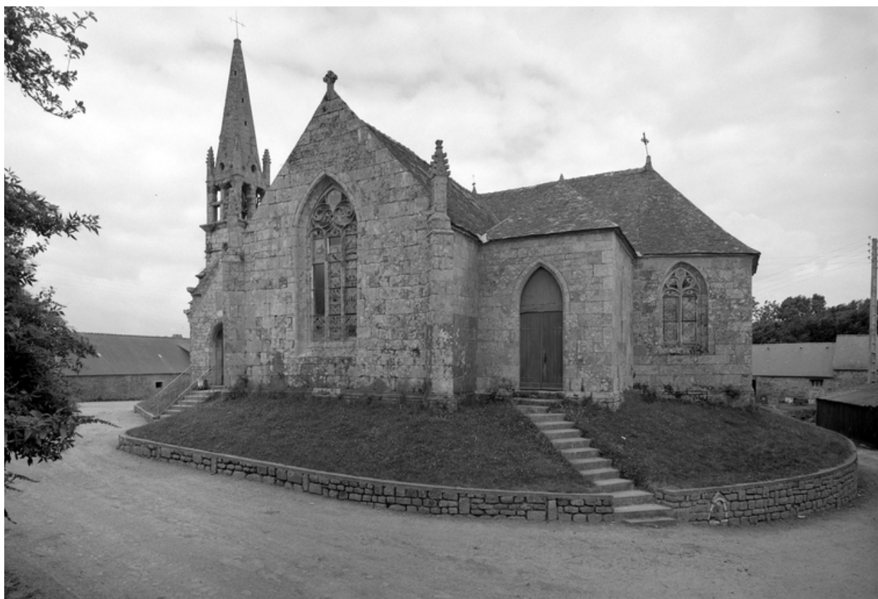
Choeur, extérieur, élévation sud : vue prise du sud est
