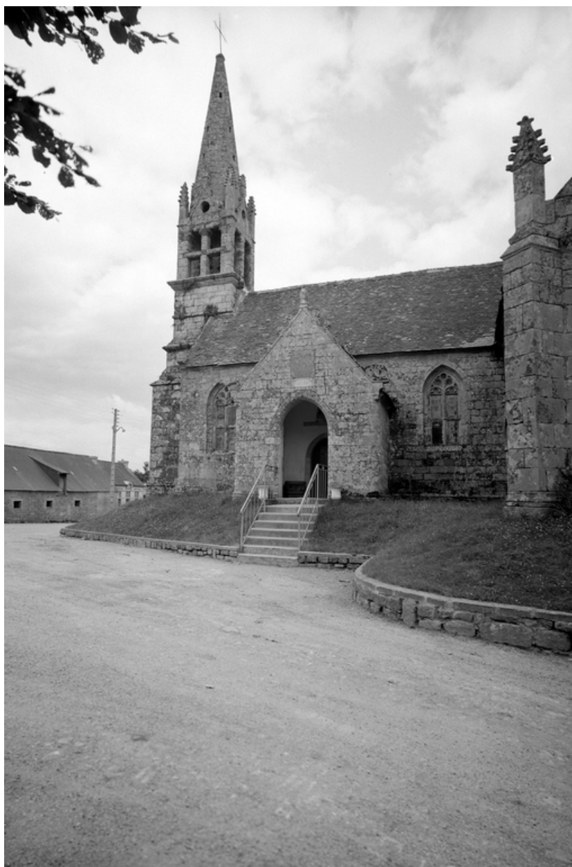
Nef, extérieur, élévation sud : vue prise du sud est
