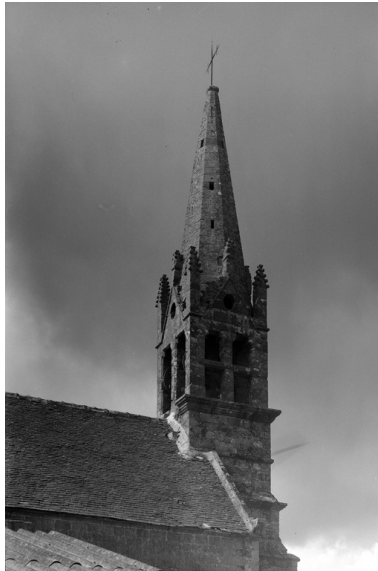
Détail du clocher : vue prise du nord est Phot. François Dagorn IVR53_19692200588V
