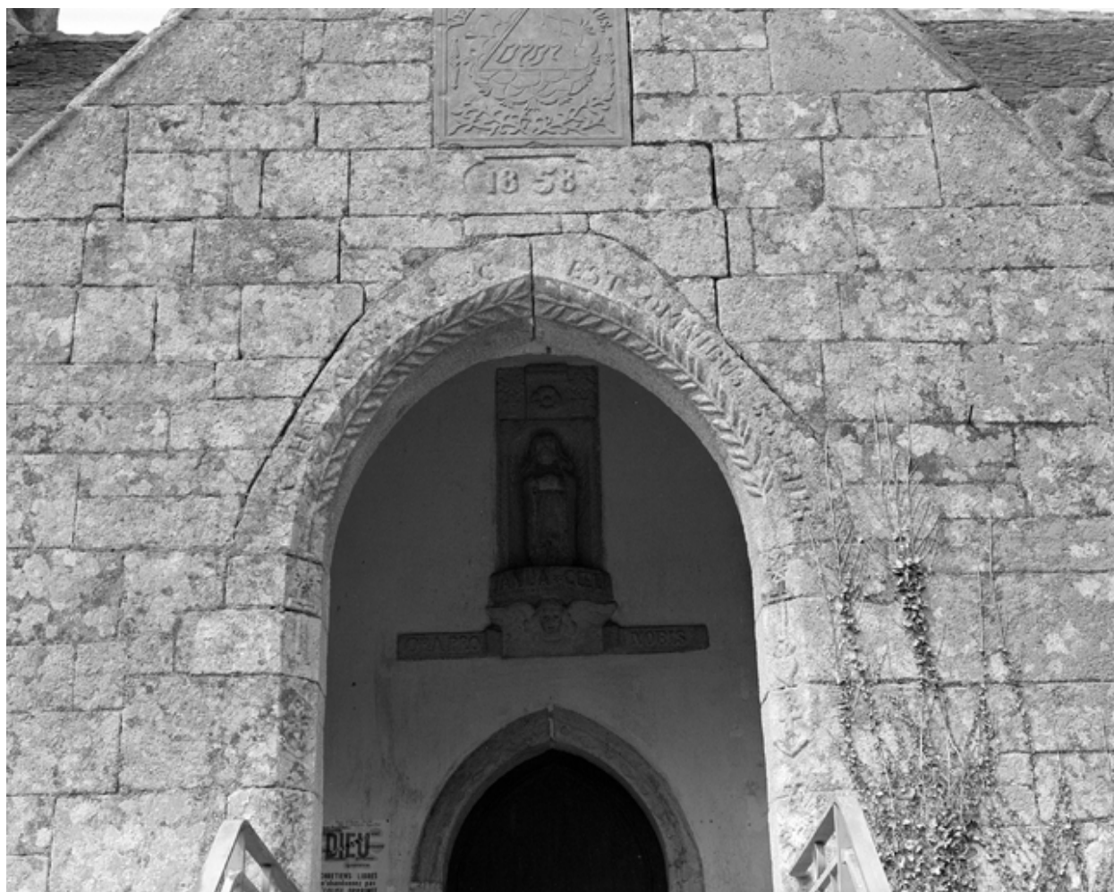
Porche sud : détail de l'arc de la porte d'entrée
