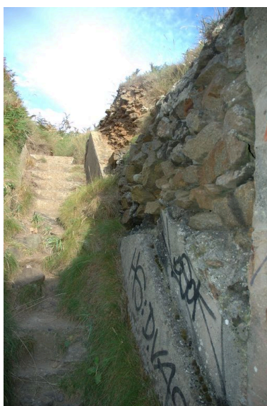
Vue de l'ensemble fortifié d'Illien (Stützpunkt Kerlouchouan) (Re 38,
