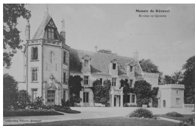
Vue générale de la façade principale Phot. Elise Lauranceau, Autr. Villard IVR53_20032902767NUCB
