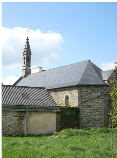
Pleyben, Chapelle-Neuve : vue générale sud-est Phot. Gwénaél Fauchille IVR53_20082905652NUCA
