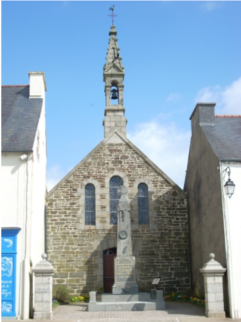
Pleyben, Chapelle-Neuve : élévation ouest
