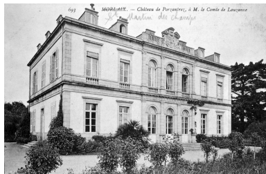
Vue générale Phot. Elise Lauranceau IVR53_20042905570NUCB
