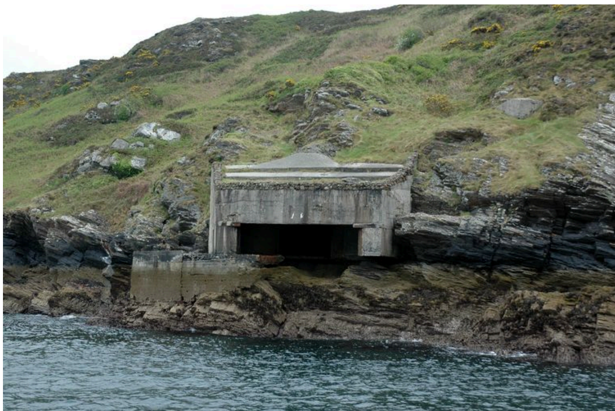
Roscanvel : vue générale du poste lance-torpilles de la pointe de Cornouaille. Situé au ras de l'eau, à l'est de la batterie de Beaufort
