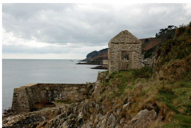
Plouzané : vue générale du poste lance-torpilles expérimental du Mengant Phot. Guillaume Lécueillier IVR53_20062906869NUCA
