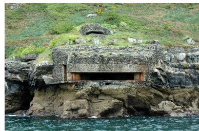
Roscanvel : vue générale du poste lance-torpilles de la pointe Robert. Poste situé au ras de l'eau, à l'ouest de la caserne défensive Phot. Guillaume Lécueillier IVR53_20062907042NUCA
