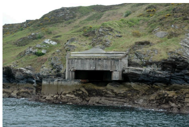
Roscanvel : vue générale du poste lance-torpilles de la pointe de Cornouaille. Situé au ras de l'eau, à l'est de la batterie de Beaufort Phot. Guillaume Lécueillier IVR53_20062907043NUCA
