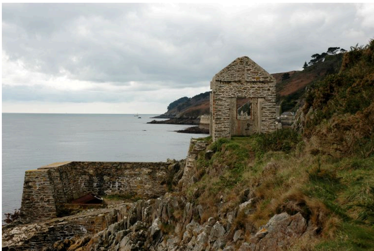
Plouzané : vue générale du poste lance-torpilles expérimental du Mengant
