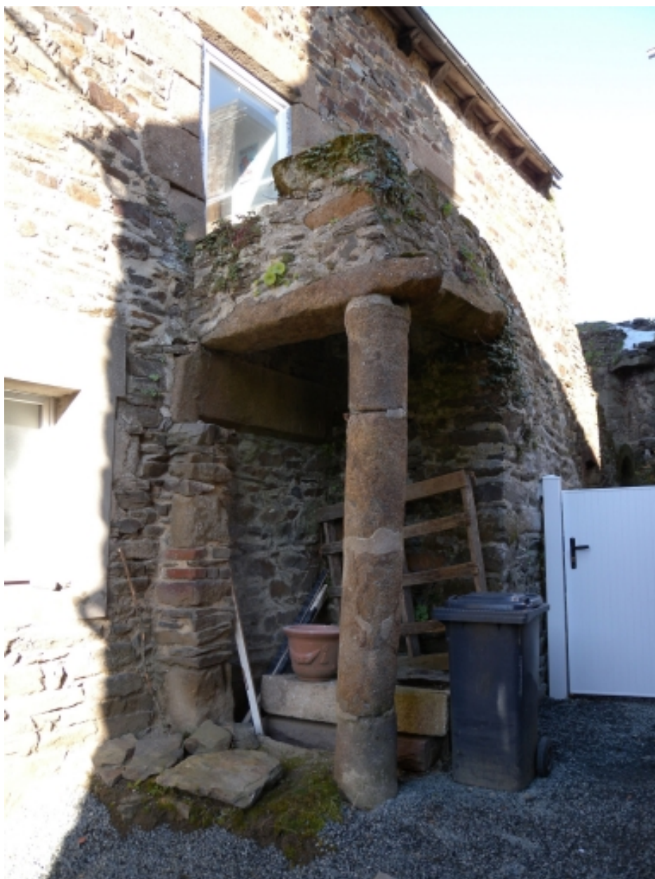
Vue du poteau en granite (pilastre), supportant un escalier extérieur, daté de la Renaissance d'une maison au port du Légué
