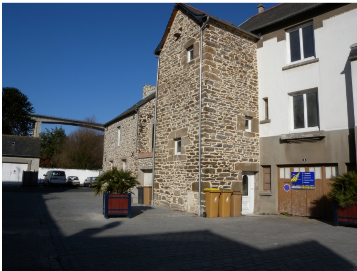
Vue d'une façade d'un immeuble restauré daté du 17ème siècle
