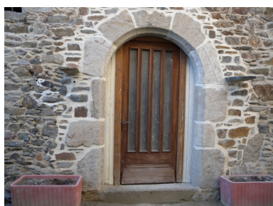
Vue de détail d'une ouverture en plein cintre, rue des Frères Durand Phot. Guy Prigent IVR53_20082213304NUCA
