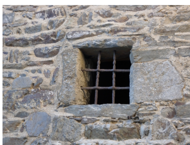
Vue de détail d'une ouverture avec grille en fer forgé, datée du 15ème, rue des Frères Durand Phot. Guy Prigent IVR53_20082213303NUCA
