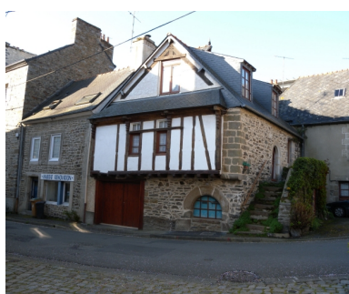
Maison traditionnelle à pans de bois du Légué, 9 rue des Frères Durand (date portée sur le linteau d'une ouverture, 1691) Phot. Guy Prigent IVR53_20082212980NUCA
