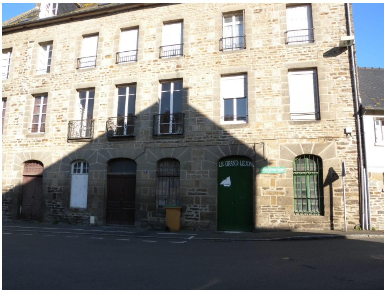
Vue d'une ancienne maison d'armateur
