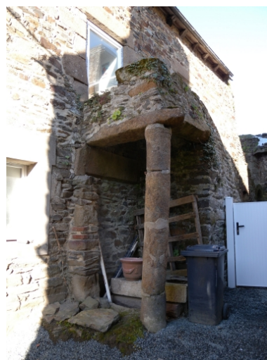
Vue du poteau en granite (pilastre), supportant un escalier extérieur, daté de la Renaissance d'une maison au port du Légué Phot. Guy Prigent
