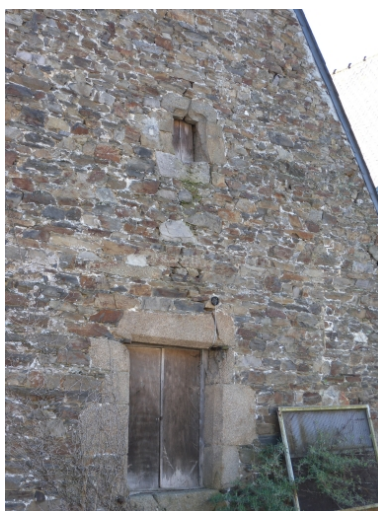
Vue des ouvertures de la façade postérieure d'anciens entrepôts du Légué, daté du 15ème ou 16ème siècle Phot. Guy Prigent
