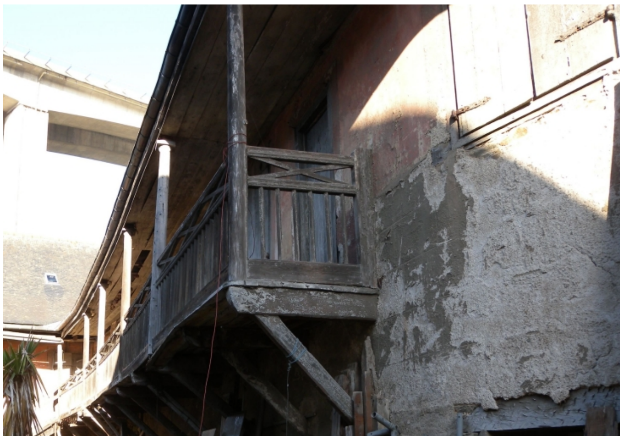
Vue du balcon en bois, daté du 16ème siècle, d'une maison en front de port
