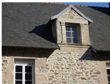
Vue d'une ancienne fenêtre avec pilastre de la Renaissance (16ème siècle) Phot. Guy Prigent IVR53_20082213299NUCA
