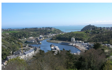
Vue générale du Légué Phot. Auteur inconnu IVR53_20092205033NUCA
