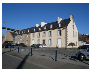
Vue d'une ancienne maison d'armateur, à plusieurs travées, devant les quais du chanoine Guinard (bâtiments du Conservatoire du Littoral) Phot. Guy Prigent IVR53_20082213300NUCA
