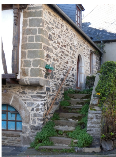
Vue de la façade avec escalier extérieur, rénovée et remaniée Phot. Guy Prigent
