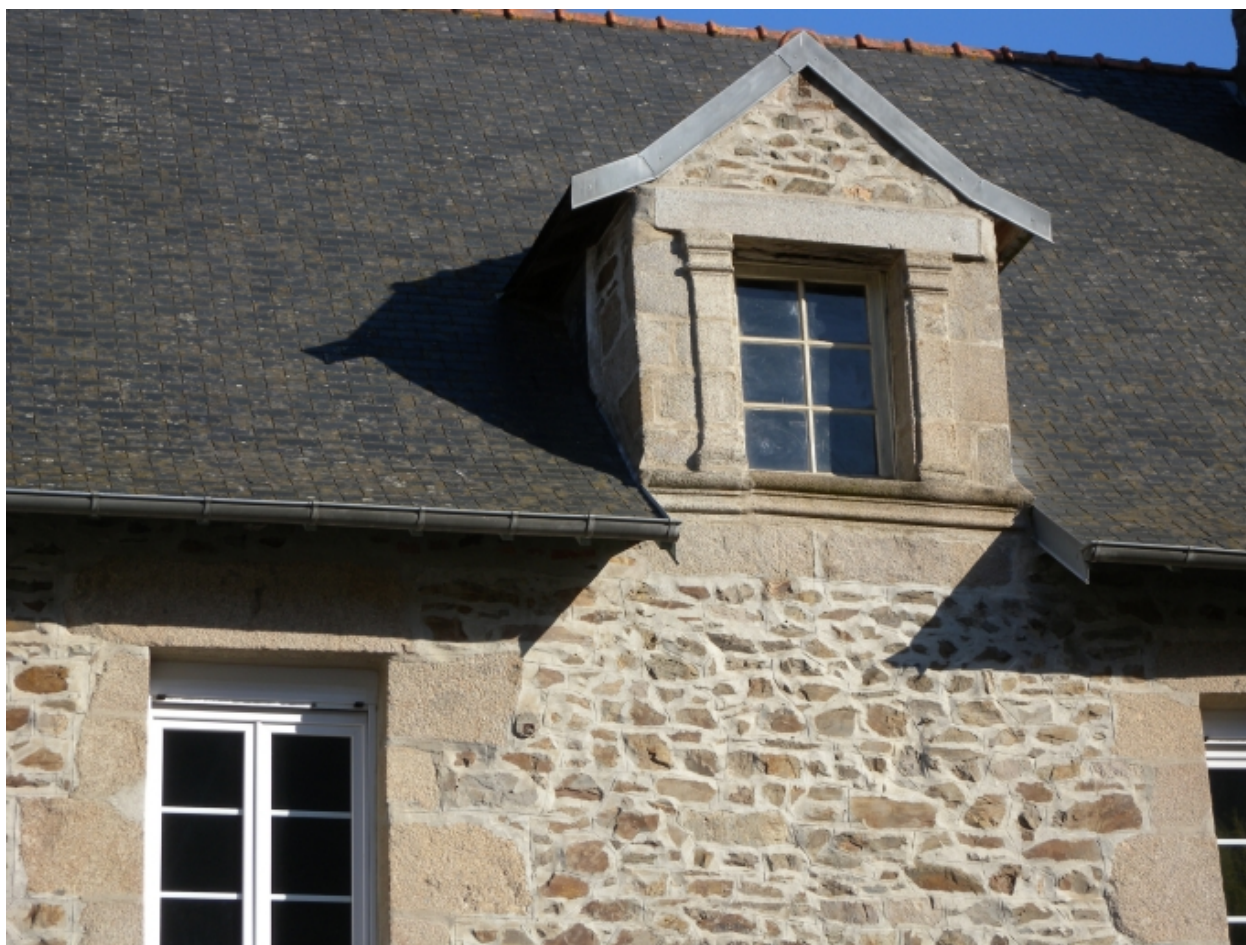
Vue d'une ancienne fenêtre avec pilastre de la Renaissance (16ème siècle)
