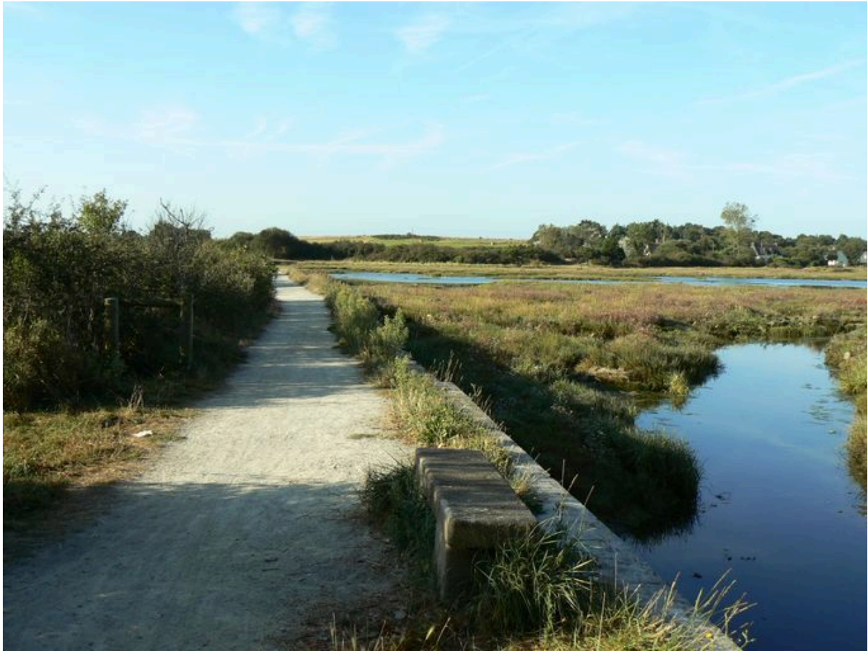
Digue-route dite le Pont Lisse
