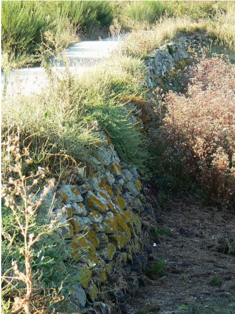
Digue-route dite le Pont Lisse
