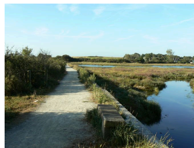
Digue-route dite le Pont Lisse Phot. Johan Vincent IVR53_20075605780NUCA
