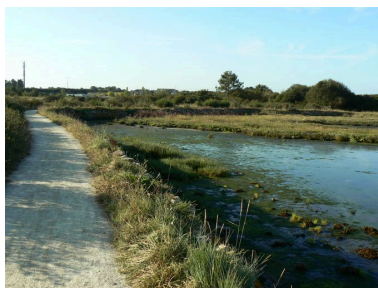
Digue-route dite le Pont Lisse Phot. Johan Vincent IVR53_20075605779NUCA
