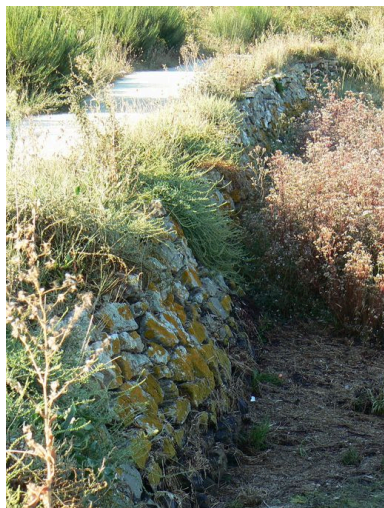
Digue-route dite le Pont Lisse Phot. Johan Vincent IVR53_20075605781NUCA
