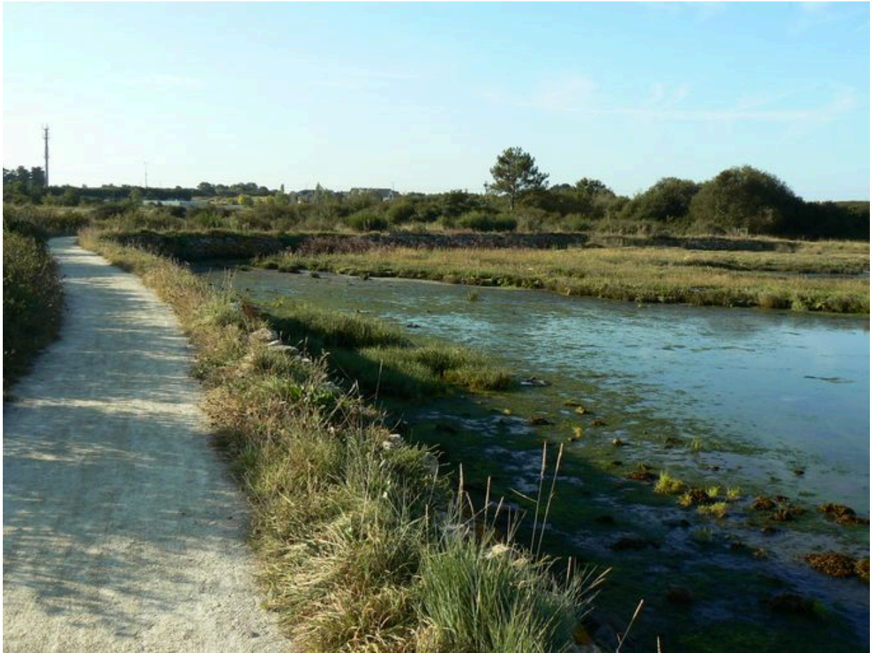
Digue-route dite le Pont Lisse
