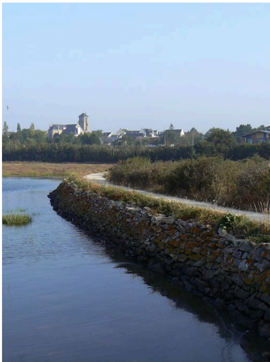
Vue générale de la digue-route dite le Pont Lisse
