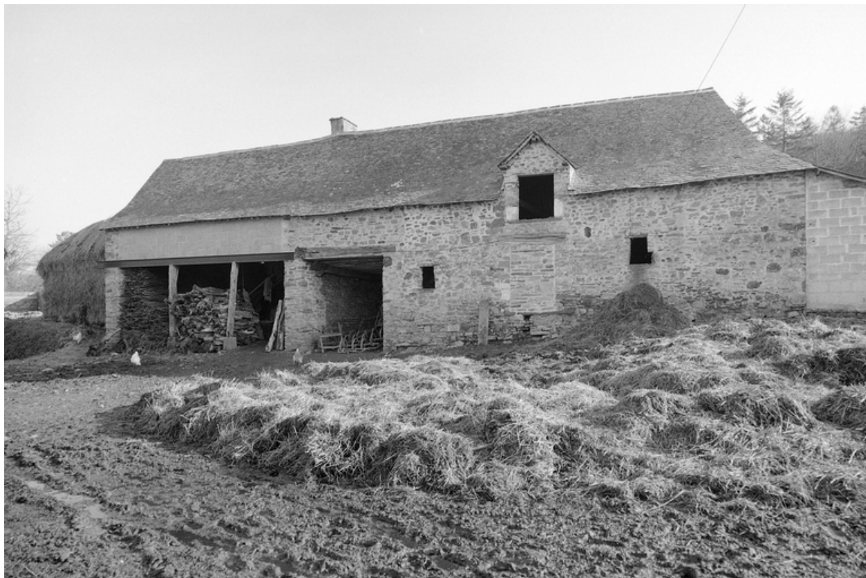
Dépendances, façade sud-ouest.
