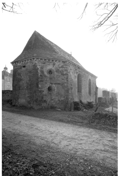
Chapelle, vue nord-est, vue générale. Phot. François Dagorn IVR53_19713500093V
