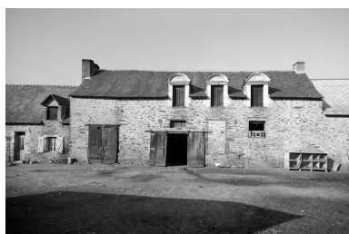
Façade, partie centrale, vue générale. Phot. François Dagorn IVR53_19713500104V
