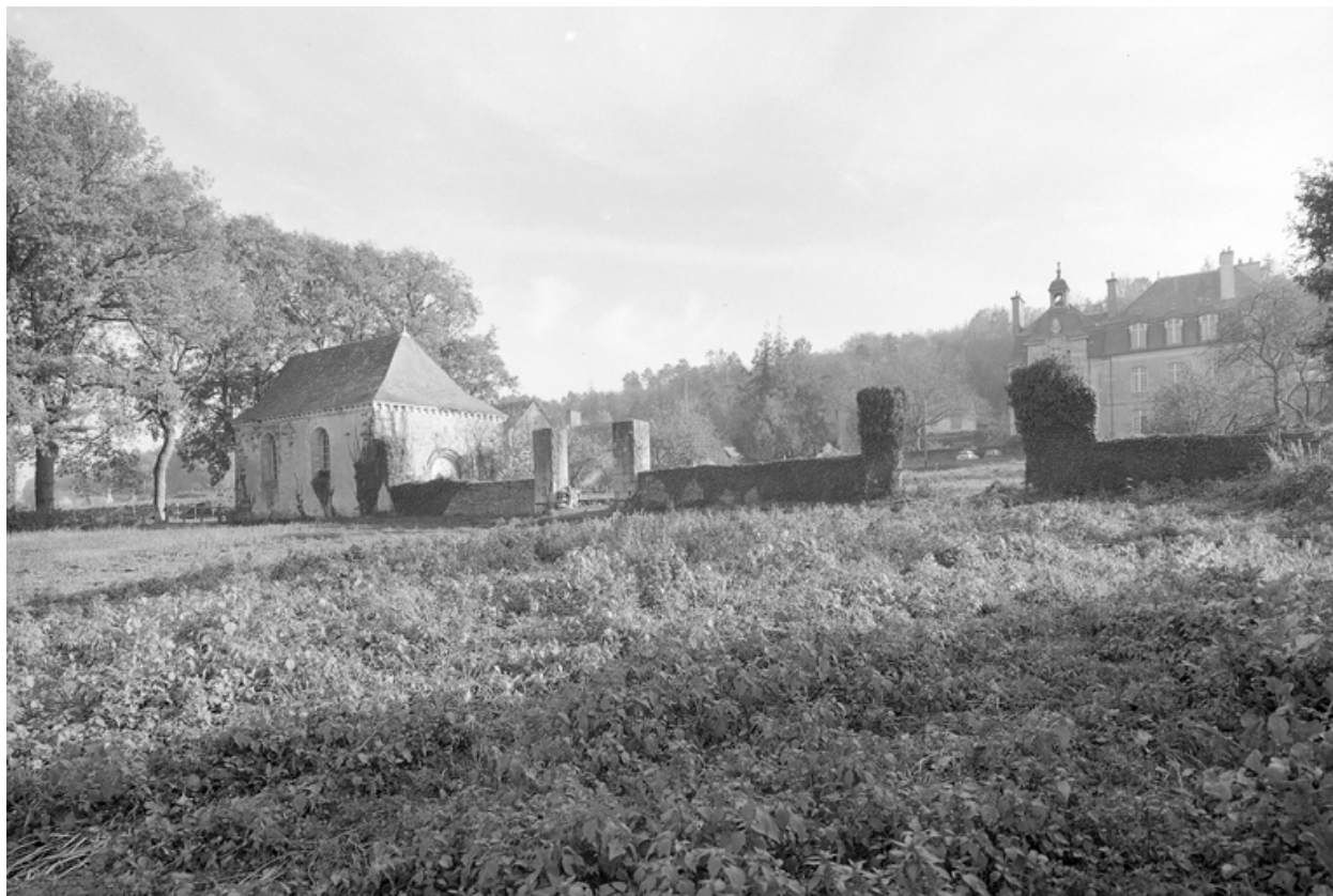
Vue prise du nord.
