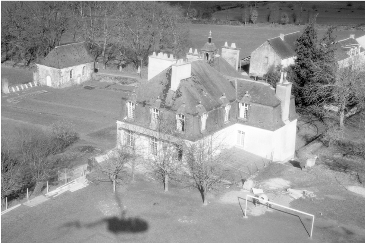
Vue aérienne prise du sud-ouest.
