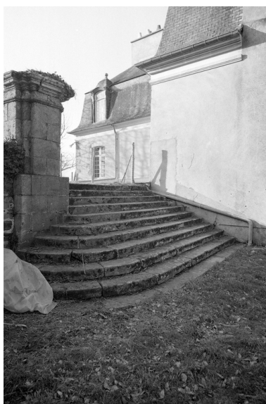
Jardin, escalier latéral ouest. Phot. François Dagorn IVR53_19713500095V
