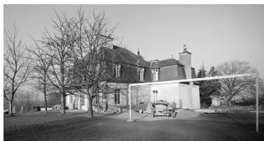
Vue générale sud-ouest. Phot. François Dagorn IVR53_19713500096V
