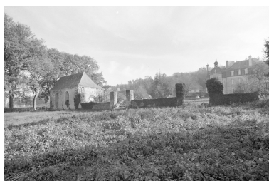
Vue prise du nord. Phot. François Dagorn IVR53_19673500137V
