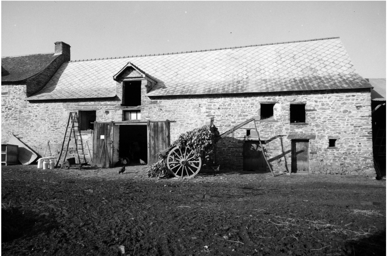
Dépendances, façade, partie est.
