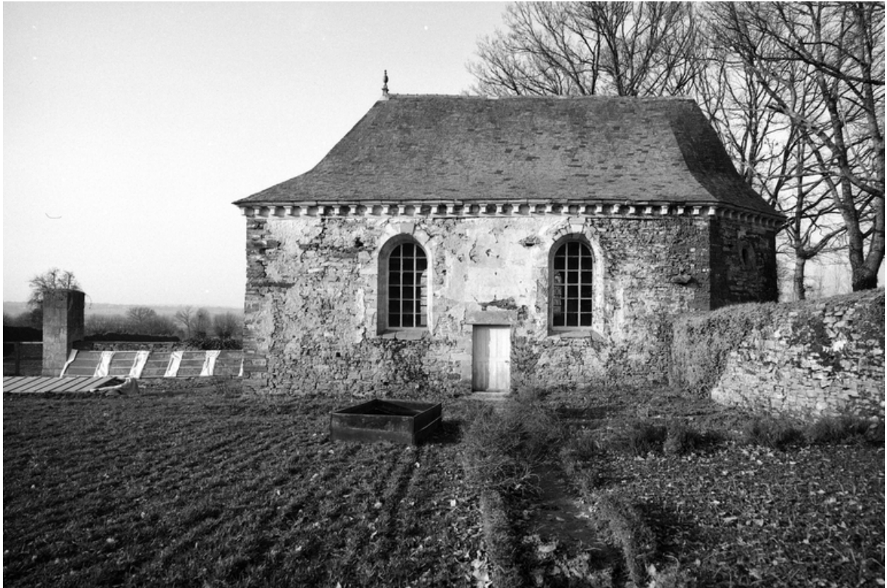
Chapelle, face sud, vue générale.
