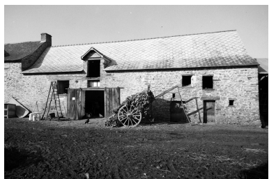
Dépendances, façade, partie est. Phot. François Dagorn IVR53_19713500105V
