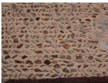
Détail : mur sud de la nef Phot. Claude Quillivic IVR53_20043503908NUCA
