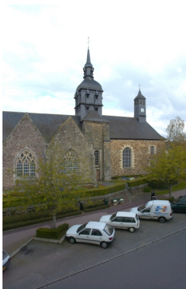
Vue partielle sud Phot. Norbert Lambart IVR53_20043500510NUCA
