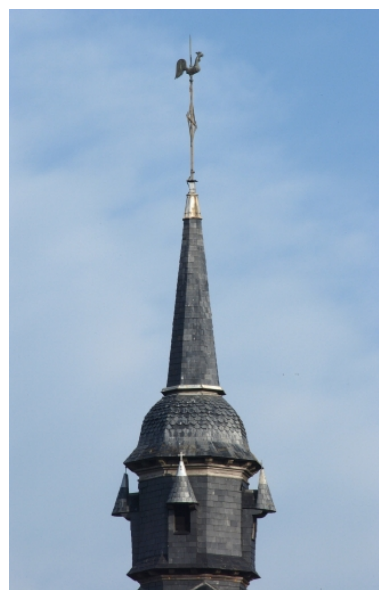
Flèche au sommet du clocher Phot. Norbert Lambart IVR53_20043500252NUCA
