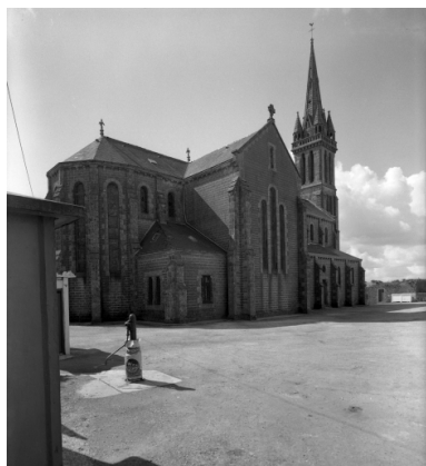
Saint-Ségal, église paroissiale Saint-Séverin : vue générale nord-est, état en 1972 Phot. François Dagorn IVR53_19722900669V
