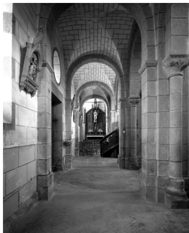
Saint-Ségéal, église paroissiale Saint-Séverin : intérieur, bas-côté nord, état en 1972 Phot. François Dagorn IVR53_19722900568V
