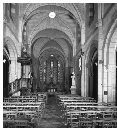
Saint-Ségal, église paroissiale Saint-Séverin : intérieur, nef vers l'est, état en 1972 Phot. François Dagorn IVR53_19722900566V
