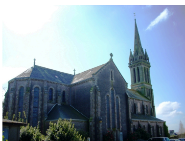
Saint-Ségal, église paroissiale Saint- Séverin : vue générale nord-est Phot. Gwénaél Fauchille IVR53_20082905607NUCA
