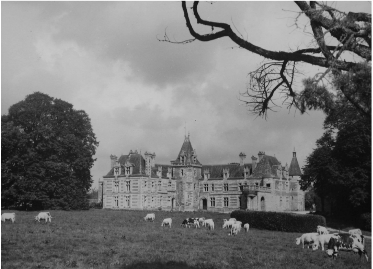
Vue de situation (C.R.M.H. Bretagne)
