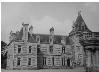
Détail de la façade est : aile et pavillon ouest (C.R.M.H. Bretagne) Phot. Elise Lauranceau IVR53_20033517767NUC
