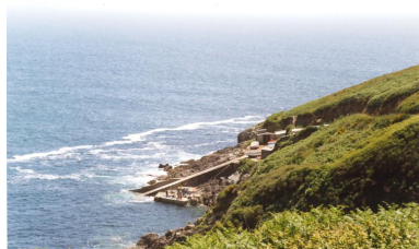
Vue générale prise du nord. (1999) Phot. A.O.C.D. IVR53_20192907517PB
