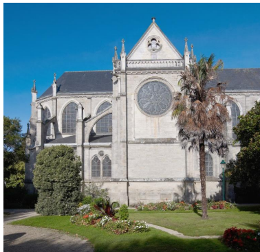
Le transept sud de l'église Phot. Bègne Bernard IVR53_20195600327NUCA
