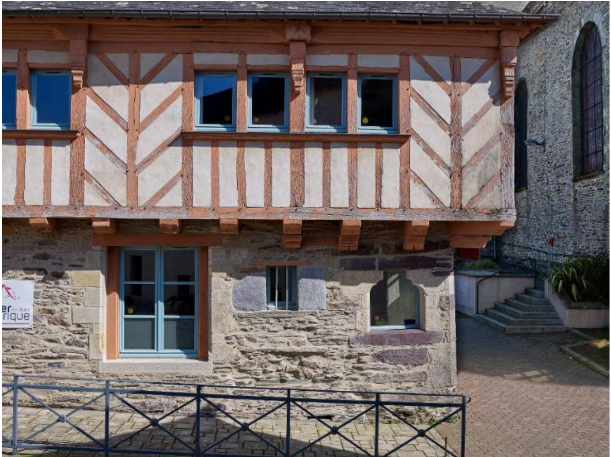
Façade ouest de l'édifice en pan de bois, maison d'angle.
