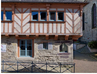
Façade ouest de l'édifice en pan de bois, maison d'angle. Phot. Bernard Bègne IVR53_20215600279NUCA
