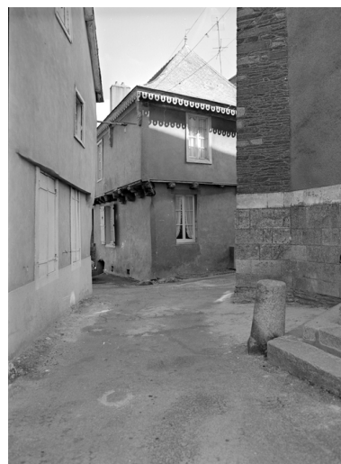
Maison, 9 Carrefour Saint-Gurval, vue prise du sud-ouest. Phot. Auteur inconnu IVR53_19775601005X
