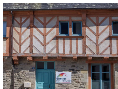
Vue rapprochée du pan de bois du premier étage. Phot. Bernard Bègne IVR53_20215600278NUCA
