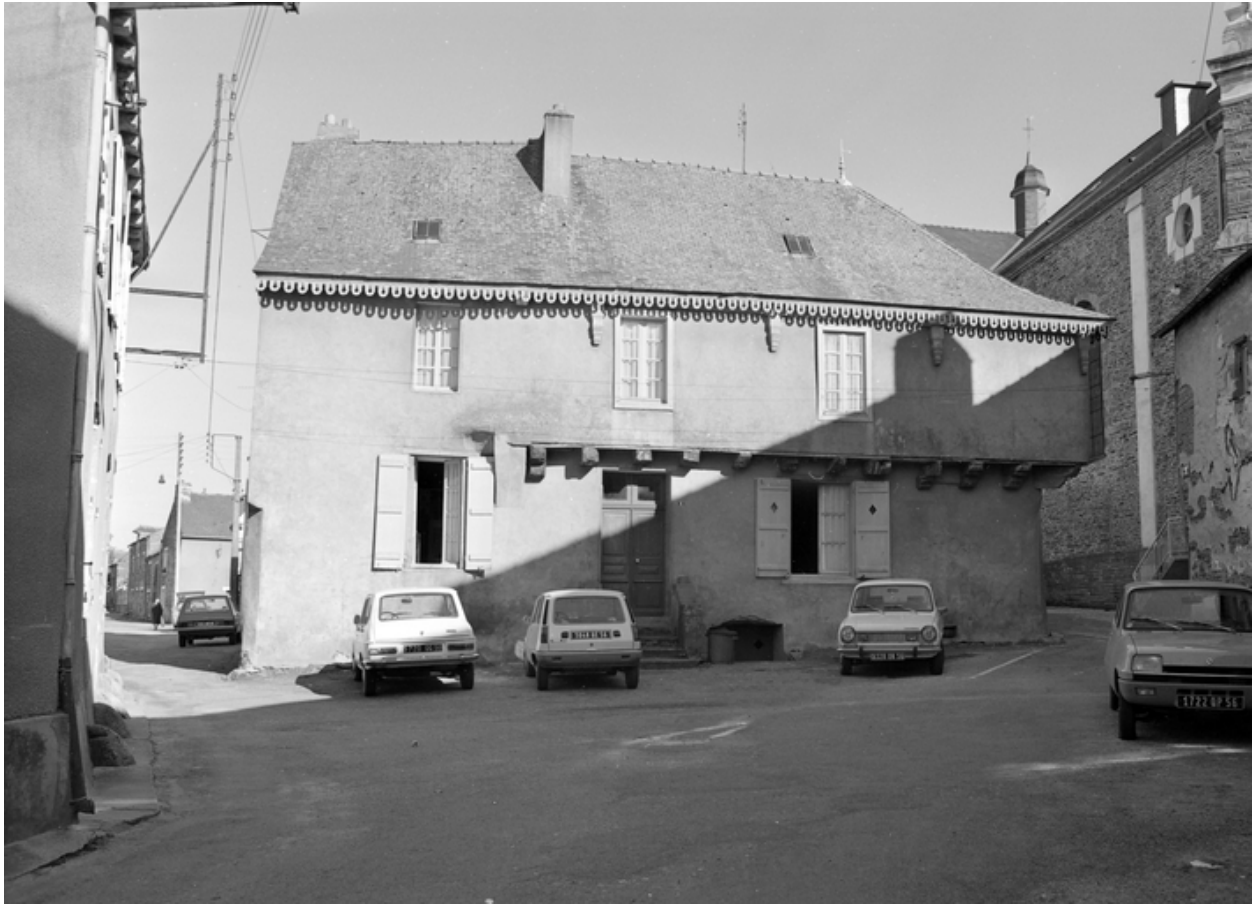
Maison, 9 Carrefour Saint-Gurval, vue générale ouest.
