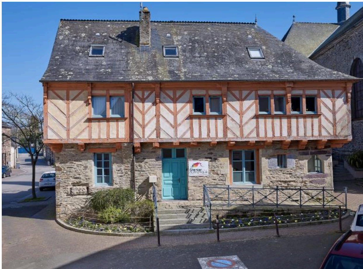
Façade ouest de l'édifice en pan de bois.
