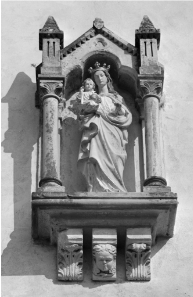
Elévation Sud, niche : vue générale
