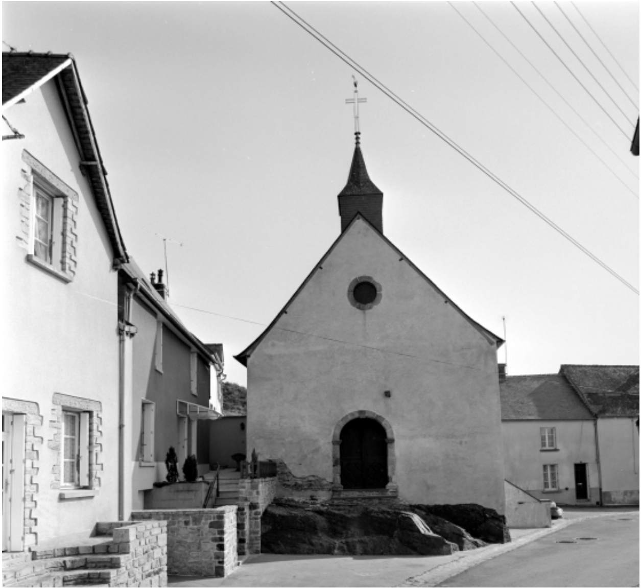
Elévation Ouest : vue générale
