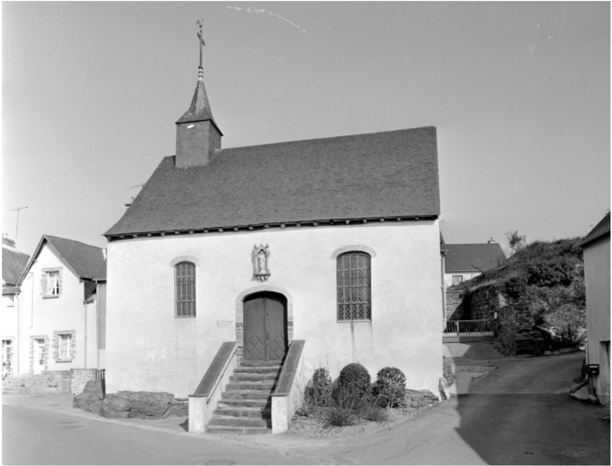
Elévation Sud : vue générale
