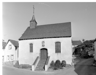
Elévation Sud : vue générale Phot. Bernard Bègne, Phot. M. Loyon IVR53_19933500165X
