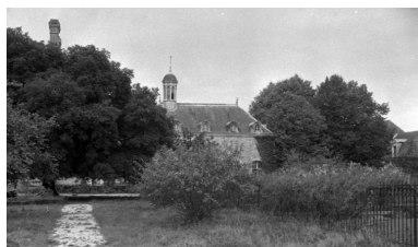
Orangerie, vue générale. Phot. Galbrun IVR53_19823501285Z
