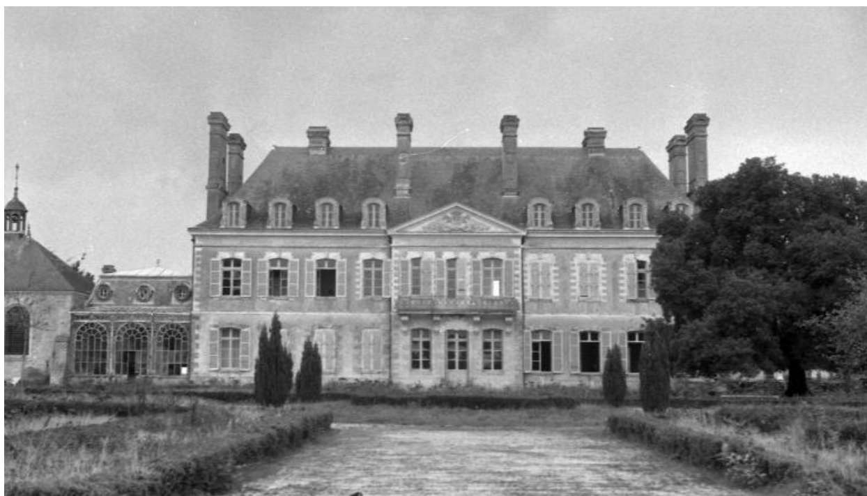
Vue générale sud.
