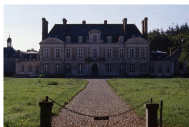
Élévation antérieure : vue générale Phot. Claude Quillivic IVR53_19943502557ZA
