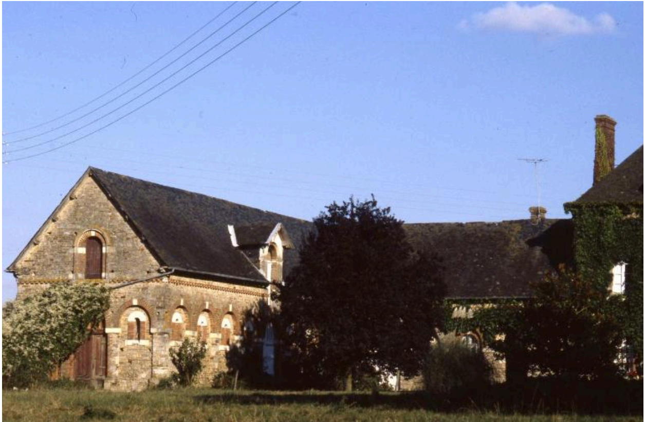
Communs 19è, vue générale.
