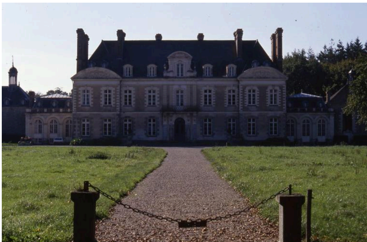
Elévation antérieure : vue générale
