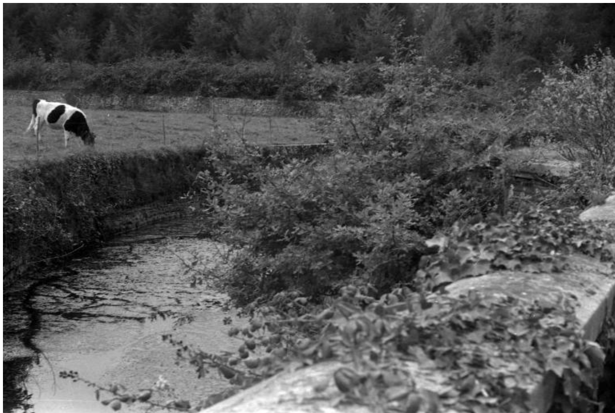
Douves, vue générale.
