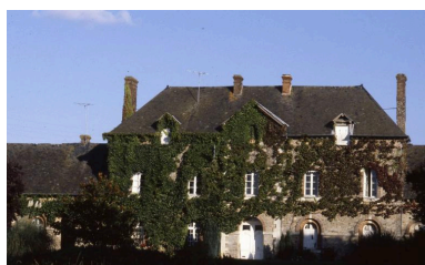
Communs 19è, vue générale. Phot. Roger Barrié IVR53_19873500519ZA
