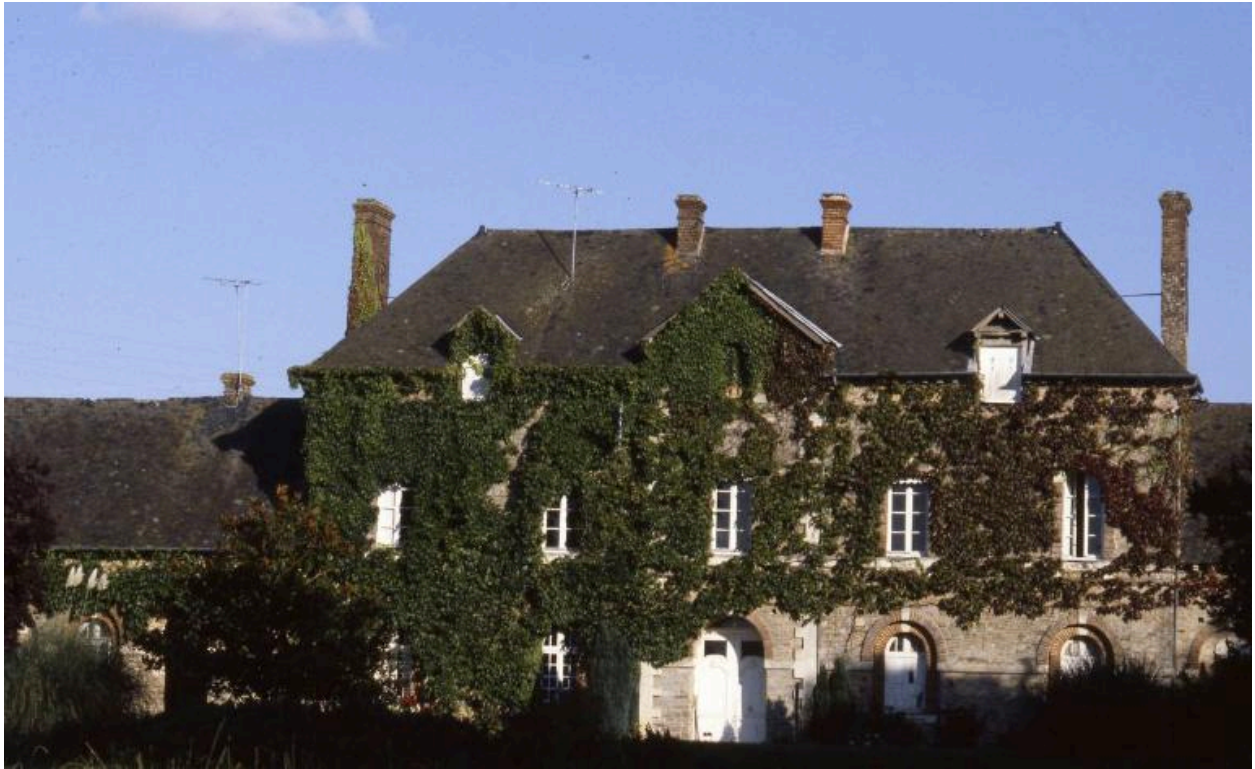
Communs 19è, vue générale.
