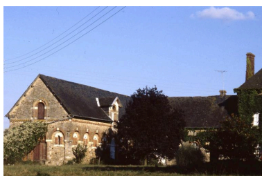
Communs 19è, vue générale. Phot. Roger Barrié IVR53_19873500520ZA
