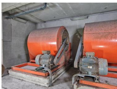
Vue de la salle des ventilateurs : les deux ventilateurs industriels de marque Fevi sont entraînés par des moteurs électriques via des courroies. Les carters de protection ont été déposés
