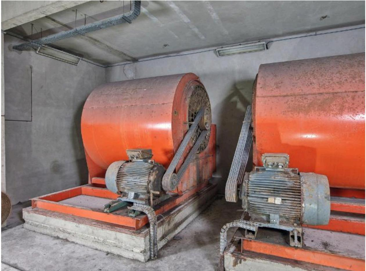
Vue de la salle des ventilateurs : les deux ventilateurs industriels de marque Fevi sont entraînés par des moteurs électriques via des courroies. Les carters de protection ont été déposés
