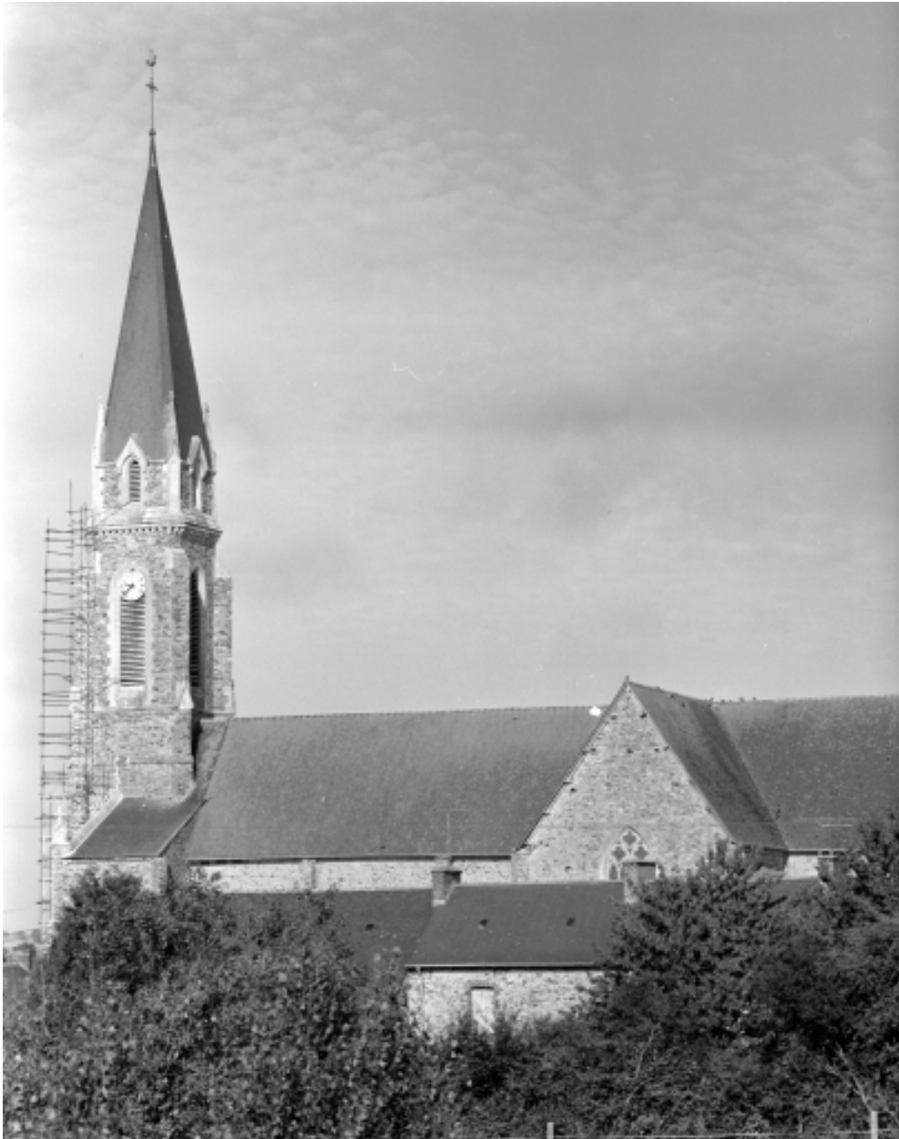
Elévation sud, clocher
