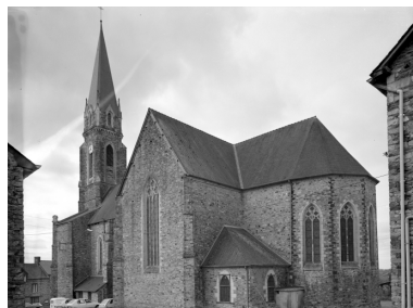
Elévation sud-est Phot. Jean-Pierre Ducouret IVR53_19823501369V
