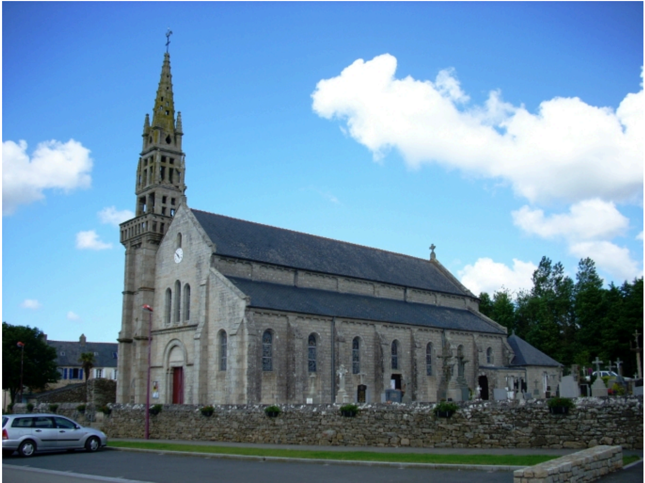
Trégarantec, église Saint-Théarnec : vue générale sud-ouest
