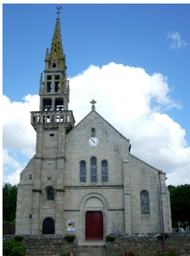
Trégarantec, église Saint-Théarnec : élévation ouest Phot. Gwénaél Fauchille IVR53_20082905991NUCA
