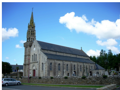
Trégarantec, église Saint-Théarnec : vue générale sud-ouest Phot. Gwénaél Fauchille IVR53_20082905990NUCA
