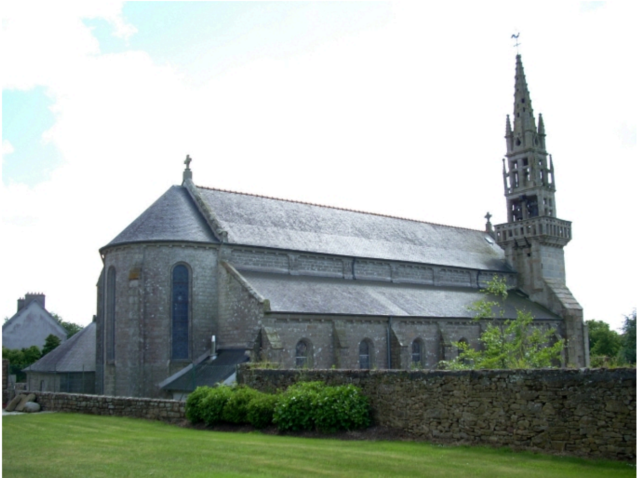
Trégarantec, église Saint-Théarnec : vue générale nord-est
