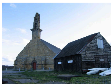
Vue générale de la chapelle Notre-Dame-de-Rocamadour Phot. Françoise Péron IVR53_20062908377NUCA
