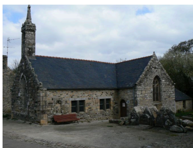
Vue de l'église de Saint-Fiacre Phot. Julien Amghar IVR53_20072908870NUCA
