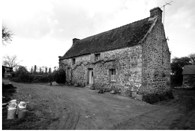
Vue générale sud Phot. François Dagorn IVR53_19662200226V
