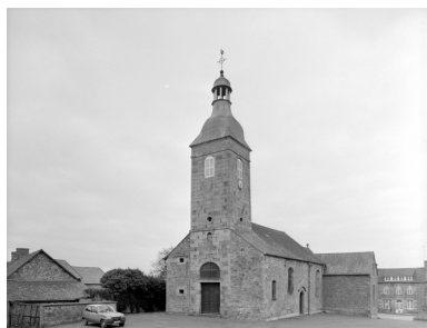
Elévation Sud-Ouest : vue générale Phot. A. Boden IVR53_19943500117X
