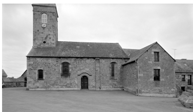
Elévation Sud, partie Ouest : vue générale Phot. A. Boden IVR53_19943500118X
