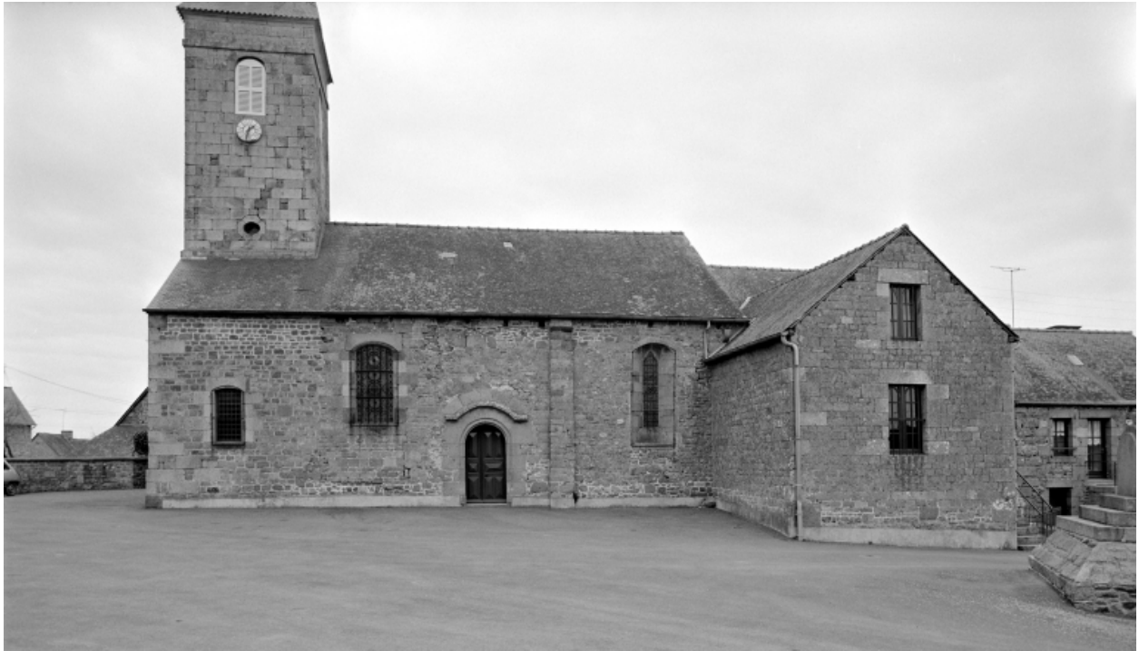
Elévation Sud, partie Ouest : vue générale
