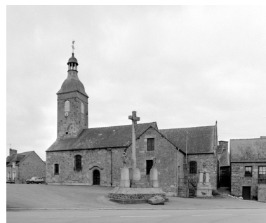
Elévation Sud : vue générale Phot. A. Boden IVR53_19943500119X
