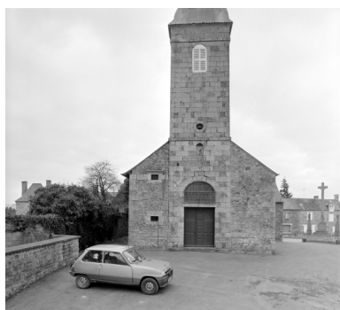
Elévation Ouest : vue générale Phot. A. Boden IVR53_19943500120X
