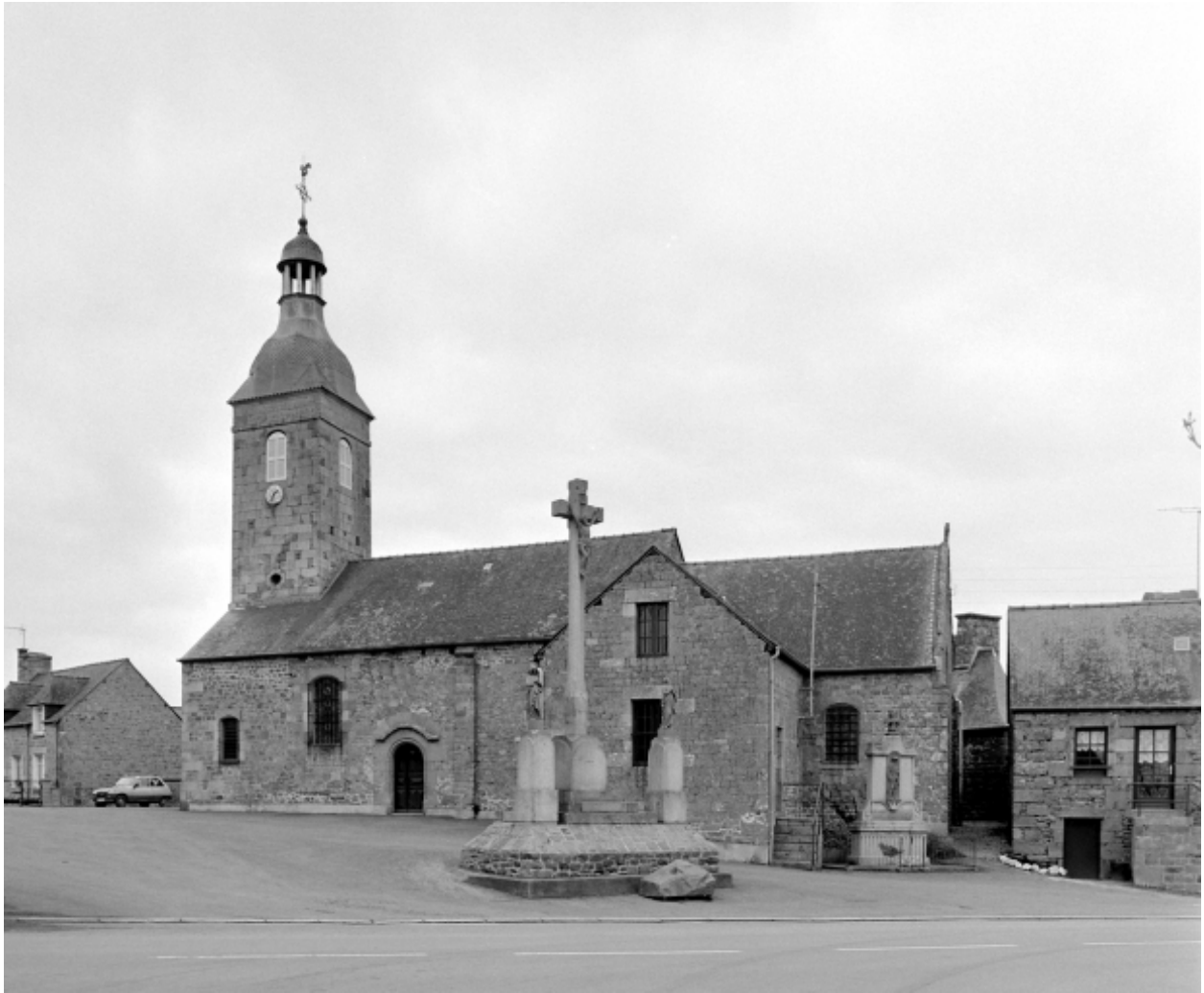
Elévation Sud : vue générale
