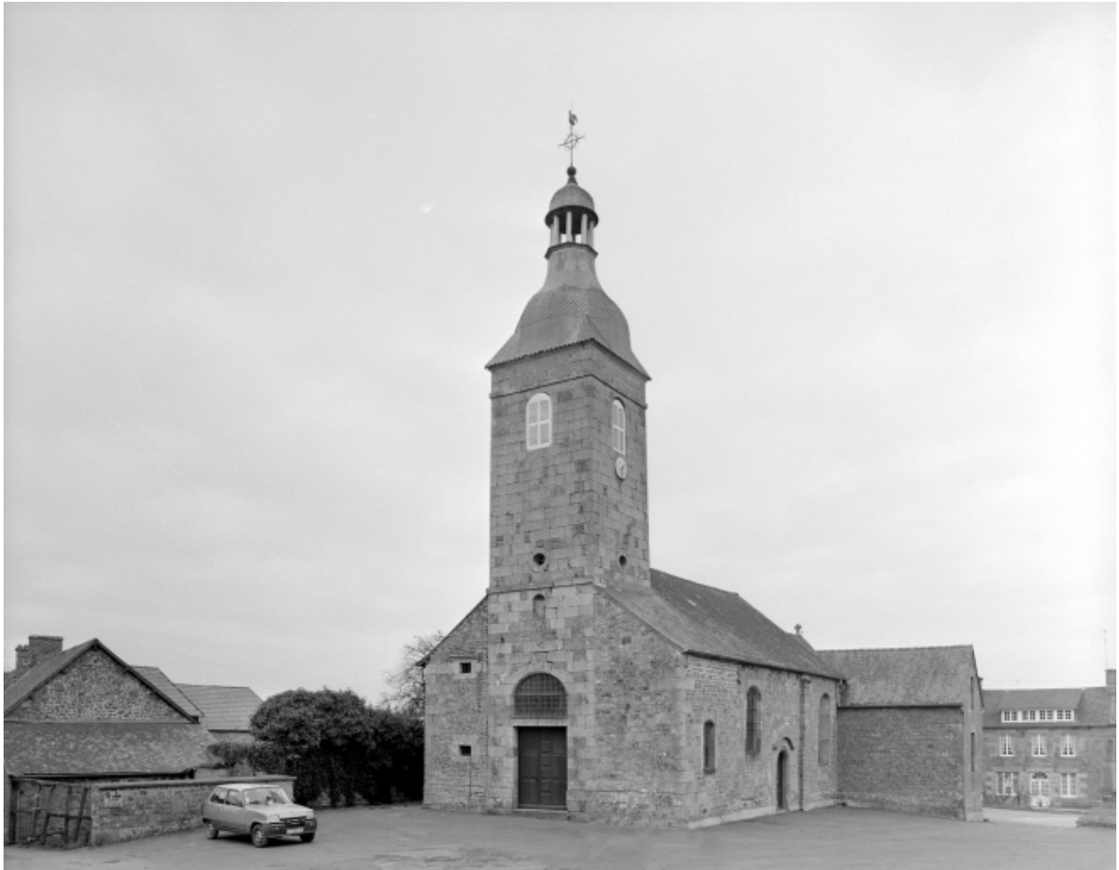
Elévation Sud-Ouest : vue générale
