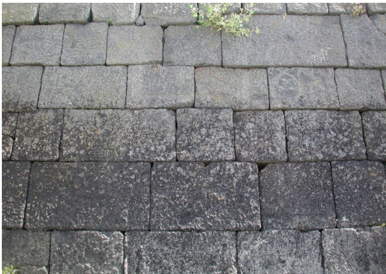
Vue de l'échelle à marée gravé dans le mur de quai : remarquer le chiffre 8 inscrit dans haut du mur de quai
