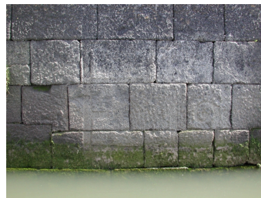
Vue de l'échelle à marée gravé dans le mur de quai : remarquer le chiffre 6 et le dessin inscrits dans le mur du quai Phot. Guy Prigent IVR53_20072206504NUCA
