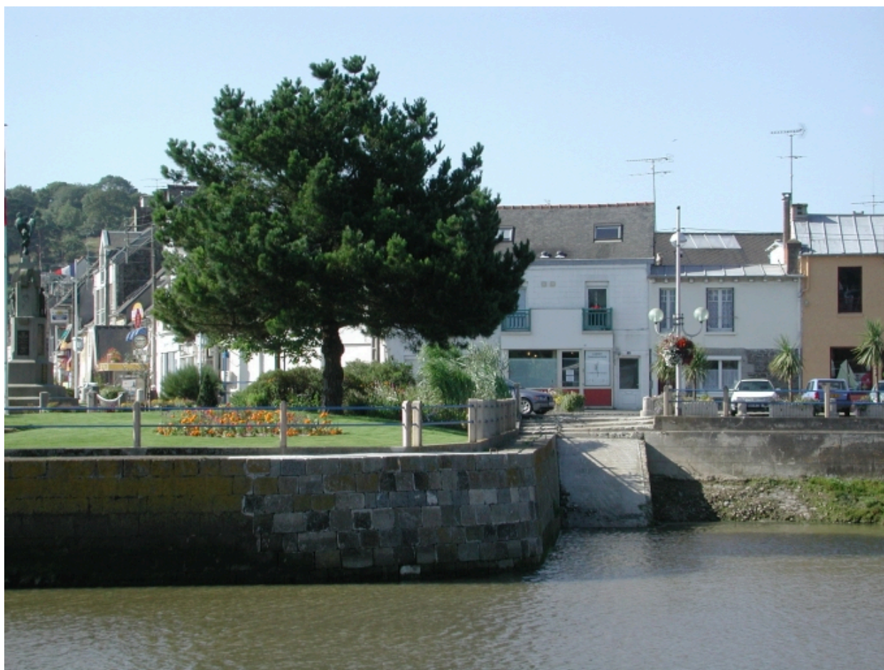
Le vieux quai, rive droite de l'Ic et son retour de quai en amont de l'ancien bassin du port, équipée d'une petite cale
