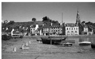
La cale de carénage en amont de l'ancien bassin, 3ème quart 20ème siècle (AD 22) Phot. Guy Prigent, Autr. Joël Jouas Poutrel IVR53_20072206271NUCB
