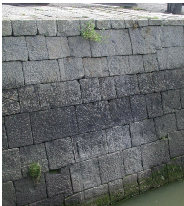
Vue de l'échelle à marée dans le bassin du vieux port : à l'extrémité sud, quai de Pordic : remarquer les chiffres 6 et 8 et le dessin en forme de T inscrit dans le mur du quai Phot. Guy Prigent IVR53_20072206503NUCA
