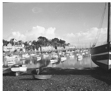
La cale de carénage et le vieux port vers 1950 (AD 22, Fonds Joël) Phot. Guy Prigent, Autr. Joël Jouas Poutrel IVR53_20072206309NUCB
