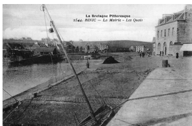
L'ancienne cale du quai Jean Bart, devant la place la Cloche, 1er quart 20ème siècle (collection particulière) Phot. Guy Prigent IVR53_20072206260NUCB
